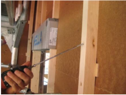
Figura 14.3: detalle de fijación de tornillo sobre rastrel.
