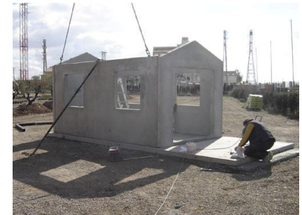
Figura 14.10: vivienda de hormigón prefabricado.
