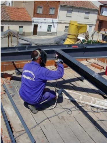
Figura 14.8: operario soldando perfiles metálicos.
