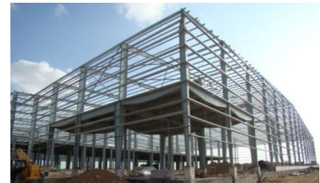
Figura 13.7: estructura formada por pórticos
