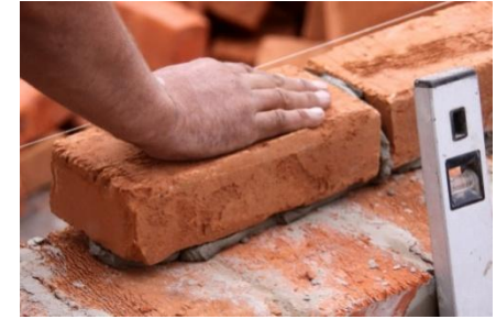
Figura 14.12: colocación de hilada de ladrillo.
