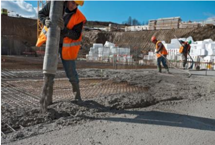
Figura 14.11: vertido de hormigón.
