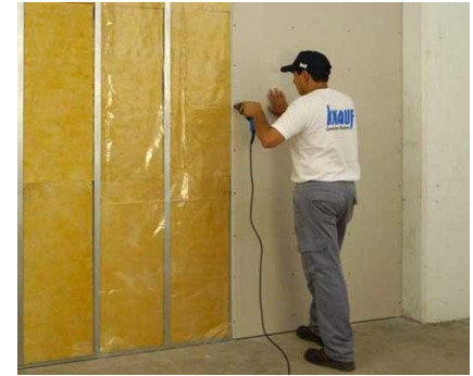
Figura 14.1: montaje de tabique de cartón yeso
