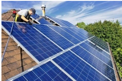
Figura 12.2: montaje de placas solares en cubierta.
