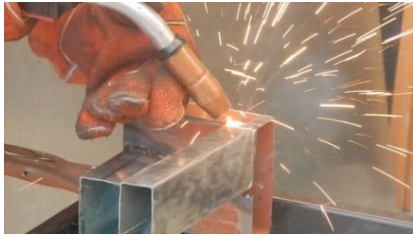
Figura 14.7: detalle de soldadura.
