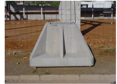
Figura 14.9: zapata de hormigón prefabricado.
