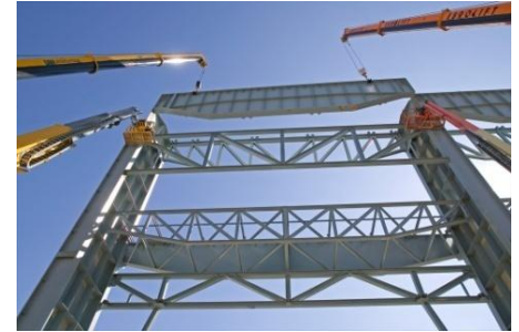
Figura 13.6: montaje de estructura metálica.
