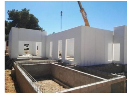
Figura 14.2: colocación vivienda de hormigón prefabricado
