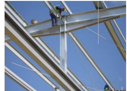
Figura 14.6: operario atornillando estructura.
