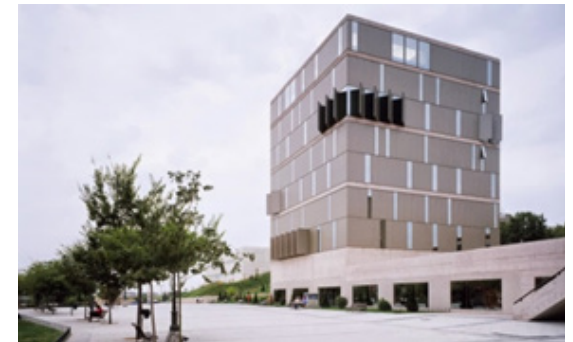
52. Abalos y Herreros. Biblioteca pública . 1995. Alzado donde se aprecia la composición en paneles móviles de la fachada.
