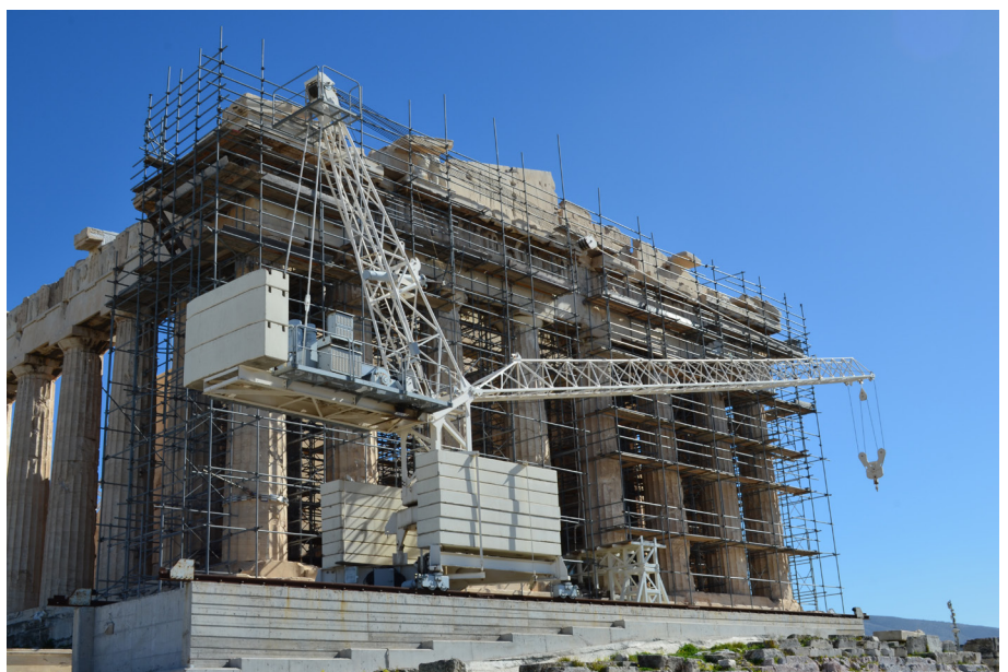
Figura 2. Andamiaje y grua empleadas en la intervención del Partenón en la Acrópolis, Atenas.
