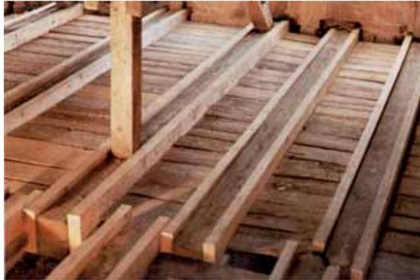
La fijación se realiza mediante tirafondos, la determinación del número y disposición de los mismos debe ser objeto de un cálculo detallado.
