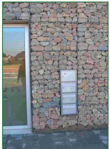
Los gaviones otorgan calidad a las obras, ya que presentan un acabado perfecto: estructura sin deformaciones, aristas y gradas rectilíneas y planas, posibilidad de construir superficies redondeadas, escaleras, posibilidad de utilización en el relleno de numerosos materiales: bolos, piedra, madera, ladrillos, etc.
