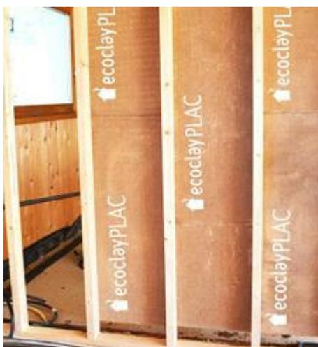
Ilustración 71. Ejecución de placas de arcilla para particiones interiores. Fuente: Ecoclay
