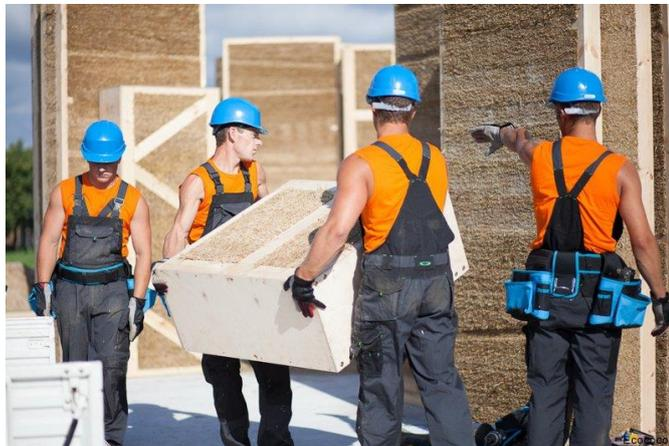
Ilustración 65. Colocación de paneles de paja para cerramiento. Fuente: Ecococon
