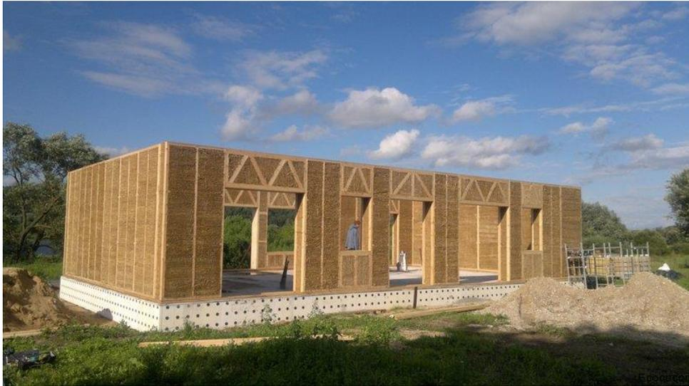
Ilustración 64. Cerramiento de una vivienda con paneles de paja. Fuente: Ecococon
