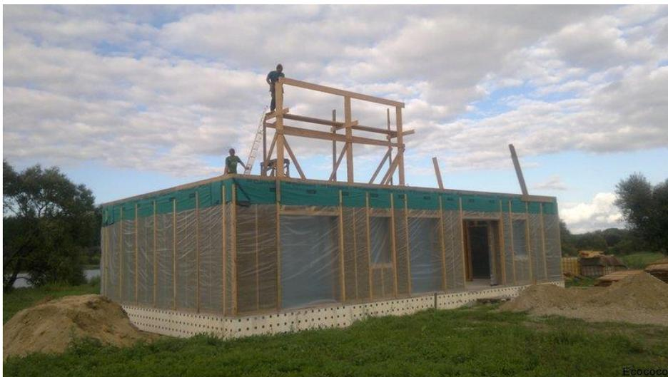
Ilustración 66. Cerramiento con acabado protector de paneles de paja. Fuente: Ecocon
