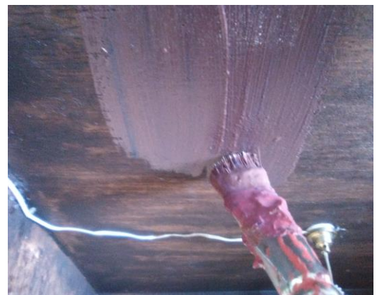
Imagen nº25. Pintado de los techos cuidando de tapan los cables de la luz.
