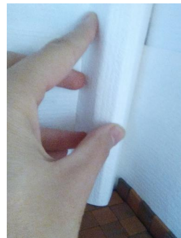
Imagen nº8. Realización de la columna del baño.
