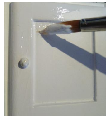
Imagen nº14. Pintado de los muebles de la cocina.
