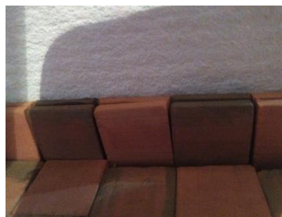
Imagen nº7. Realización del rodapié del baño con teselas de cerámica.
