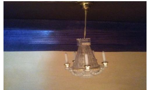
Imagen nº24. Colocación de la lámpara del dormitorio.
