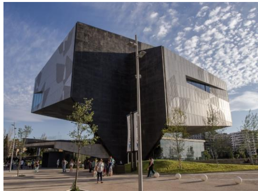
Fig.20. CaixaForum Zaragoza, Carme Pinós. Fuente: <Wikimedia Commons>. Imágenes de libre uso
