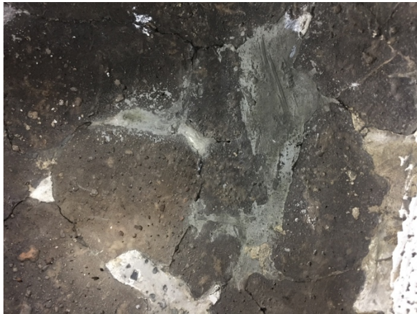
Figura 33. Proceso de eliminación del estuco grisáceo interior.
