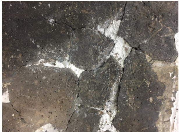
Figura 34. Eliminación total del estuco grisáceo interior.
