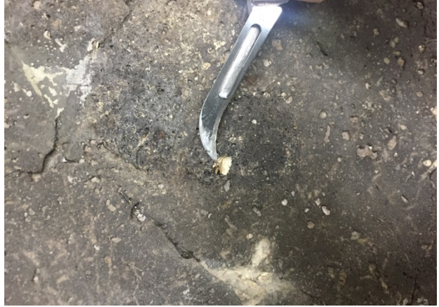
Figura 32. Eliminación de los restos de papel del interior.
