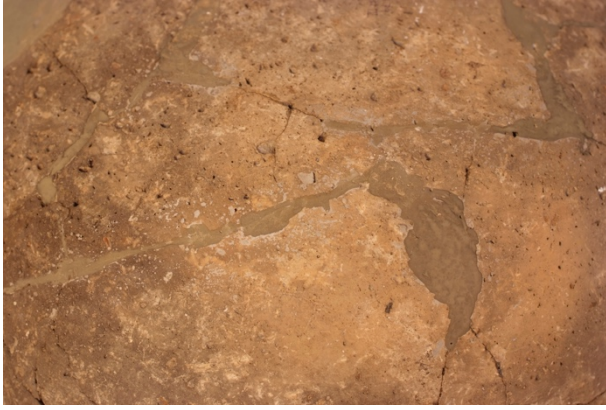
Figura 23. Detalle de la reintegración de grietas.
