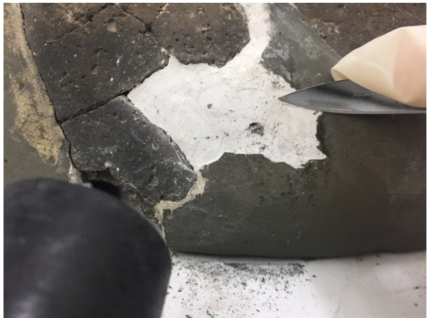
Figura 28. Eliminación del estuco grisáceo..
