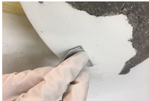
Figura 38. Lijado de las lagunas.
