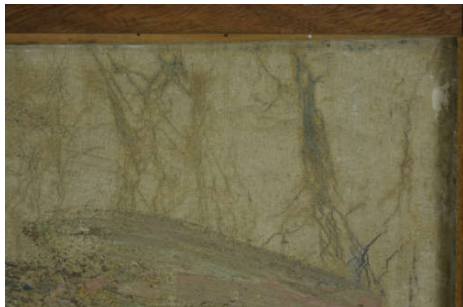
Imagen 28. Craqueladuras por exceso de disolvente.
