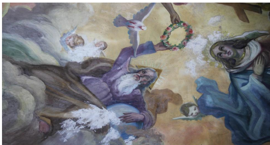
Fig. 69. Estucado de lagunas en la cúpula con Modostuc®
