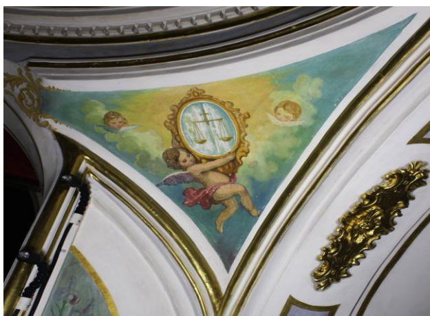
Fig. 73. Aspecto de una zona de la Pechina 3 antes de reintegrar.
