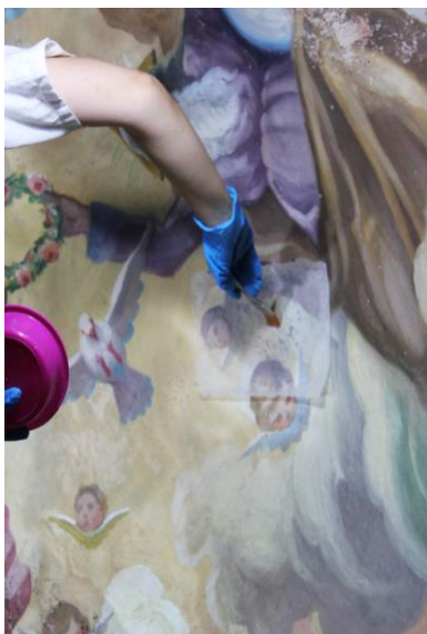
Fig. 67. Consolidación de pulverulencia en la cúpula.
