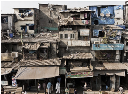
Imagen 3.3. Viviendas en Bombay, India.
