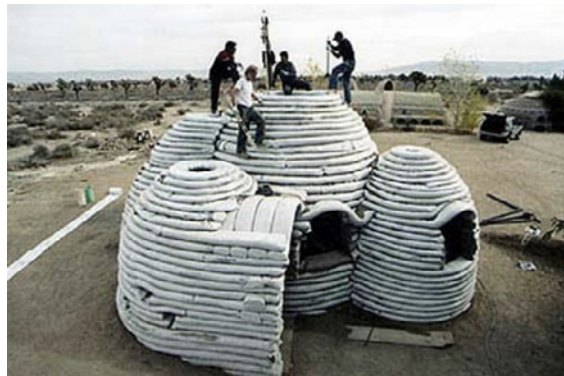
Imagen 5.24. Superadobe. Construcción. Cal-Earth, Irán 1995.
