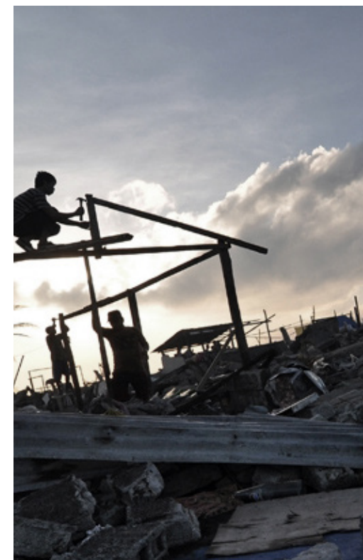
Imagen 3.8. Reconstrucción tras tormenta, Filipinas.
