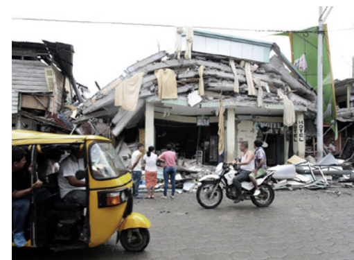
Imagen 7.3. Edificios derribados debido al terremoto en Ecuador 2016.
