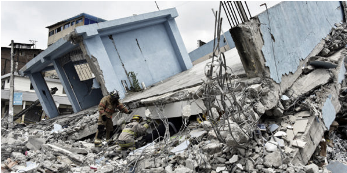
Imagen 7.12. Edificios derribados debido al terremoto en Ecuador 2016.
