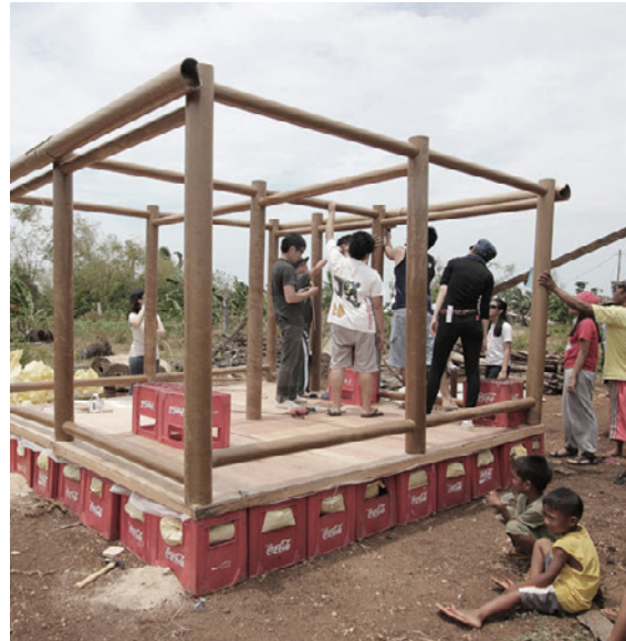
Imagen 7.23. Paper Log Houses. S. Ban. Filipinas, 2014.
