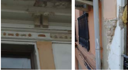
Fig. 1. Detalles de la fachada en su estado original
