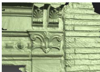
Fig. 6. Toma de la fachada con escáner SENSE de 3D Systems
