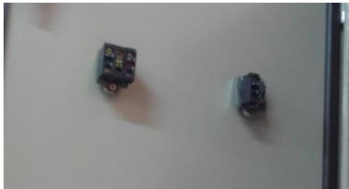
**Figura 4.2.1.1** *Interruptores de avance, retroceso y marcha del antiguo cuadro eléctrico.*
