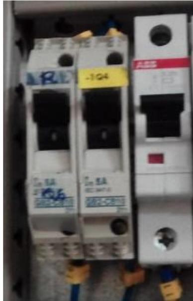
**Figura 4.2.1.5** Interruptores magnetotérmicos ABB y Schneider de 3 y 5 Amperios.
