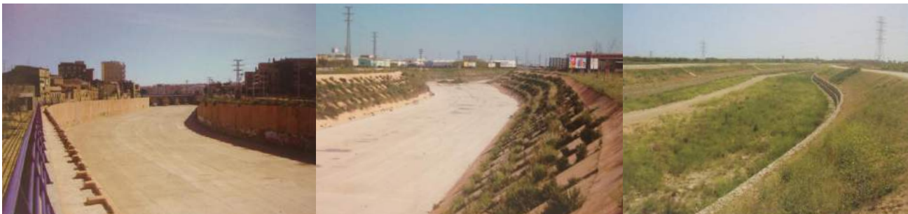
Fig 7: Trams canalitzats del barranc del Poyo o de Xiva. L'antropització del llit disminueix amb la proximitat a l'Albufera. A la vista tenim el tram 2, 3 i 4, els que condicionen les immediacions de Catarroja. FONT: MINISTERIO DE MEDIO AMBIENTE, CONFEDERACIÓN HIDROGRÁFICA DEL JÚCAR (2007) Barranco del Poyo: Un cauce hacia los sentidos (2007). Ed: CHJ
