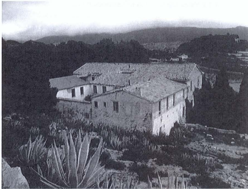
Imagen actual de las cubiertas del edificio
