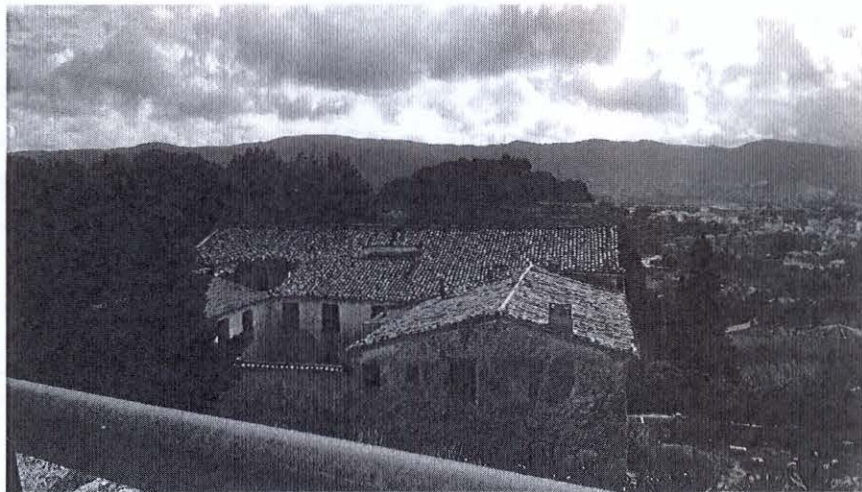
Imagen actual de las cubiertas del edificio
