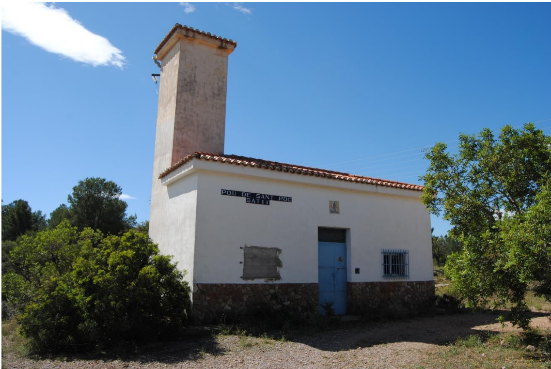
Pozo de agua San Roc Fuente: Elaboración propia
