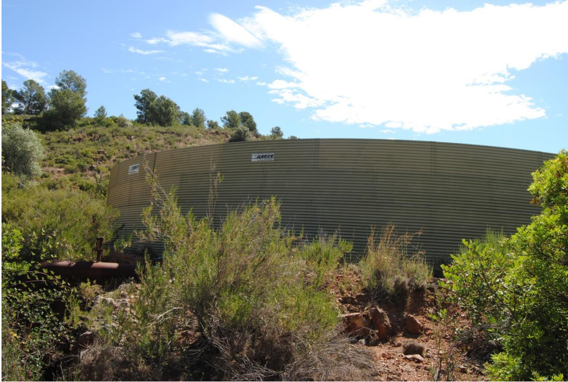
Depósito de agua de uso múltiple para helicópteros Fuente: Elaboración propia
