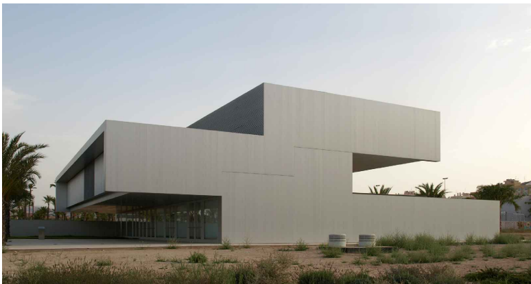
[Fig.06]: EDIFICIO QUORUM, JAVIER GARCÍA-SOLERA VERA Y ERNESTO MARTÍNEZ ARENAS
