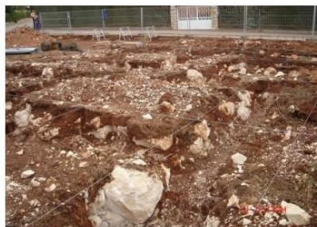
Ilustración 1.6.1.1 Trazo y marcado del terreno. (Fuente: Internet)
