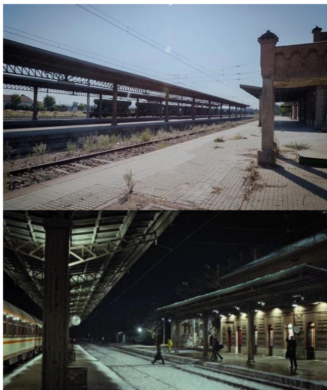
Imagen 8: en la imagen superior de la composición fotográfica podemos ver la estación de Algodor (Toledo) en un su estado actual. Fuente: elaboración propia. En la imagen inferior podemos ver el frame de la película y como quedó el set de la estación para la grabación del plano. Fuente: película Julietta .
