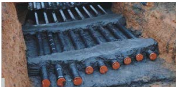
Figura 2. Hormigonado con 12 cables entubados.
