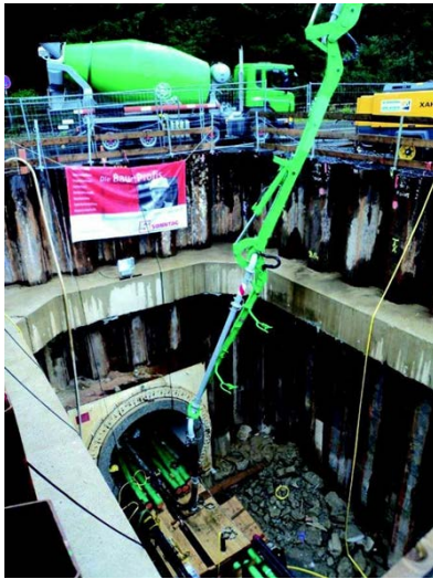
Figuras 11 y 12. El hormigón fue bombeado a más de 24m en vertical y con longitudes de bombeo en horizontal de hasta 650m. La altura disponible para trabajar en el túnel era de 1.13 m. Fotos: HeidelbergCement AG / Steffen Fuchs / E. Vargas
