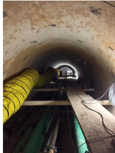
Figuras 11 y 12. El hormigón fue bombeado a más de 24m en vertical y con longitudes de bombeo en horizontal de hasta 650m. La altura disponible para trabajar en el túnel era de 1.13 m. Fotos: HeidelbergCement AG / Steffen Fuchs / E. Vargas
