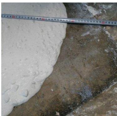
Figura 5. Frente de avance del HAC
