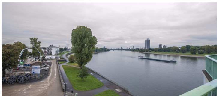
Figura 6. Desde mediados de 2016, la nueva galería suministra el distrito del Ruhr con el calor generado a partir de la nueva central eléctrica Niehl
