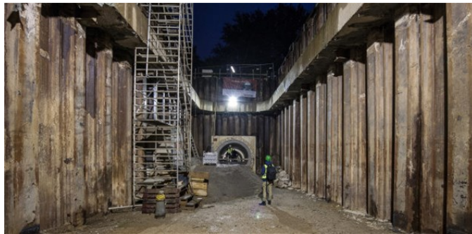
Figura 8. Entrada a la boca del túnel con muro de contención Foto: HeidelbergCement AG / Steffen Fuchs
