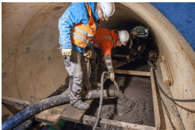
Figura 10. Las cavidades en el túnel se llenaron de 1.300 metros cúbicos de Powercrete. Foto: HeidelbergCement AG / Steffen Fuchs
