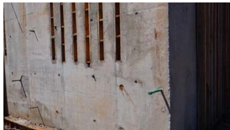
(b) aspecto da parede com concreto autoadensável.
