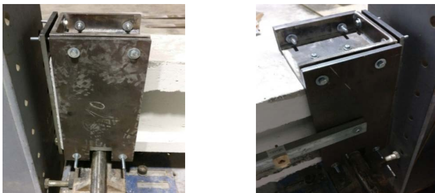
Figura 6. Chapas metálicas para o confinamento dos apoios
