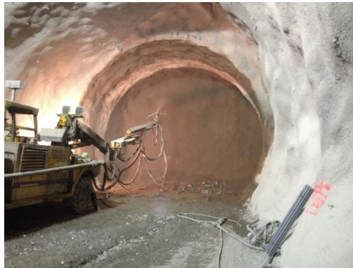
Figura 1. Proyección de FRS en una faena minera en Chile.
