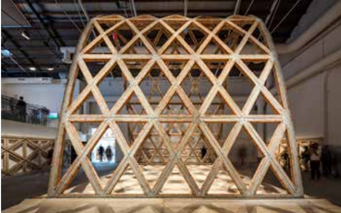
90 92 91 90. La bóveda se construye sobre una estructura de madera que actúa de encofrado. 91. Para su construcción se emplean tres módulos distintos, 92. Detalle de la unión entre los distintos módulos prefabricados.
