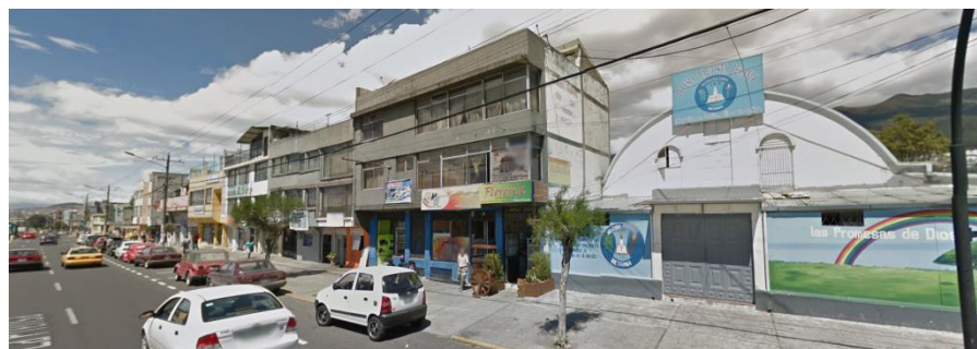
Figura 95 Vista de usos sobre Av. Amazonas Fuente: Google Earth, Nov 2016
