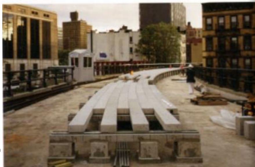
Figura 45 Proceso de construcción del High Line Fuente: (David, y otros, 2011)
