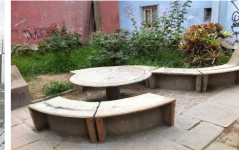
Imagen 109 A pesar de utilizar materiales económicos (sin muchos acabados) y resistentes (como el hormigón y barras de acero), no afectan el diseño del mobiliario urbano.
