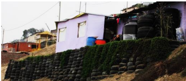
Imagen 146 Construcción de muros de contención con llantas.
