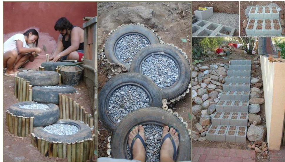
Imagen 171 Escaleras con neumáticos y piedra o bloques de hormigón con tierra. Fuente: (DETALLE FEMENINO, 2013) y (TARINGA, 2015)
