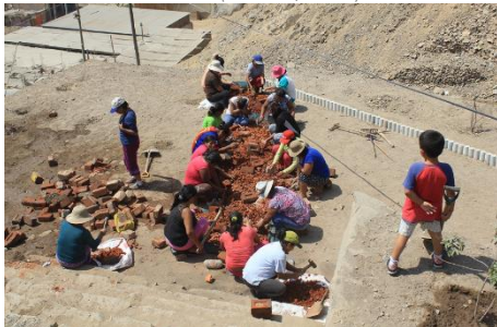
Imagen 162 Pavimentos de ladrillo chancado. Fuente: (TOMÁS, 2015)
