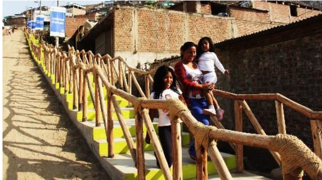
Imagen 145 Construcción de escaleras en asentamientos humanos.
