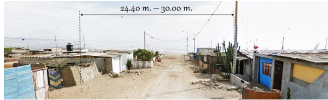
Imagen 142 Vía secundaria con dimensiones. Fuente: Elaboración propia en base a imagen de Google Street View
