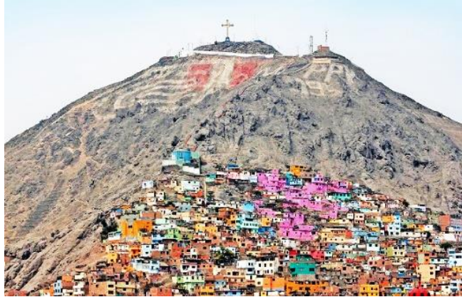
Imagen 159 Invasión de terrenos para convertirlos en asentamientos humanos.
