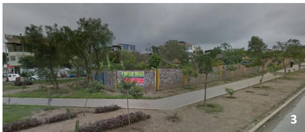
Imagen 82 Planta de tratamiento de aguas servidas para Villa el Salvador - Alameda de la juventud, Lima.
