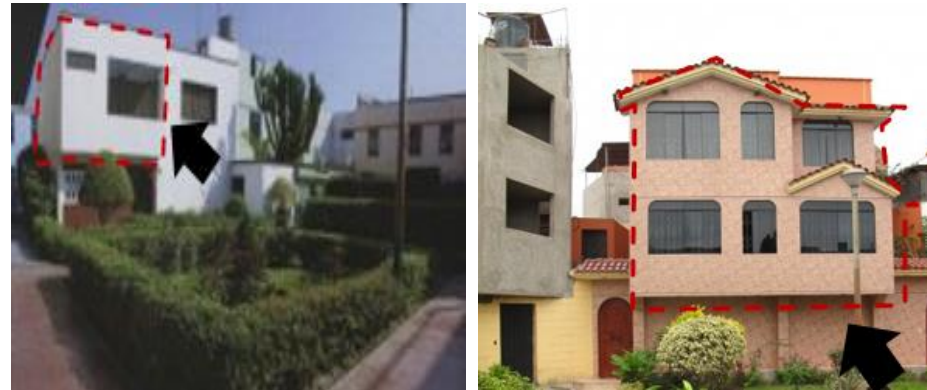
Imagen 104 Transformaciones negativas de la imagen urbana (voladizos y techos a dos aguas innecesarios), que no respetan el sistema constructivo original. Fuente: (RAMIS, 2012) - (GARCÍA, 2008)
