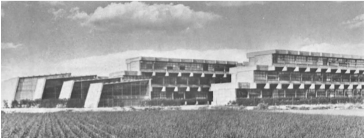
Fig.2.3. Vista lateral de la edificación Hogar y arquitectura nº83, (1969)
