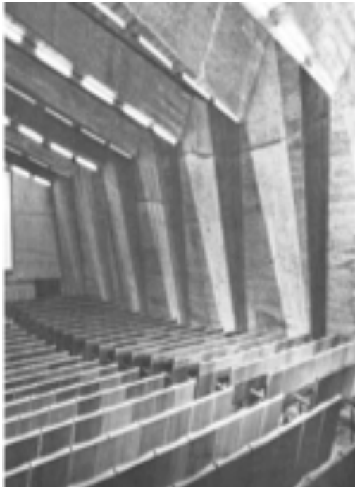
Fig.3.15 Vista interior de las láminas plegadas Tipo C Hogar y arquitectura : revista bimestral de la Obra Sindical del Hogar, n° 83,p. 49, 1969
