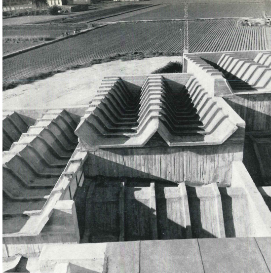
Fig.4.1 Vista superior de láminas plegadas en auditorio.
