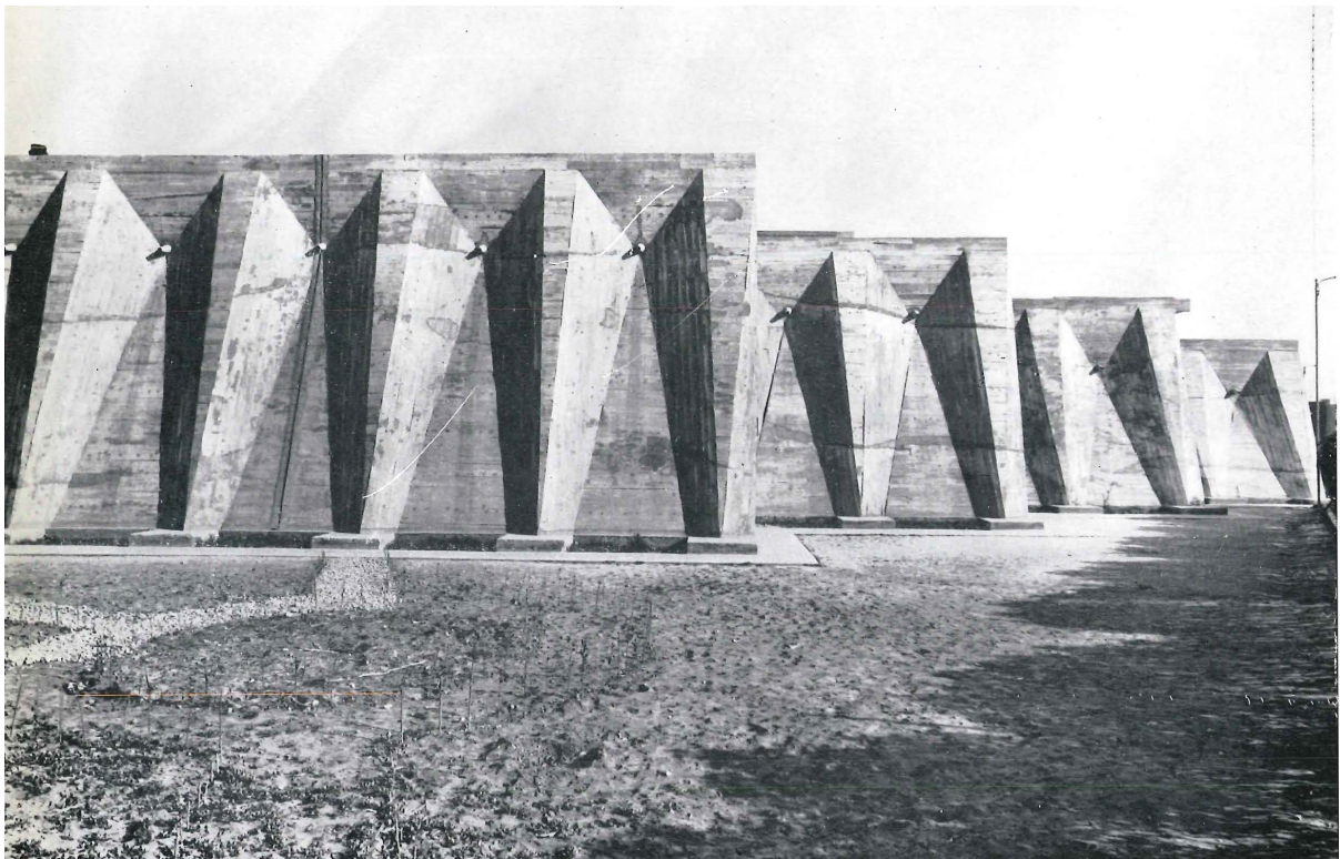
Fig.2.30. Construcción de láminas plegadas en el salón de actos.
