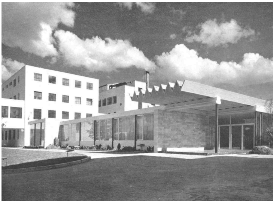
Fig.2.23 Vista exterior de los Laboratorios Alter. Recuperado de :Informes de la Construcción Vol. 14, no 132 Junio, julio de 1961
