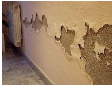
Imágenes 40 y 41: Ejemplos de humedades en edificación. A la izquierda, humedades en fachada. A la derecha, desconchados provocados por las humedades en el interior de una vivienda.
