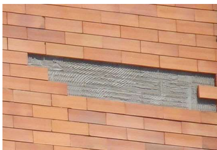
Imágenes 35 y 36: Desplomes de fragmentos de la fachada (en elementos de voladizo o la propia fachada).
