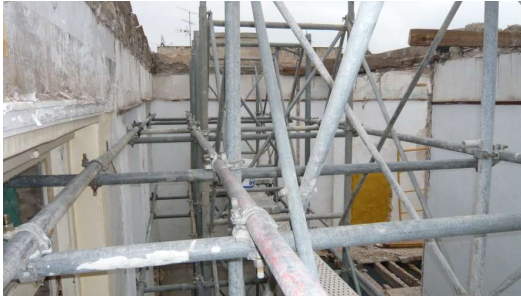
Imagen 32: Arriostamiento entre fachada y estructura metálica visto desde el interior del edificio (antes de proceder al derribo de la estructura interna).
