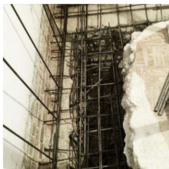
Imagen 43: Modificación del sistema de cimentación de un edificio en rehabilitación.
