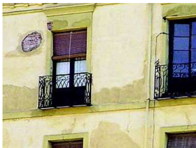
Imágenes 40 y 41: Ejemplos de humedades en edificación. A la izquierda, humedades en fachada. A la derecha, desconchados provocados por las humedades en el interior de una vivienda.
