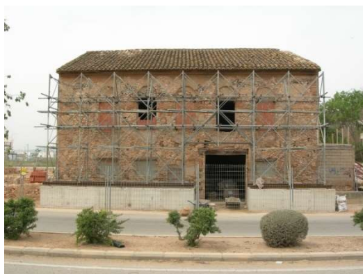
Imagen 74: Vista frontal del estabilizador de fachada una vez finalizado el montaje de la estructura metálica.
