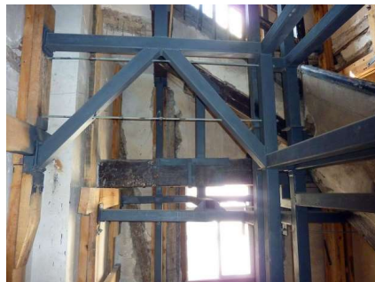
Imagen 10: Apeo de conjunto (entramado de acero).
