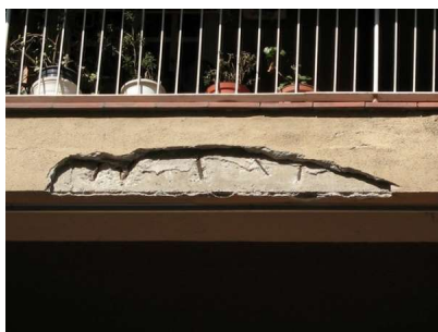
Imágenes 35 y 36: Desplomes de fragmentos de la fachada (en elementos de voladizo o la propia fachada).
