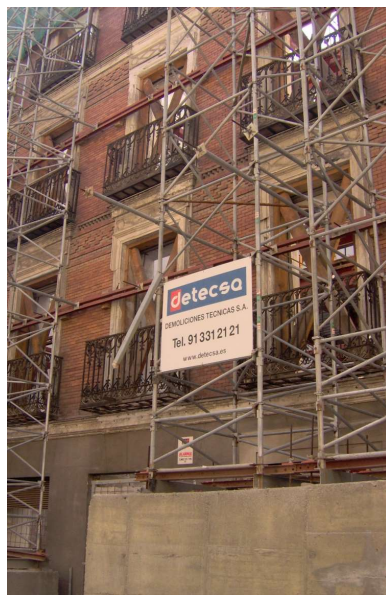
Imagen 17: La estructura metálica del estabilizador transmite los momentos de vuelco y fuerzas horizontales al lastre ubicado en la parte inferior y al que irá debidamente anclado.
