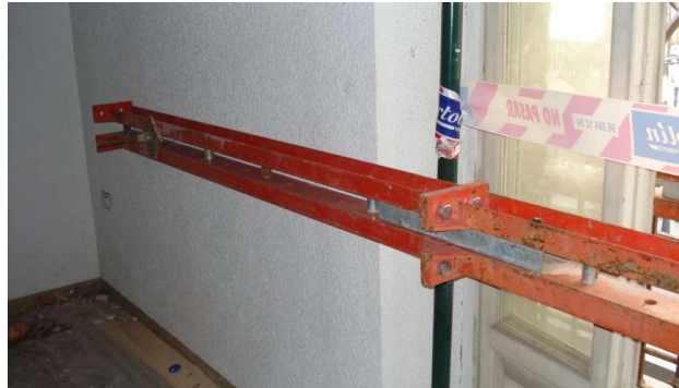
Imagen 32: Arriostamiento entre fachada y estructura metálica visto desde el interior del edificio (antes de proceder al derribo de la estructura interna).
