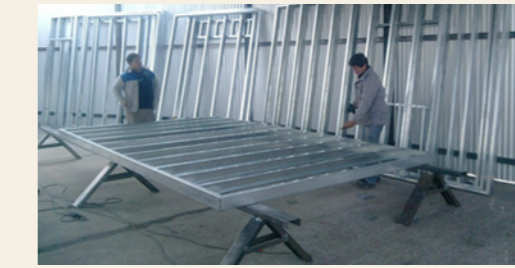
Muntatge en taller (Steel Framing)
