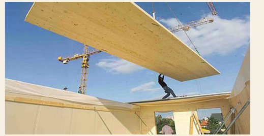
Muntatge en obra (Taulers KUH®)
