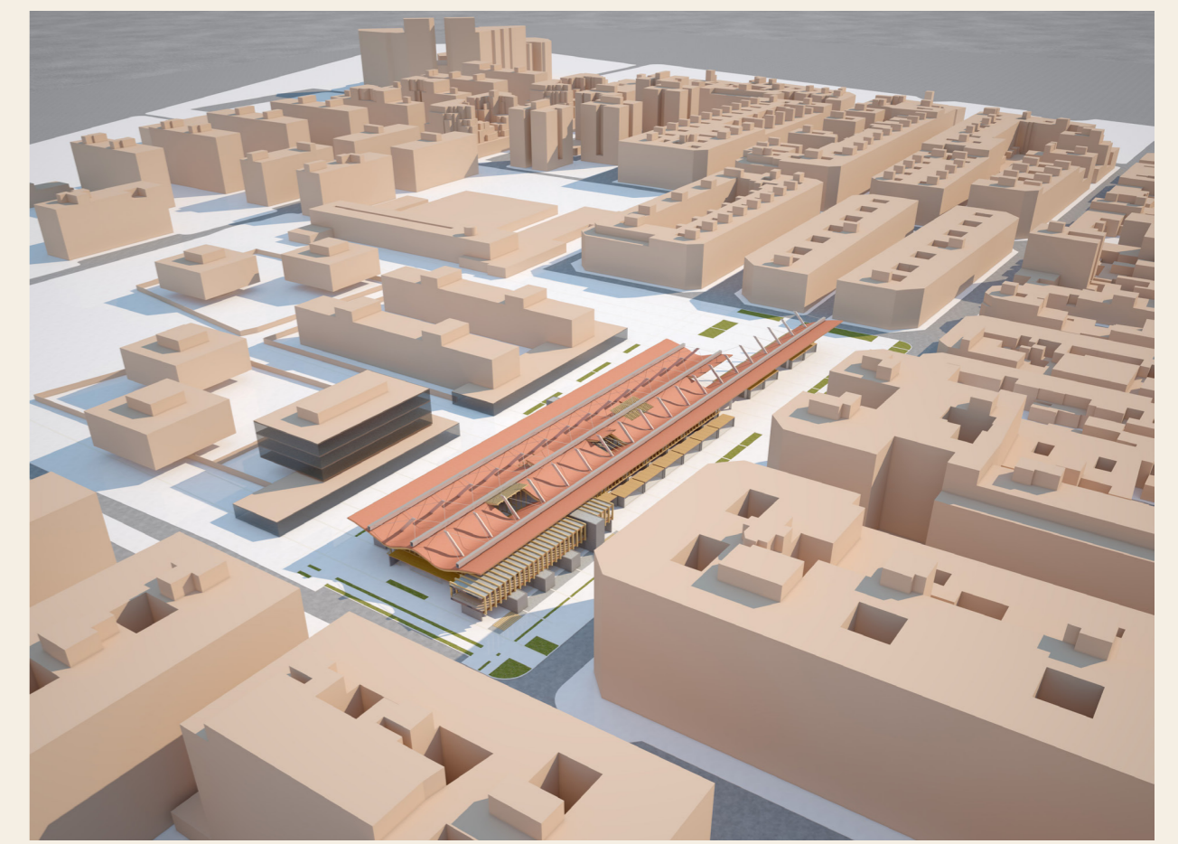
Vistes aèries de l'actuació
