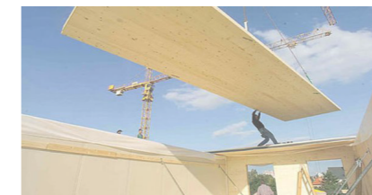
Montatge panells contralaminats KLH®
