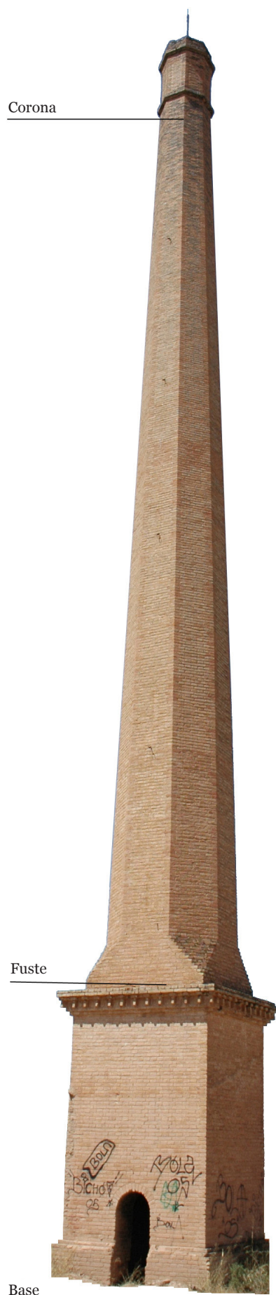
Figura 1. Chimenea de Casinos (Valencia).
