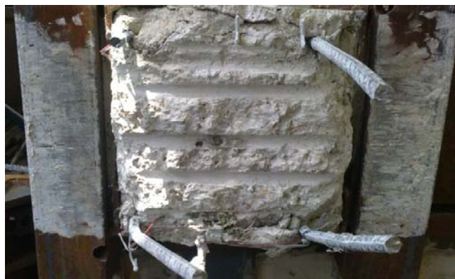
Fig. 6.15. Lijado de las corrugas en el hormigón marcadas por las armaduras
