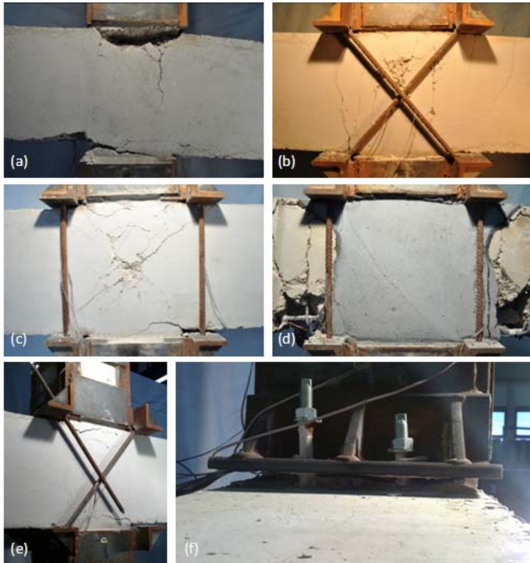
Fig. 6.23. Fotografías de los principales modos de fallo. a) fallo por flexión en uniones soporte-nudo (espécimen A.W.L0-2). b) fallo por flexión positiva y negativa en vigas (espécimen A.DB.L1-1). c) fallo por cortante en el nudo (espécimen S.VB.L0-1). d) fallo trasladado a las vigas tras la reparación espécimen (espécimen A.VB.L1-R). e) fallo por tracción de barras las exteriores (espécimen S.DB.L0-1). f) fallo por arrancamiento del taco químico (espécimen A.CA.L0-2)
