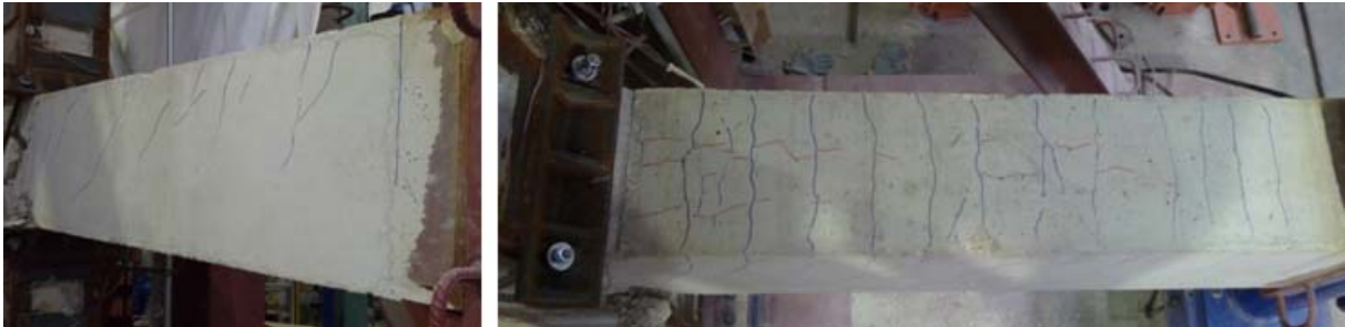
Fig. 6.19. Fisuras de flexión en una viga de la probeta A.DB.L1-2
