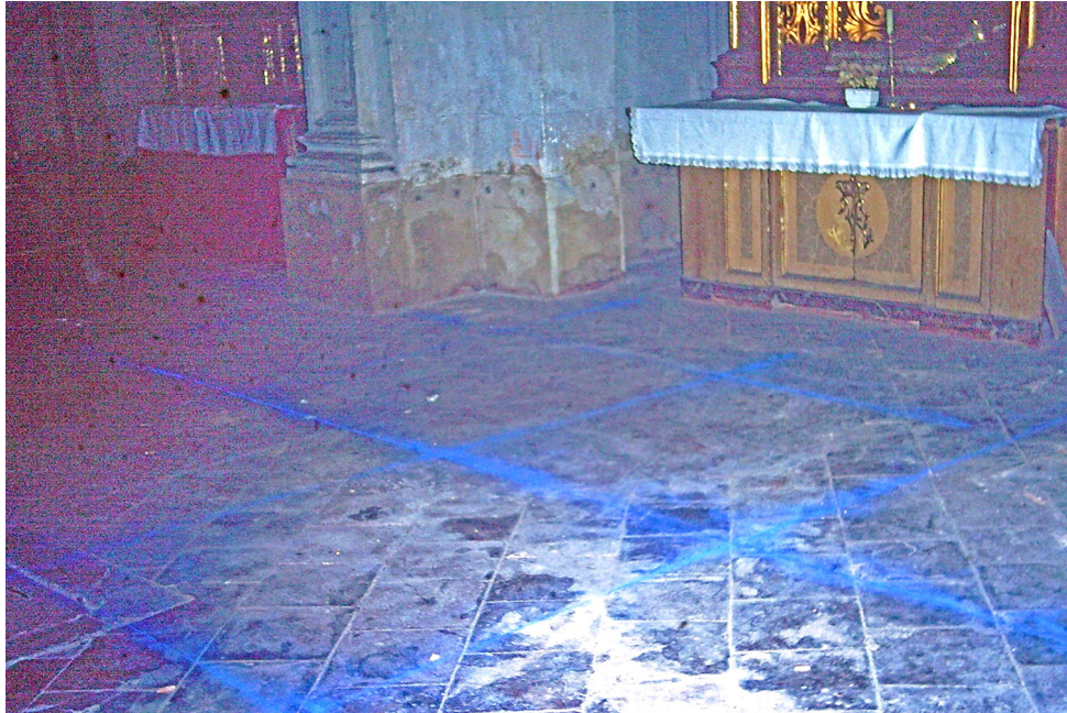
Fig. 5.2.: Suelo Iglesia de San Pablo de los Jesuitas. I.N.E.M. Luis Vives. Valencia. Investigación realizada con este procedimiento. Malla dibujada con tiralíneas y azulete. No se pudieron utilizar las juntas del pavimento como malla por encontrarse colocado girado 45°. Fuentes propias.
