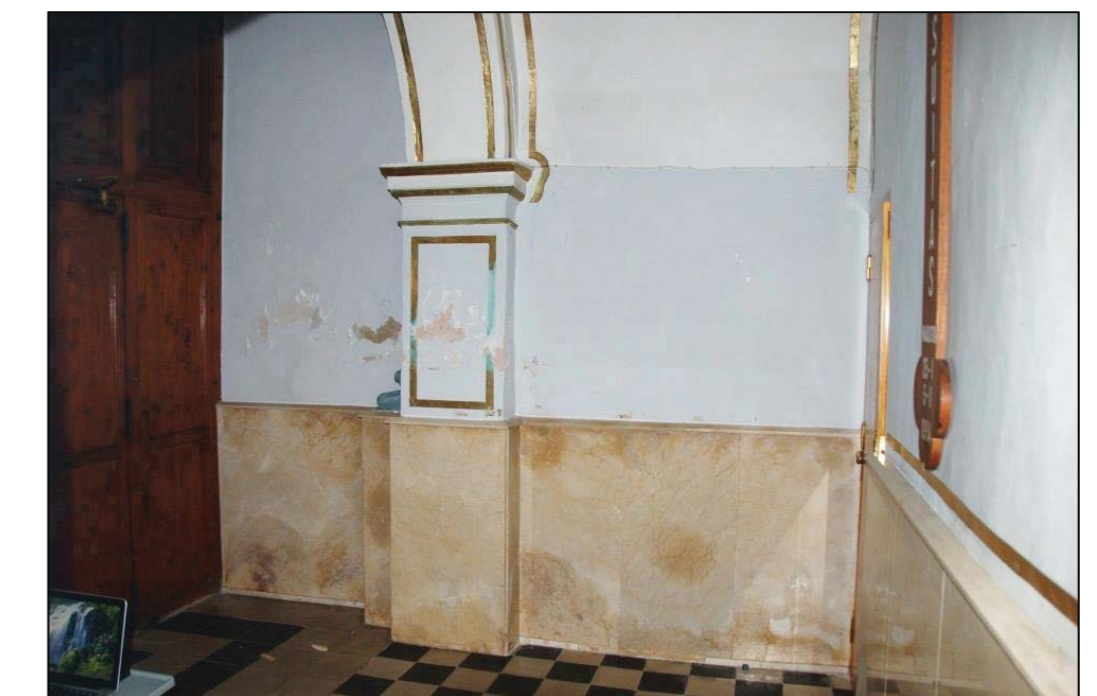
Interior -Vista de muro izquierdo de fachada junto a entrada.
