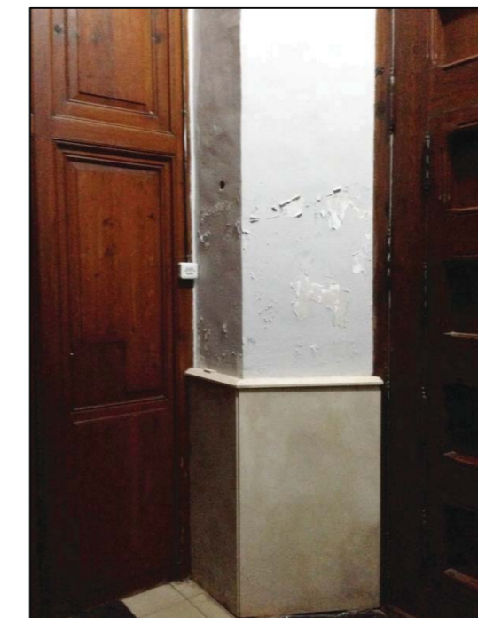
Interior -Vista de muro izquierdo en vestíbulo de entrada
