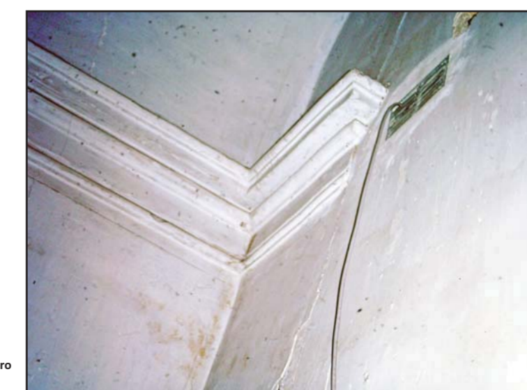
Rejilla de ventilación/aireación Knapen colocada en la parte superior muro a cara interior del muro.
