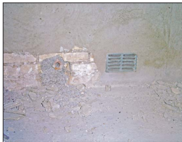
Rejilla de ventilación/aireación Knapen colocada en la parte inferior muro a cara interior del muro.
