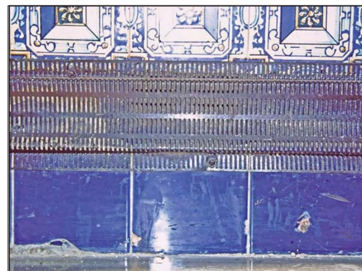
Rejilla metálica que oculta perforaciones en muro para ventilación colocada en cara extraer de muro recayente al Claustro del Instituto.
