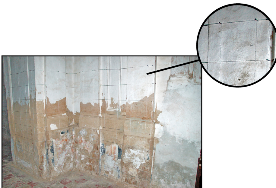
Fig. 5.3.: Muro de la Cartuja Ara Christi, El Puig, Valencia. Investigación realizada con este procedimiento. Malla formada con lienzas tensadas en clavos colocados perimetralmente. Fuentes propias.
