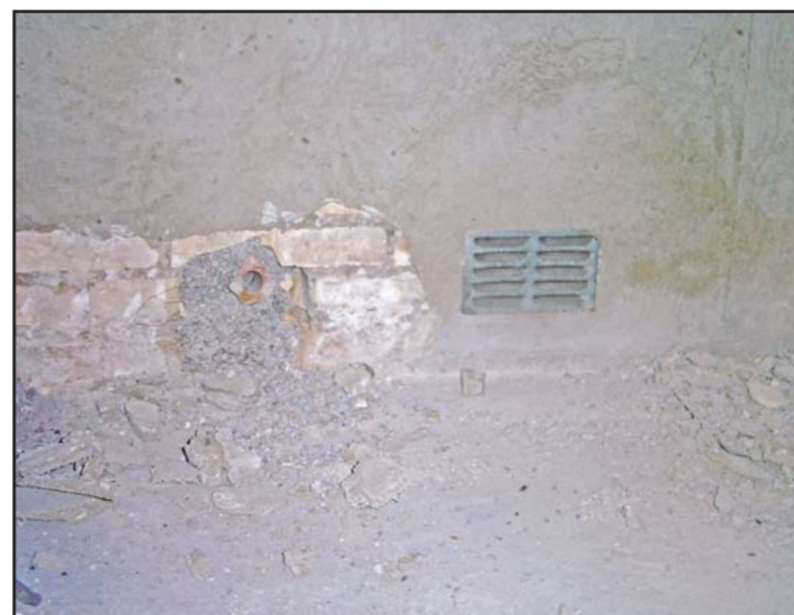
Rejilla de ventilación/aireación Knapen colocada en la parte inferior muro a cara interior del muro.
