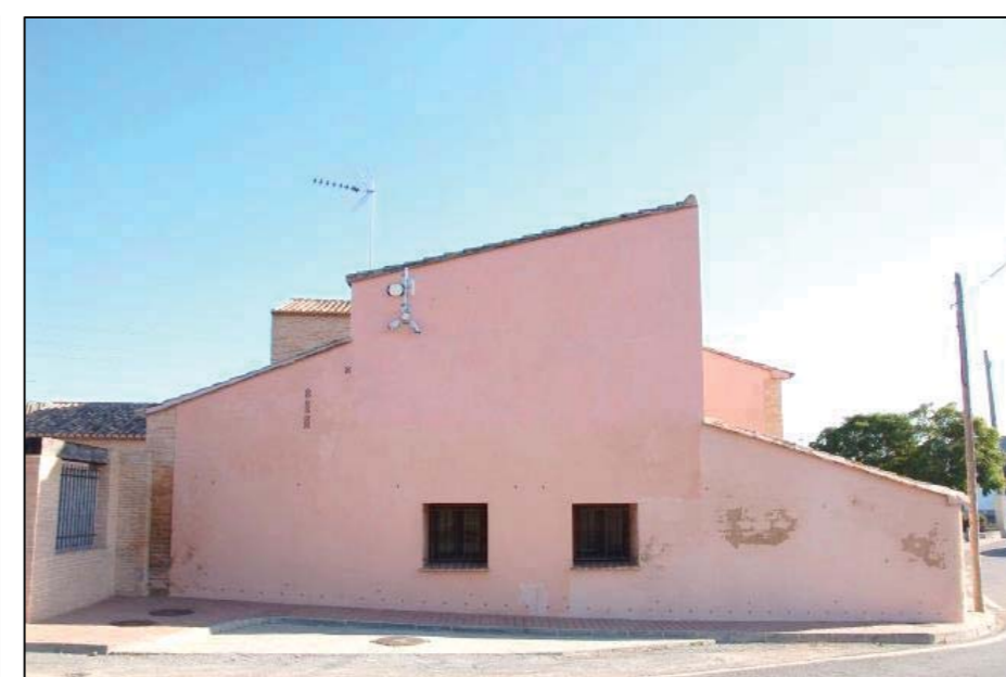
Exterior Agromuseo de Vera-Vista de fachada oeste.
