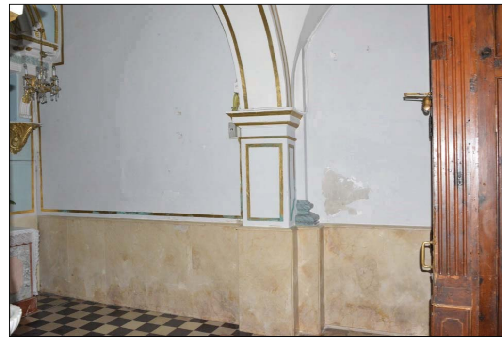
Interior -Vista de muro izquierdo de fachada junto a entrada.
