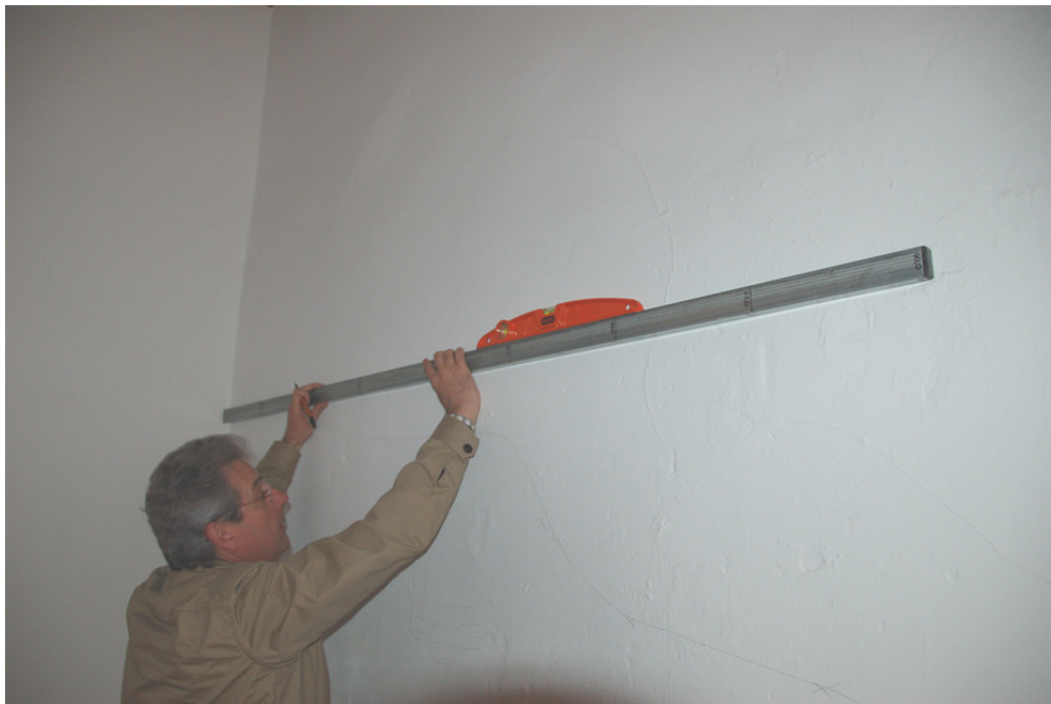
Fig. 5.5.: Muro medianero en planta baja, C/ Acequia nº 49, Pedralba, Valencia. Investigación realizada con este procedimiento. Malla virtual tomada con regle aplomado y grafiado con el paso de la malla. Fuentes propias.
