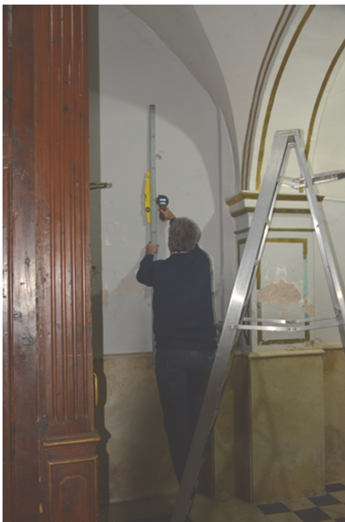
Fig. 5.6.: Muro Iglesia Ntra. Sra. de la Encarnación de Náquera, Valencia. Investigación realizada con este procedimiento. Malla virtual tomada con regle aplomado y grafiado con el paso de la malla. Fuentes propias.
