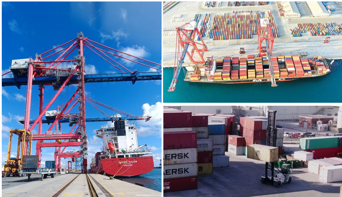
Figura 6.18: Terminal de contenedores del puerto de Limasol (EGCTL)
