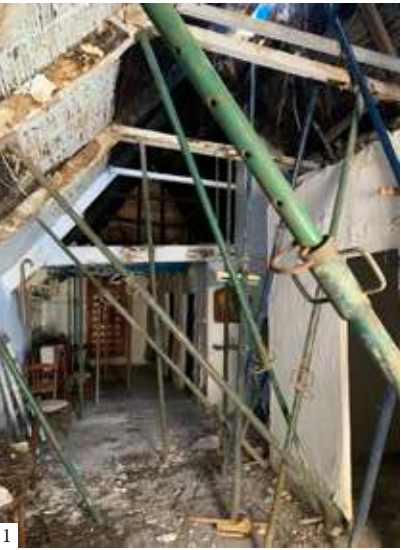
1: Interior of the cottage before restoration 2: Ridge beam of the cottage, displaced due to the lateral walls’ collapse under the thrust of the rafters 3: Detail showing the widespread condition of termite-damaged wood | 1: Interior de la barraca antes de la restauración 2: Cumbrera de la barraca, abierta por el desplome de los muros laterales bajo el empuje de los pares 3: Detalle del estado generalizado de la madera atacada por termitas | 1: Interior da cabana antes da restauração 2: Cumeeira da cabana, aberta pelo desabamento das paredes laterais sob o empuxo dos pares 3: Detalhe do estado generalizado da madeira atacada por térmitas
