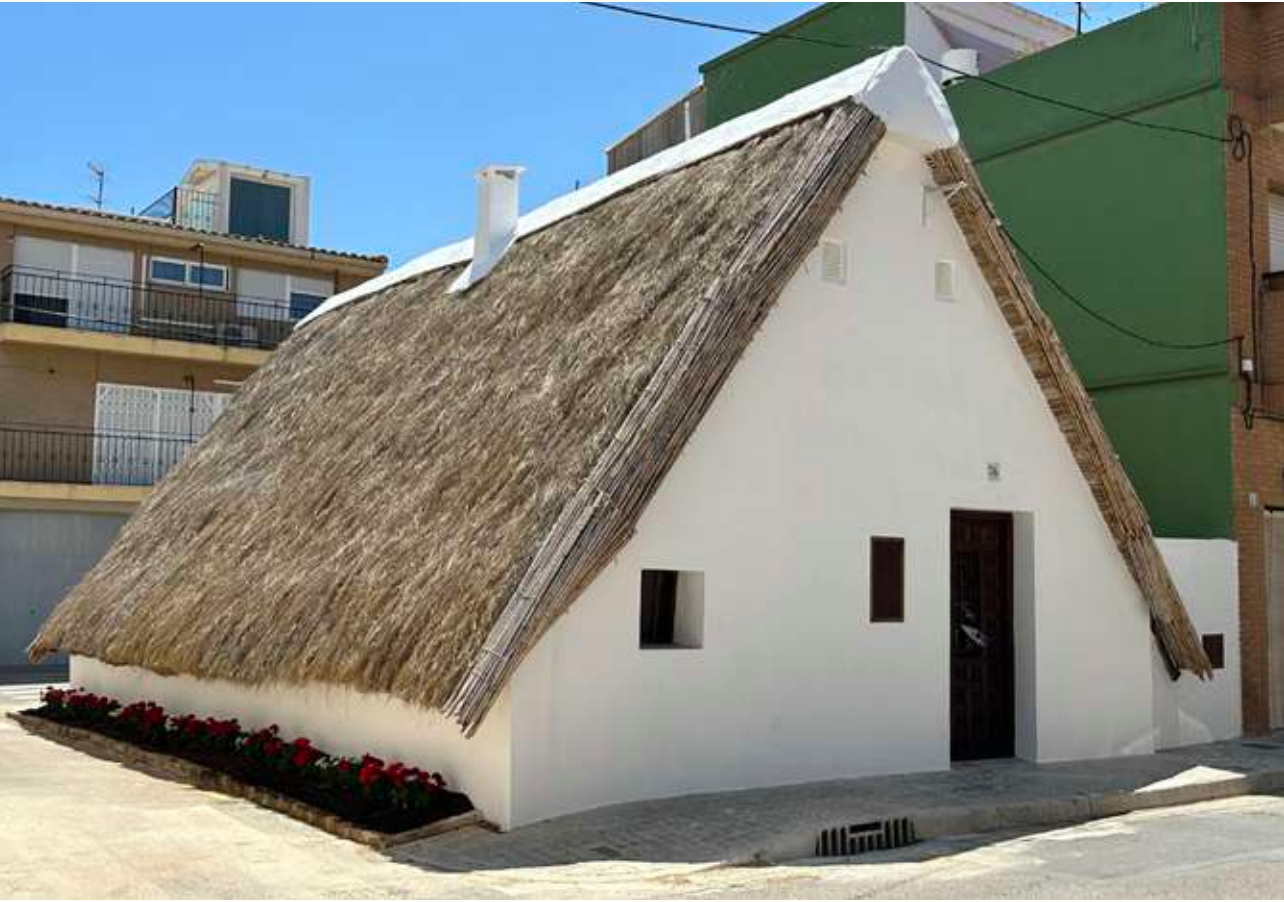
The cottage after restoration, seen from the west | La barraca después de la intervención vista desde el oeste | A cabana depois da intervenção vista desde o oeste
