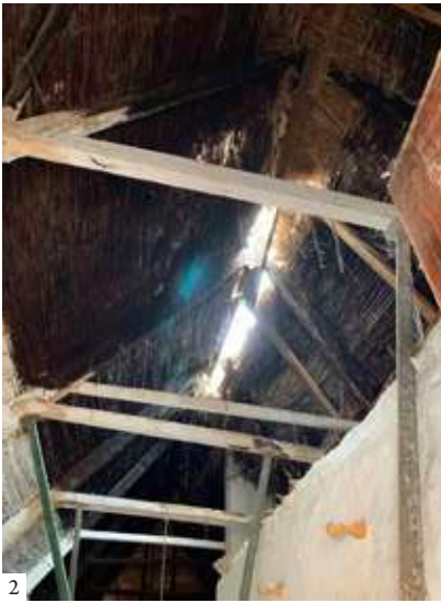
1: Interior of the cottage before restoration 2: Ridge beam of the cottage, displaced due to the lateral walls’ collapse under the thrust of the rafters 3: Detail showing the widespread condition of termite-damaged wood | 1: Interior de la barraca antes de la restauración 2: Cumbrera de la barraca, abierta por el desplome de los muros laterales bajo el empuje de los pares 3: Detalle del estado generalizado de la madera atacada por termitas | 1: Interior da cabana antes da restauração 2: Cumeeira da cabana, aberta pelo desabamento das paredes laterais sob o empuxo dos pares 3: Detalhe do estado generalizado da madeira atacada por térmitas
