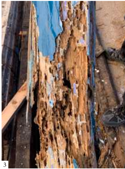
1: Interior of the cottage before restoration 2: Ridge beam of the cottage, displaced due to the lateral walls’ collapse under the thrust of the rafters 3: Detail showing the widespread condition of termite-damaged wood | 1: Interior de la barraca antes de la restauración 2: Cumbrera de la barraca, abierta por el desplome de los muros laterales bajo el empuje de los pares 3: Detalle del estado generalizado de la madera atacada por termitas | 1: Interior da cabana antes da restauração 2: Cumeeira da cabana, aberta pelo desabamento das paredes laterais sob o empuxo dos pares 3: Detalhe do estado generalizado da madeira atacada por térmitas
