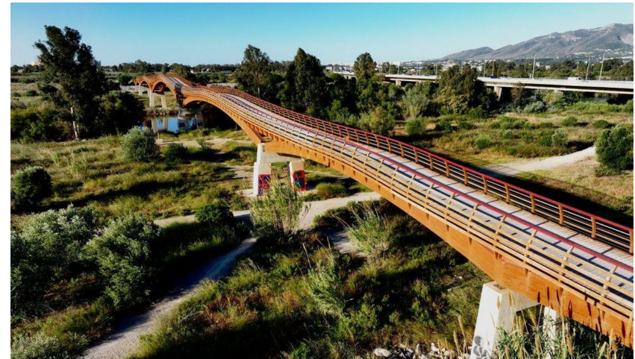
Figura 9: Pasarela de madera sobre el río Guadalhorce (Málaga); Fuente: www.lavozdelsur.es
