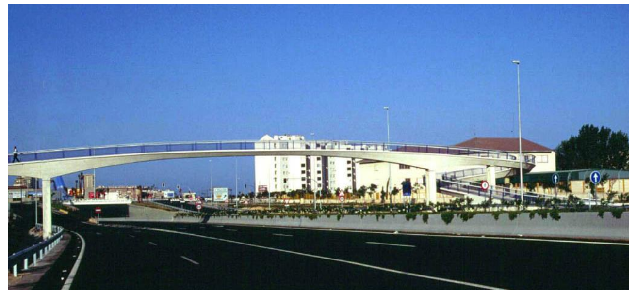
Figura 14: Pasarela sobre la A31, entrada sur a Alicante; Fuente: http://www.jallombart.com
