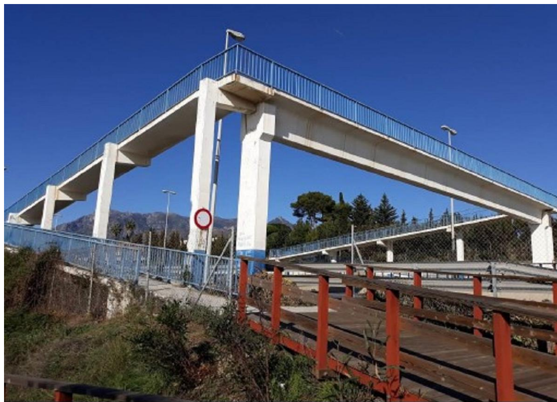
Figura 15: Viga de hormigón prefabricada, pasarela sobre A7 en Málaga; Fuente: www.laopiniondemalaga.es
