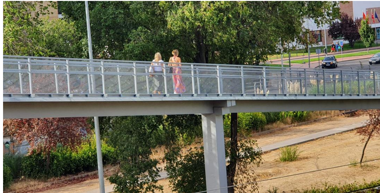
Figura 16: Pasarela metálica en Alcalá de Henares; Fuente: www.ayto-alcaladehenares.es
