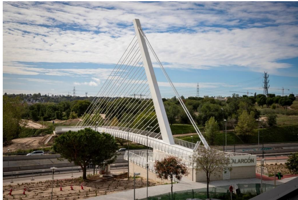
Figura 7: Pasarela atirantada sobre la M-503 en Pozuelo de Alarcón; Fuente: www.estudioaia.com
