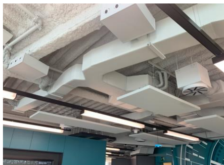
Figura 18. Techo sin ningún material audiovisual.
