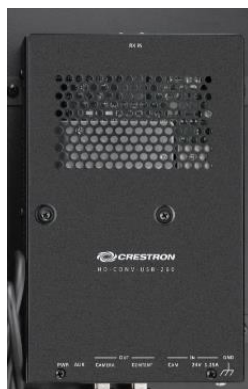
Figura 27. Convertidor ya integrado en la placa para rack.
