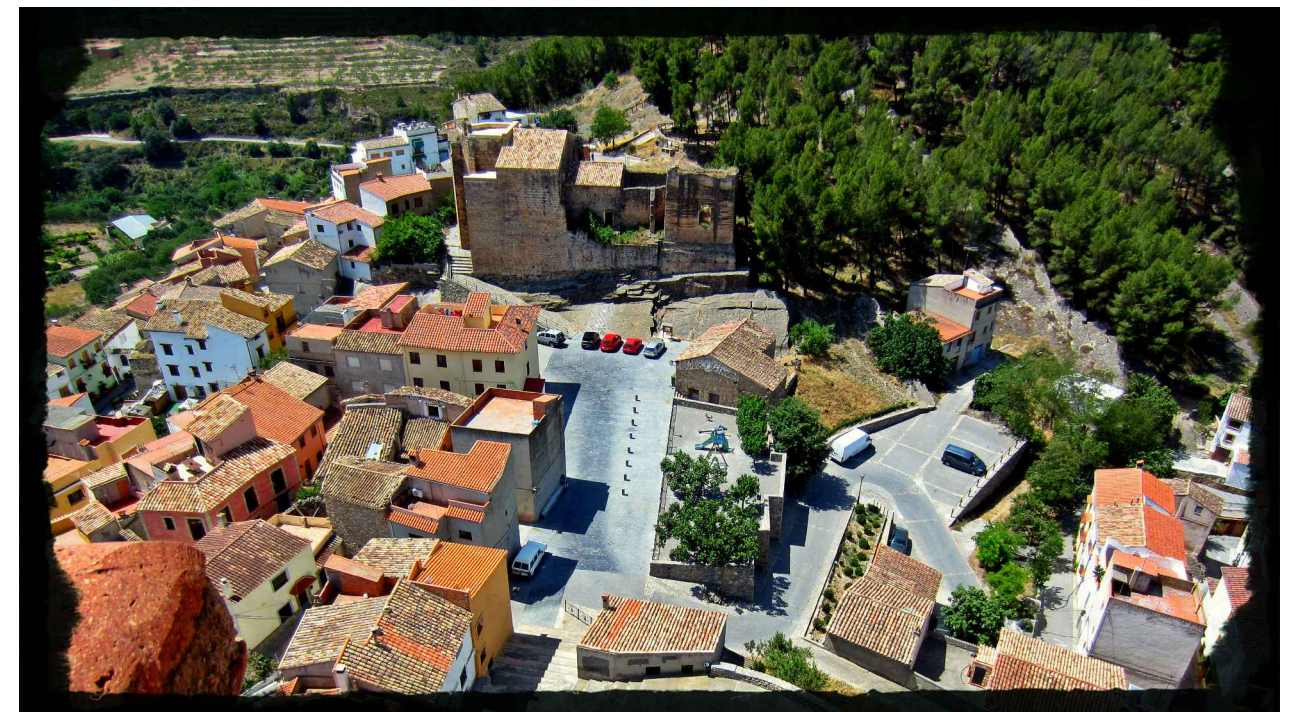
Imagen de la fachada Norte de la ermita desde la Torre de las Campanas.
