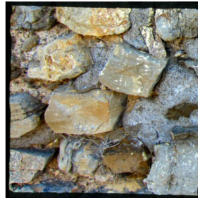
Fotos de vaciados de juntas en el sector verde:
