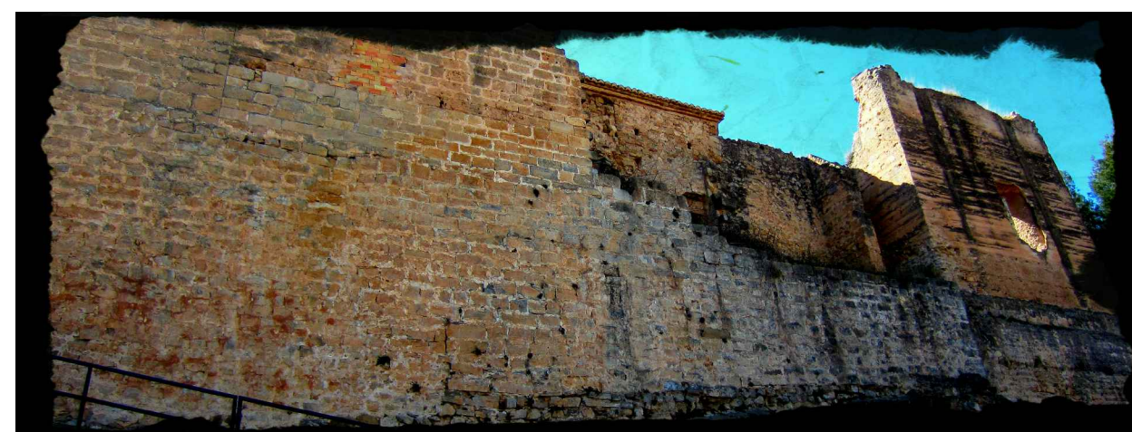
Refuerzo de la muralla andalusí con muros de sillares tras la conquista cristiana.
