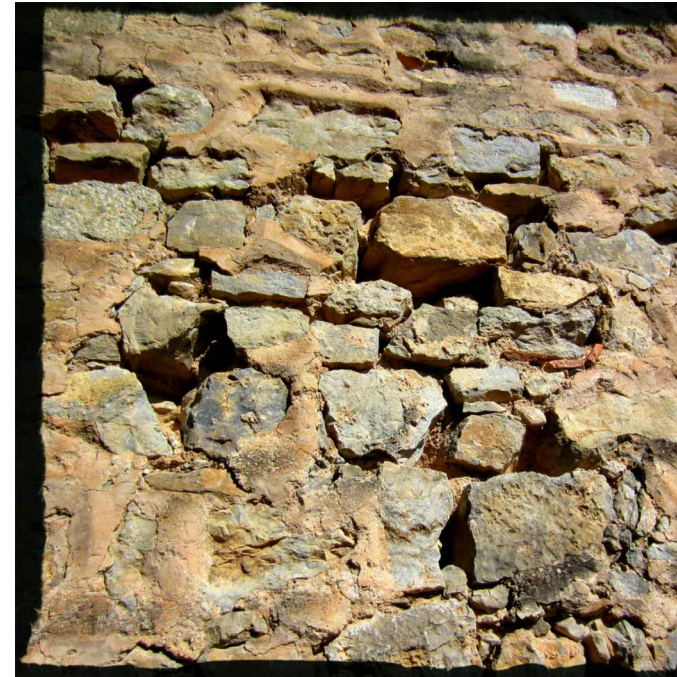
Fotos de vaciados de juntas en el sector cían:
