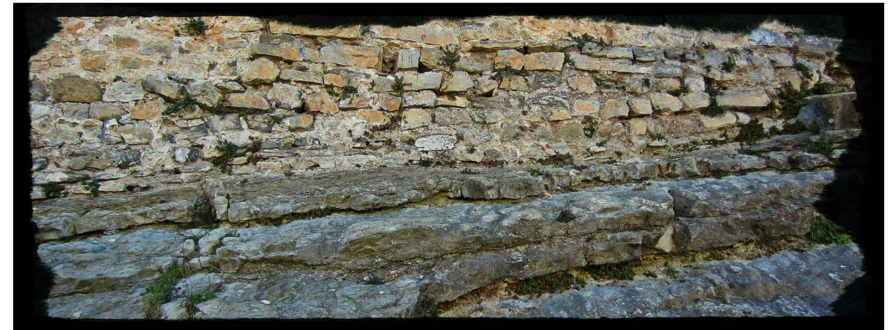
Apoyo de la muralla andalusí sobre la roca de la montaña.
