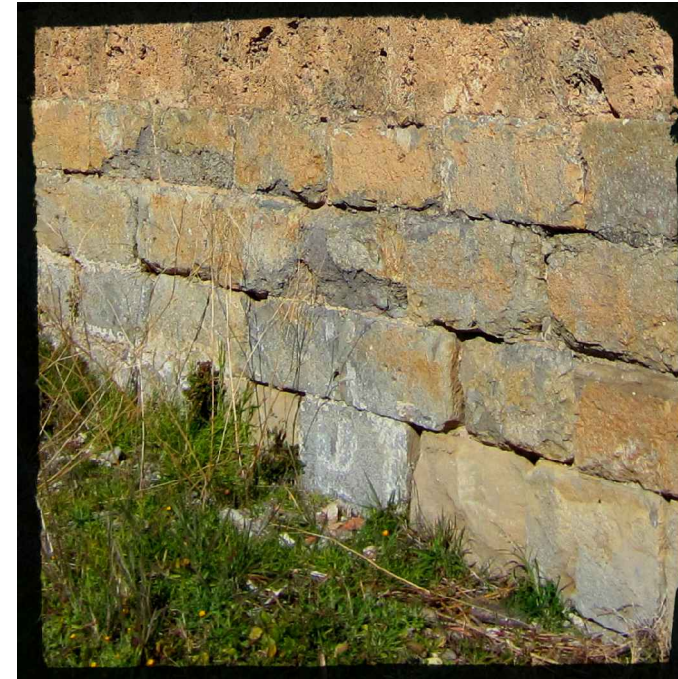
Fotos de vaciados de juntas en el sector naranja:
