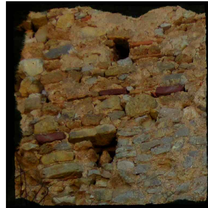
Fotos de vaciados de material en el sector rojo:
