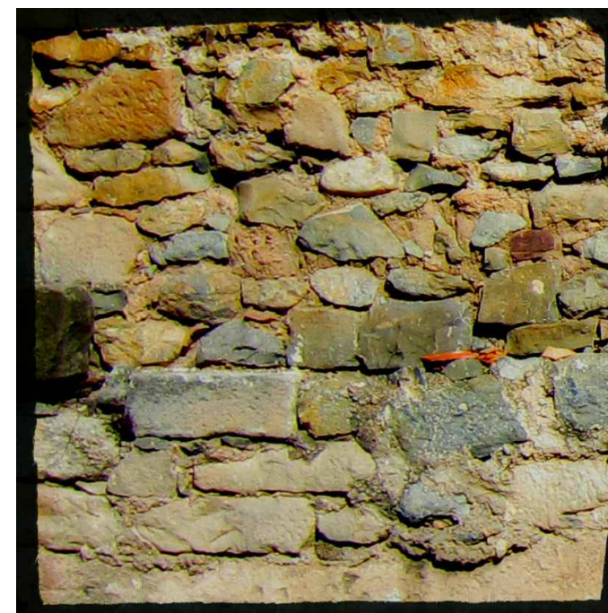
Fotos de vaciado de juntas en el sector rojo:
