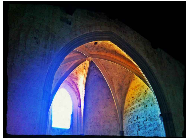
Bóveda de crucería del ábside.
