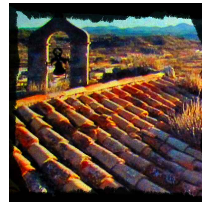
Ábside antes de la intervención.
