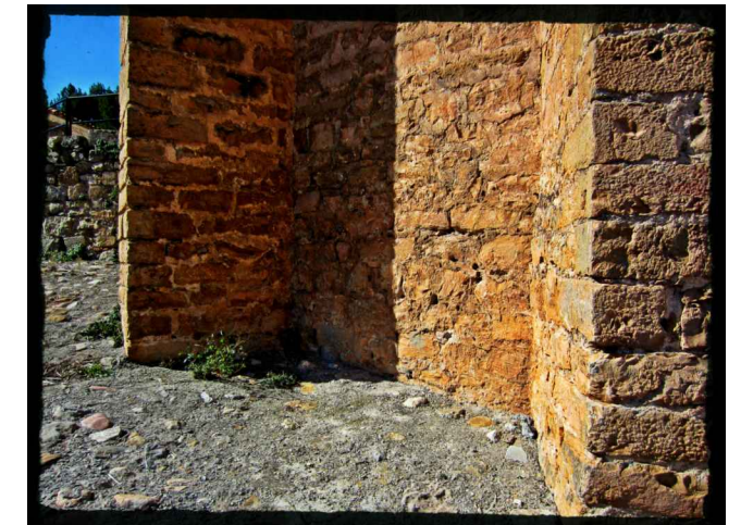
Cimentación del ábside con sillares.
