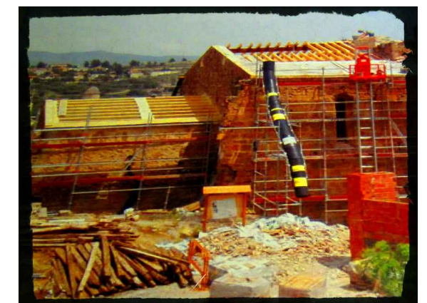
Cubierta inclinada del transepto y la nave central durante la intervención (2007).
