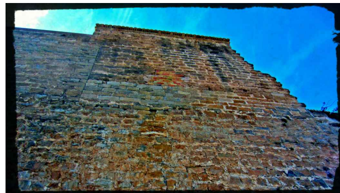
Imagen en la que se observan los cambios de fábrica.
