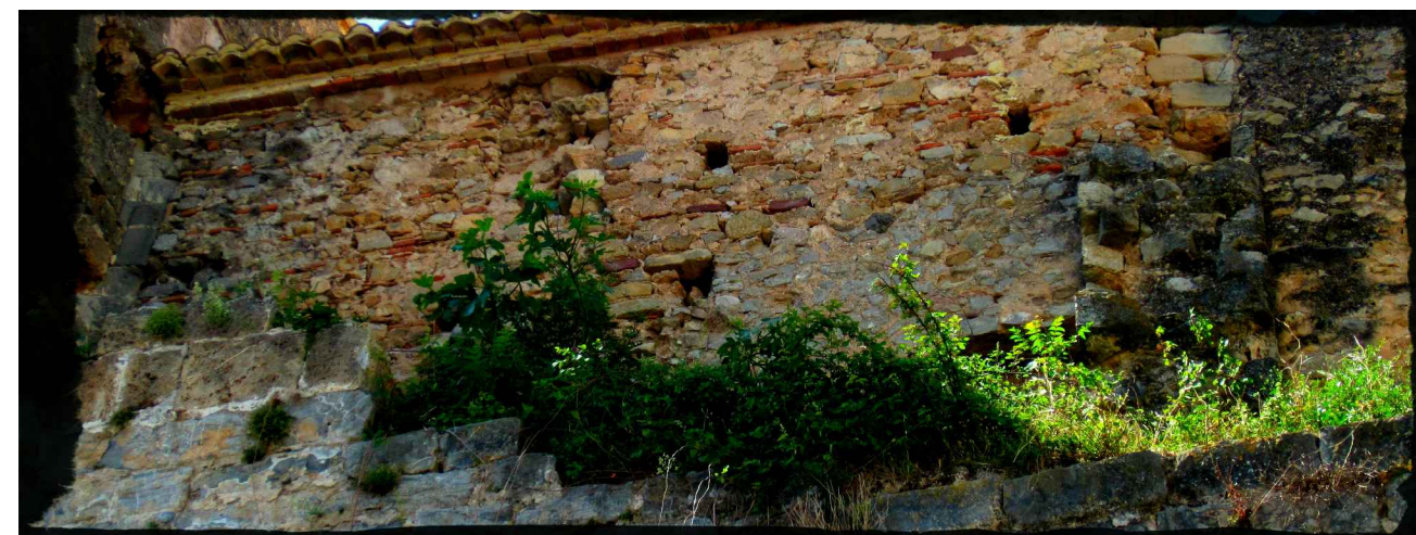
Cornisa en la orientación Norte repleta de plantas y muro de mampostería del sector rojo.
