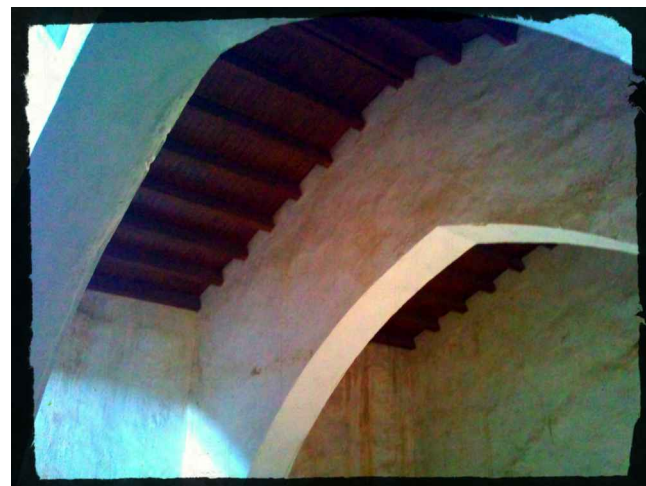
Arco diafragmático de la nave central.
