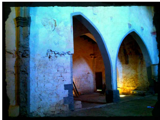
Arco apuntado cegado en la nave central.
