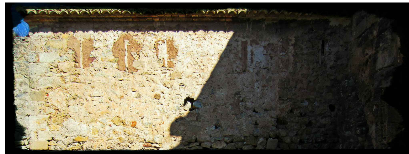
Muro del sector rojo en la fachada Sur cubierto de mortero en su mitad superior y aspilleras cegadas.
