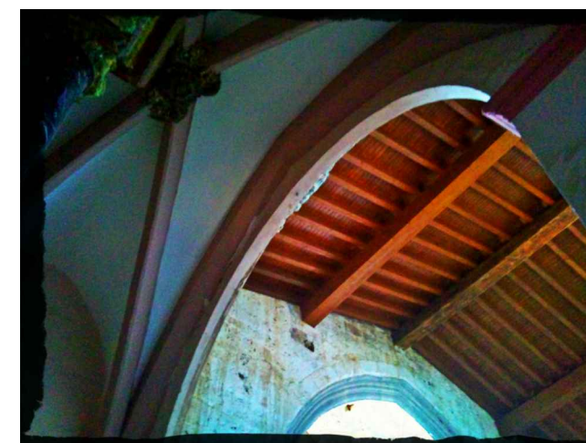
Apoyo de cubierta sobre muro de carga y arco apuntado.
