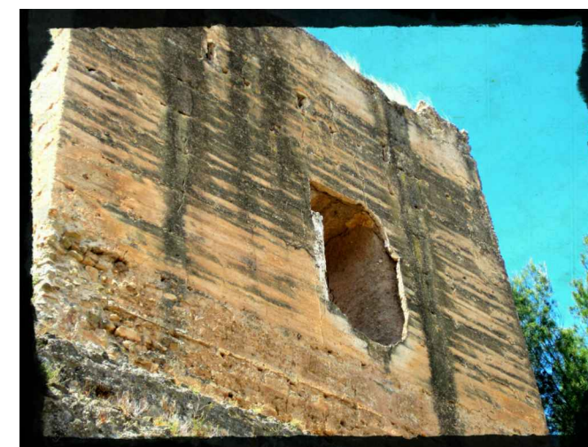
Cara Norte del muro de tapial.
