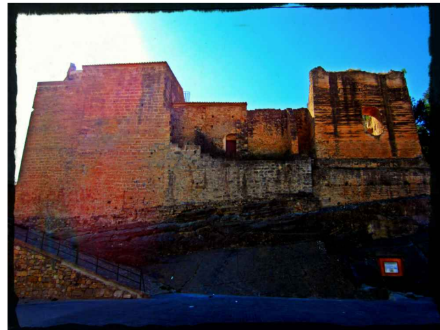
Orientación Norte de la ermita, desde donde se aprecia en relleno de mampostería en la base y el refuerzo de sillares tras la conquista cristiana.
