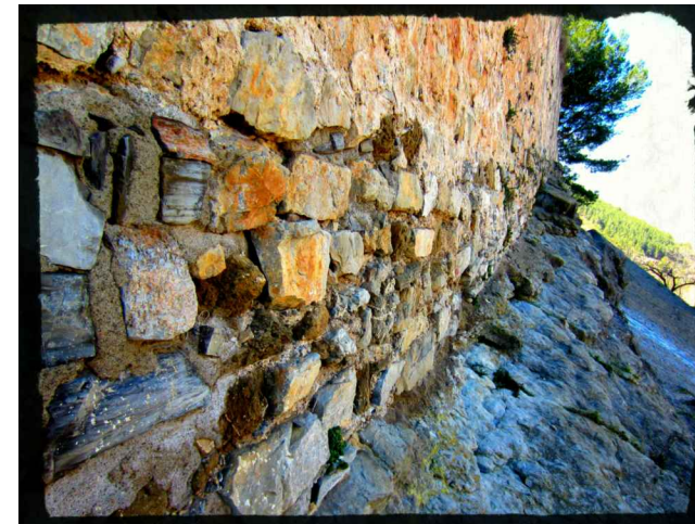
Base de mampostería.
