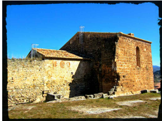
Unión del antiguo templo de muros de mampostería con la ampliación de la iglesia de toba calcárea.
