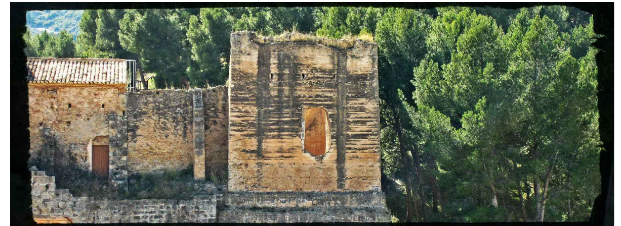
Torre de tapial levantándose sobre una base de mampostería.
