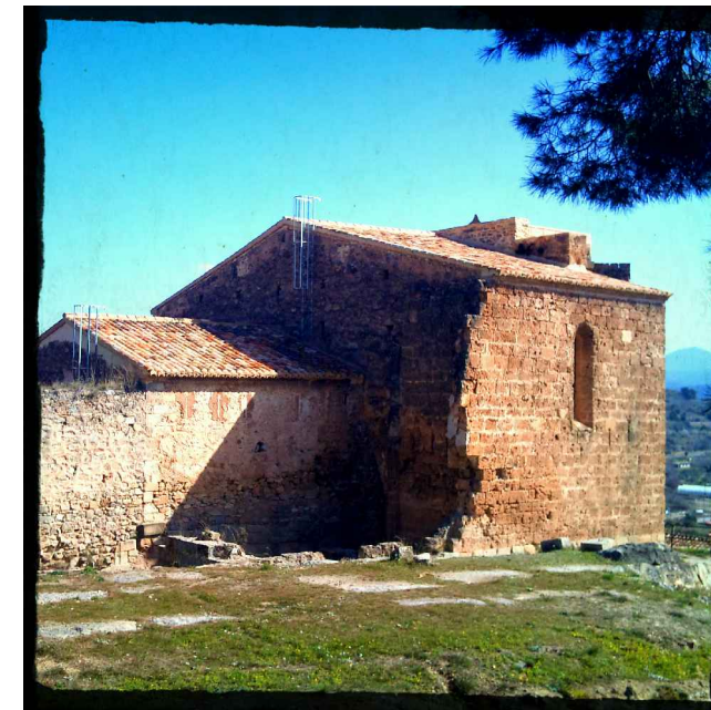
Imagen de la unión de la nave central con el transepto.
