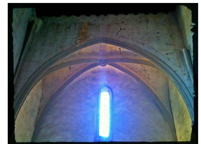
Bóveda de crucería en el extremo del transepto.
