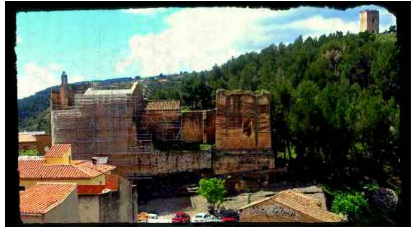
Fotografía de la Ermita con lo andamios durante la intervención de 2007.
