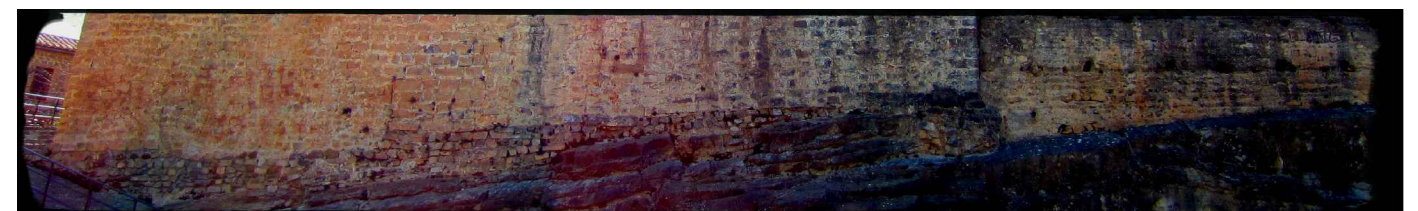
Vista centrada en la base de mampostería y muro de sillares que conforman la cimentación del conjunto arquitectónico.
