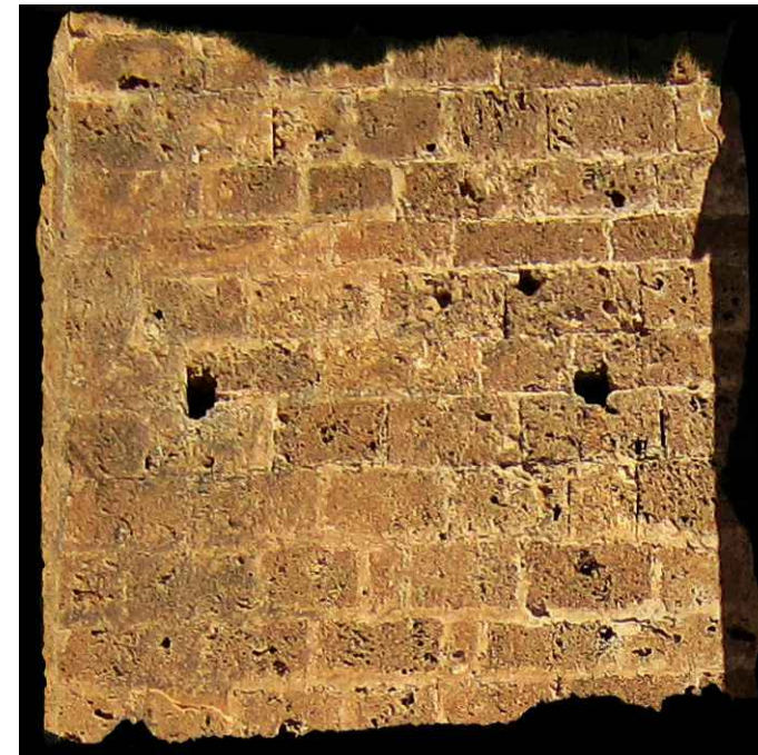
Fotos de vaciados de material en el sector azul:
