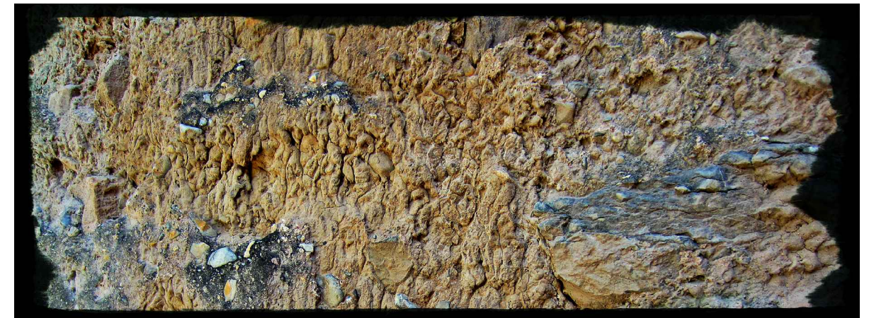
Superficie de tierra lavada y disgregada al haberse desprendido la costra superficial.
