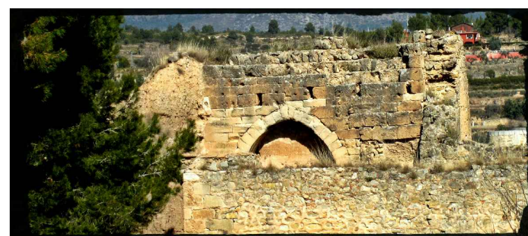
Muro de sillares de piedra insertados en el tapial.
