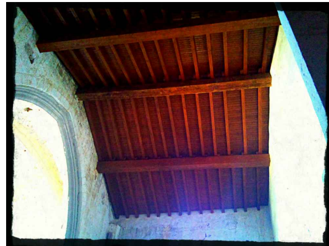
Cubierta inclinada observada desde el crucero.
