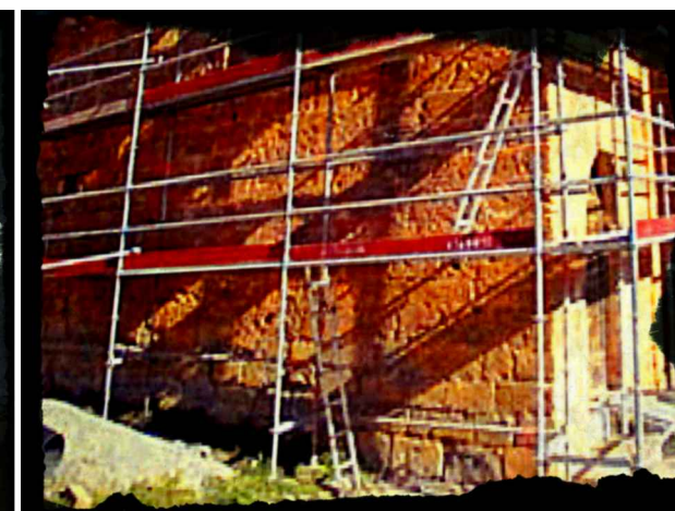
Andamio en la fachada Sur de la ermita.
