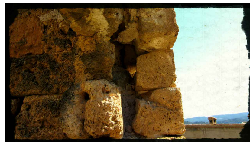
Muro de dos hojas de sillares de toba calcárea.
