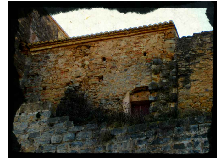
Cara Norte del muro de mampostería.
