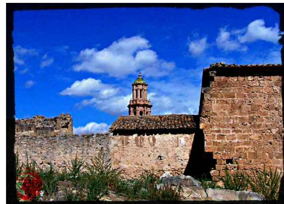
Ermita antes de su intervención del año 2007.
