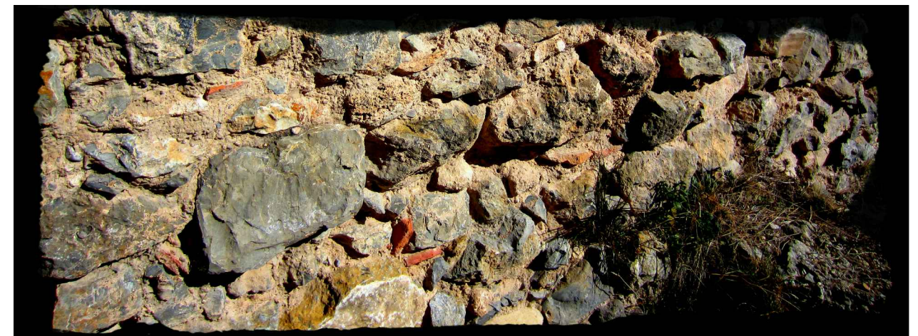
Mampuestos con algunos ladrillos intercalados en la orientación Sur del sector cían.
