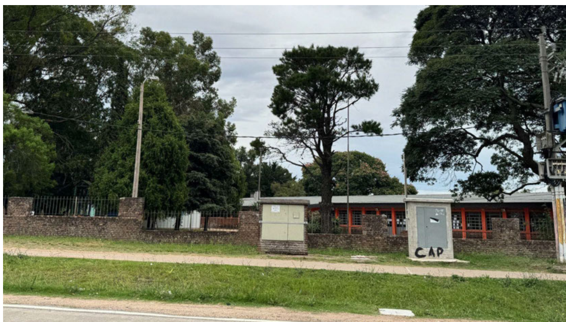
Fig. 7 Escuela Pública N° 157 Villa García (Municipio F), Fachada Principal Exterior. Fuente: Palermo Miserocchi, R (2025)
