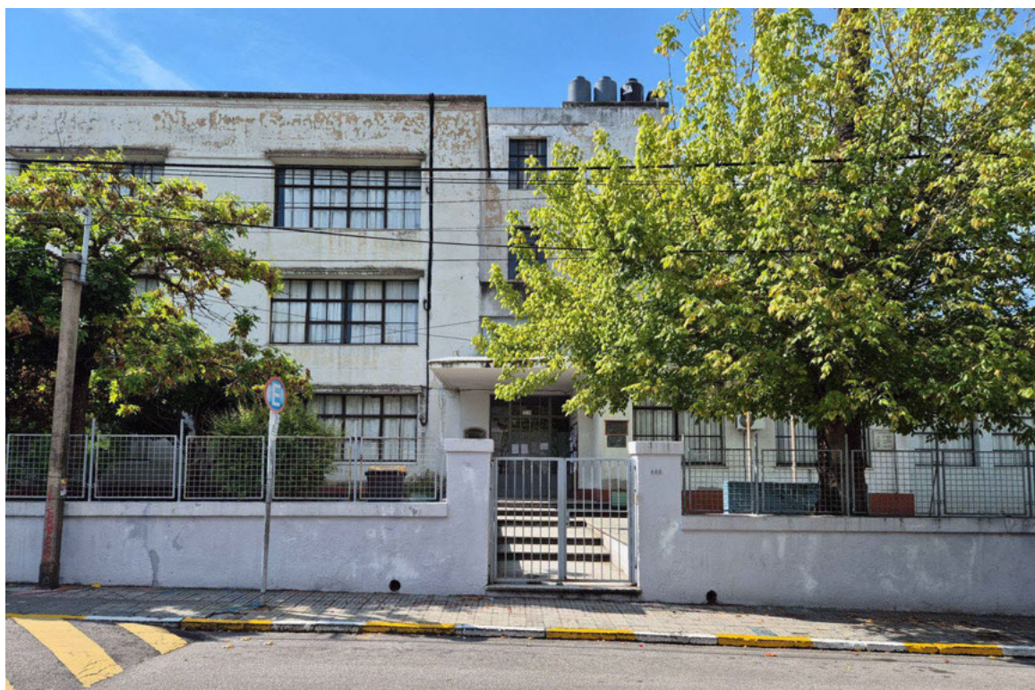
Fig. 9 Escuela Pública N° 3 Francia (Municipio CH), Fachada Principal acceso 1. Fuente: Grezes, M. (2025)
