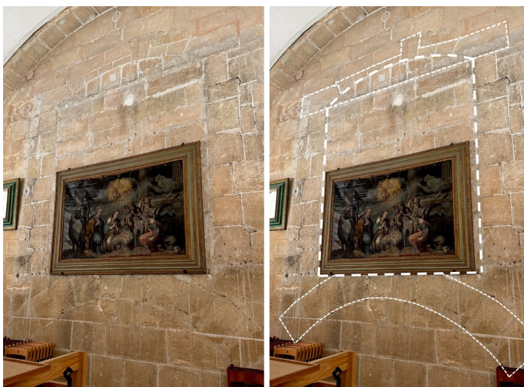
Figura 5. Ventanal cuadrado cegado en el centro de la fachada, visto desde el interior (coro alto). Se distingue el “capialzado de Marsella”, que fue cegado con sillares más pequeños; su arco adintelado de cierre; y el arco de descarga sobre el acceso principal a la iglesia, debajo de la ventana.
