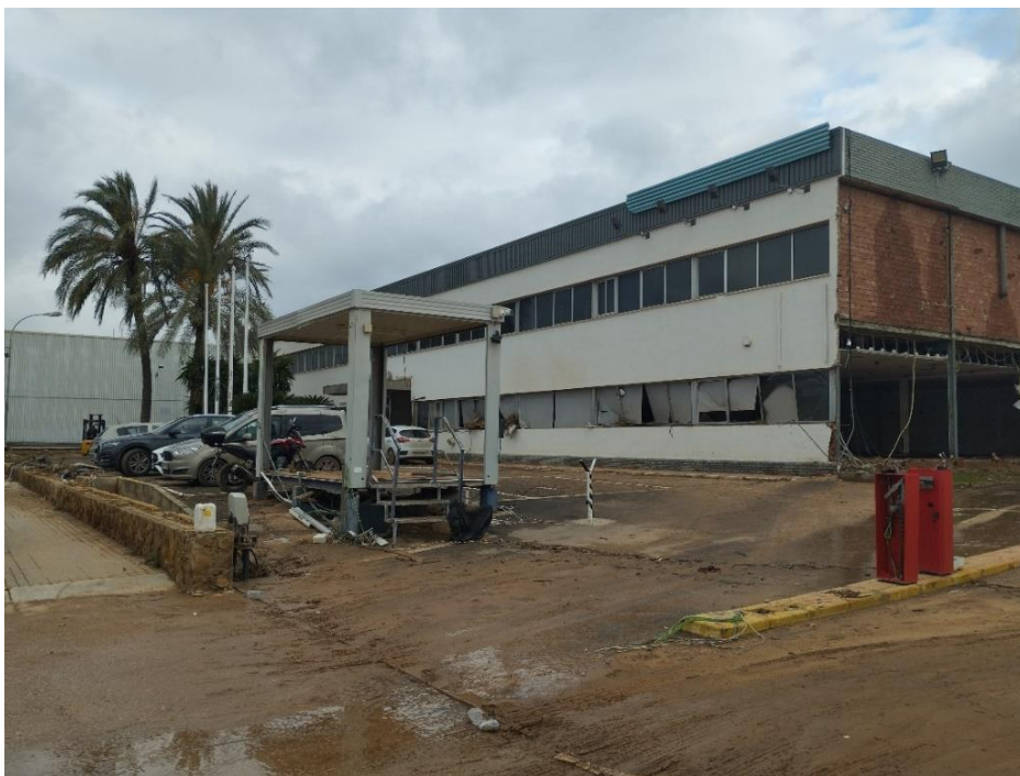
Imagen 92 : Daños en planta baja y exteriores tras la DANA, visibles en ventanas, vehículos y estructuras. (Eguibar, 2024).
