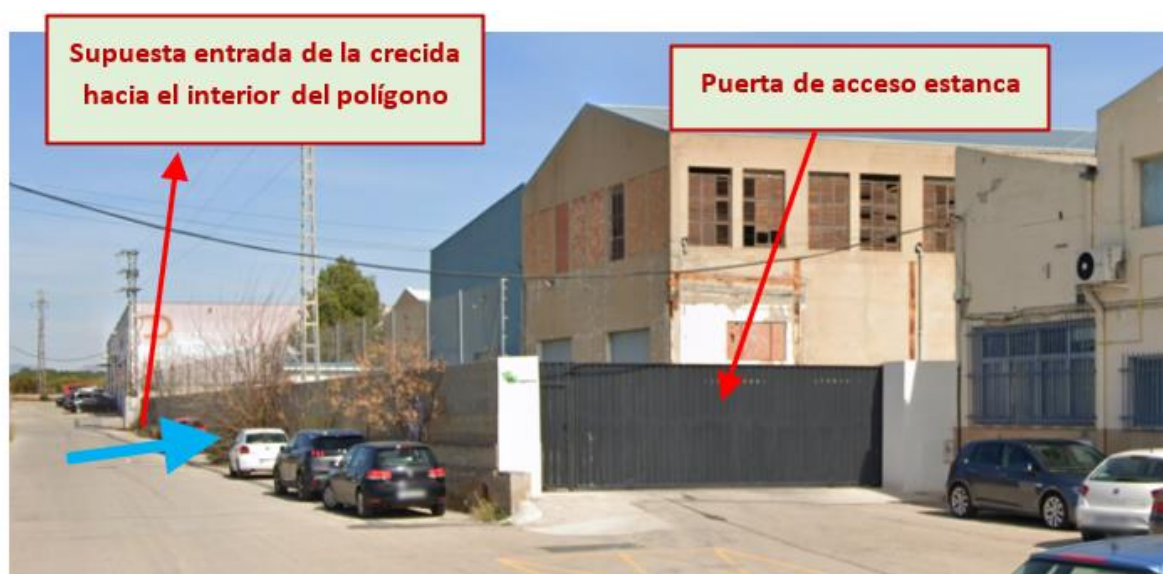
Imagen 28 : Puerta de acceso prácticamente estanca integrada en el muro perimetral no considerado por la cartografía del SNCZI. Vista desde el este. (Eguibar, 2024).
