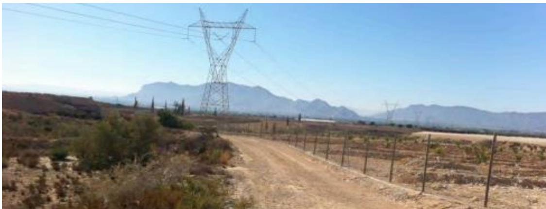
Figura 33. Tendido eléctrico de la Alternativa 1. Fuente: elaboración propia.
