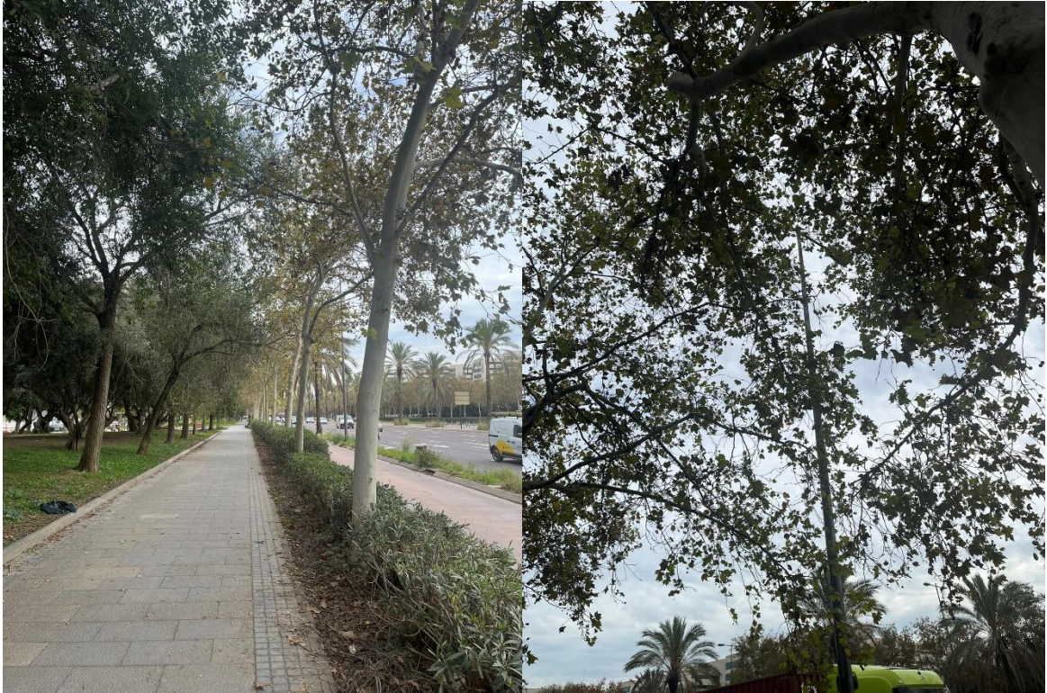
Imagen 13 Itinerario peatonal y vegetación cubriendo luminaria
