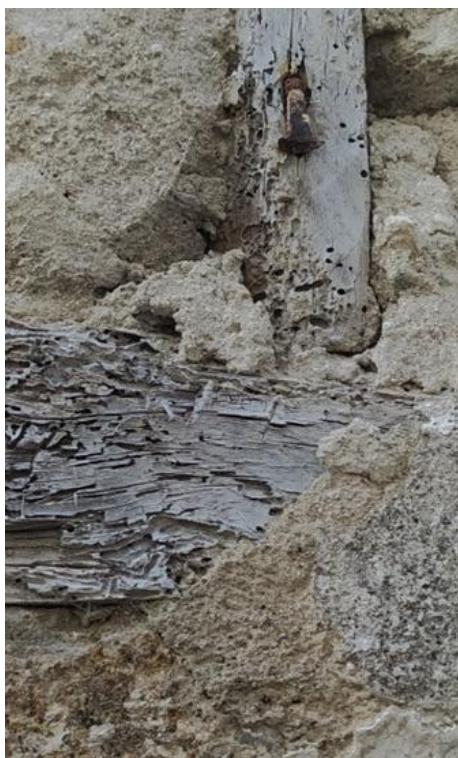
Detalle del muro de entramado con relleno de piedra en Viveiro. 2021 (Fernández Palicio)
