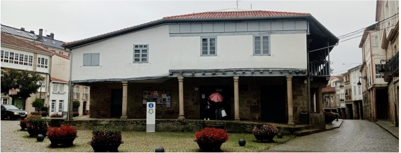
Construcción de entramado en Chantada. 2021 (Fernández Palicio)
