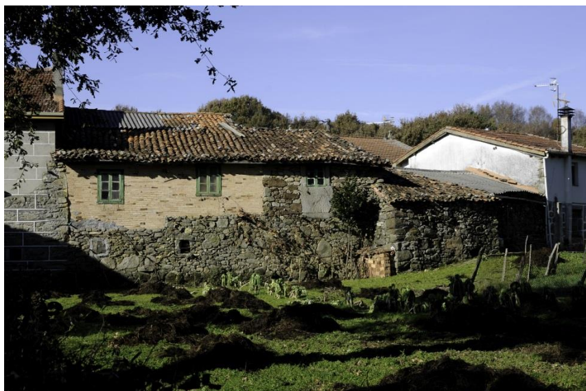
Vivienda en la que el ladrillo sustituyó a los tradicionales muros de piedra. 2013 (Fernández Palicio)
