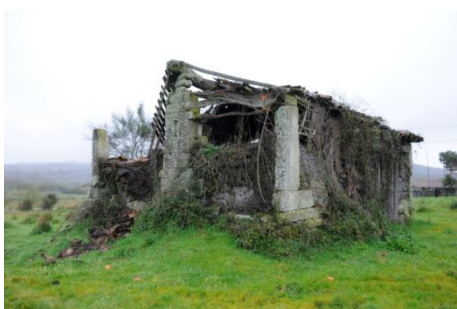
Muro de terróns tipo arcaico, sin basamento, estructura sobre pilares de pedra de granito y cuberta de teja del país. Lavandeira. 2013. (Fernández Palicio)
