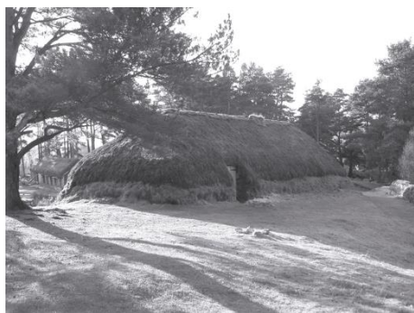
Reconstrucción de un establo levantado con muros de terrones y cubierta vegetal en el Highland Folk Museum, Newtonmore (Escocia) (Wilkinson, 2009)
