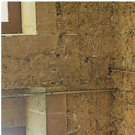
Interior de tapia del cañón de la escalera principal (Garrido Vila 1998; citado en Freire Tellado & Blanco Losada & Agudo García (2022)).
