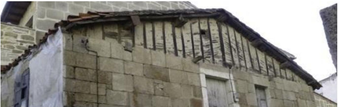
Detalle del pincho de cubierta con muro de entramado. 2012. (Fernández Palicio)
