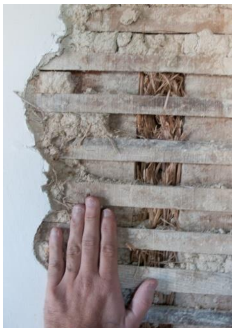
Estructura de tabique de colmo en Allariz. 2018. (Fernández Palicio)
