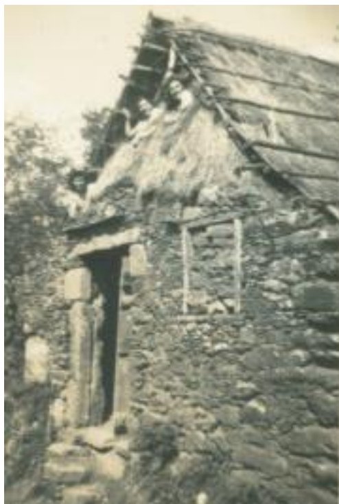
Construcción de piedra en las mariñas coruñesas. (www.fototecacambre.es. Último acceso: 15/05/2021)
