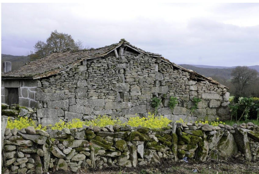
Muro tipo 3 donde los terrones fueron sustituidos con cachotería de granito. Penouzos, parroquia de Padreda, Concello de Vilar e Barrio. 2013
