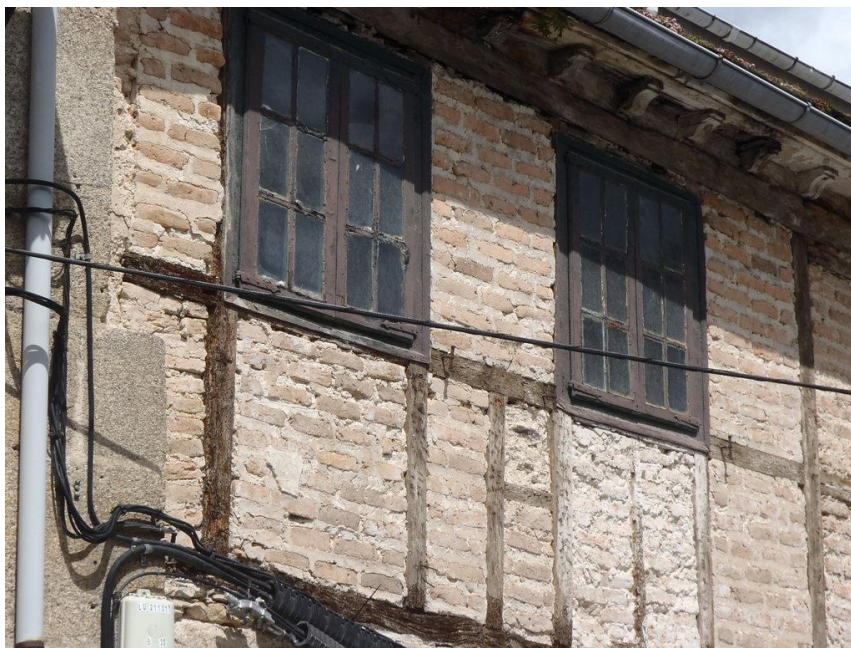
Detalle del muro de entramado ladrillo en una vivienda en Mondoñedo. 2019. (Fernández Palicio)
