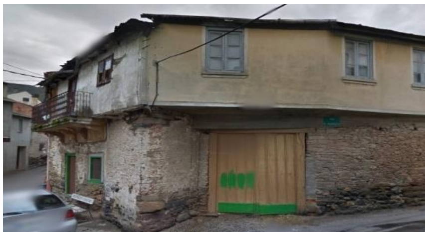
Vivienda de entramado en planta superior en A Rúa. 2013 (Fernández Palicio)
