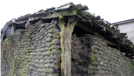
Detalle del pilar acabado horquilla que recoge la viga. 2013 (Fernández Palicio)
