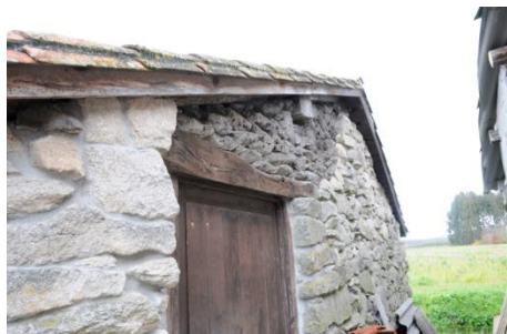
Utilización de terróns como cierre sobre un dintel. 2013. (Fernández Palicio)
