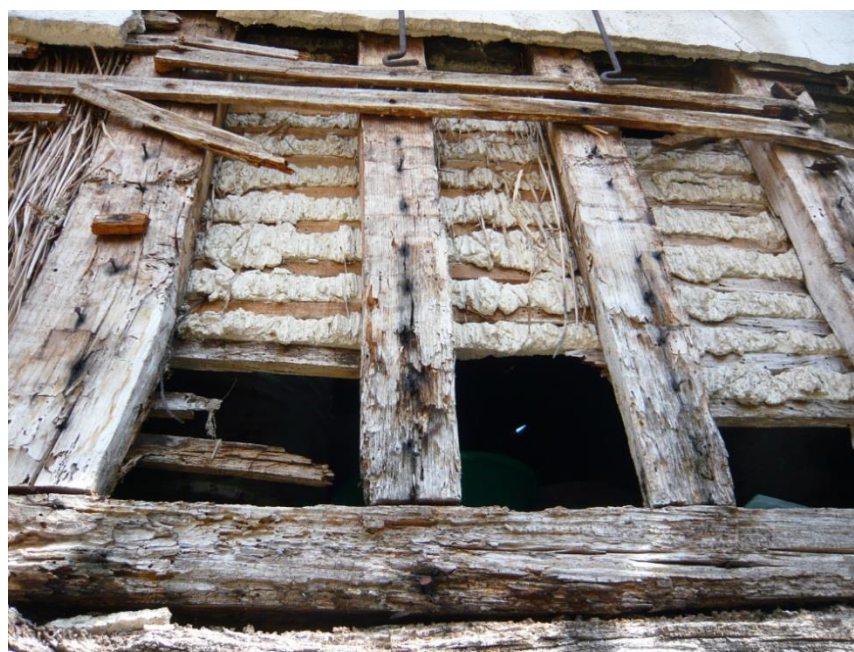
Estructura de entramado de colmo en San Lourenzo, Parada de Sil. 2014. (Fernández Palicio)
