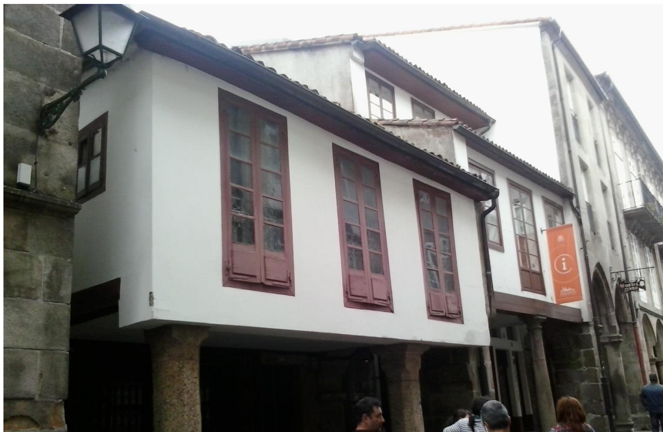
Viviendas con soportales en la Rúa Nova de Santiago de Compostela. Un ejemplo de cómo evolucionó la tipología de entramado, conservando el soportal, pero aumentando los huecos de fachada. 2020. (Fernández Palicio)
