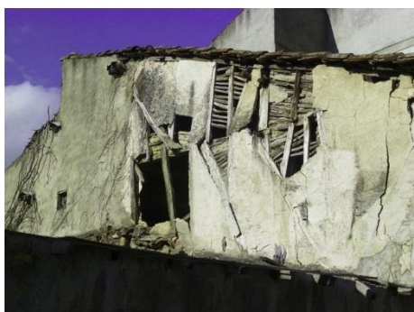
Vivienda y detalle del entramado de pallabarro. 2012. (Fernández Palicio)
