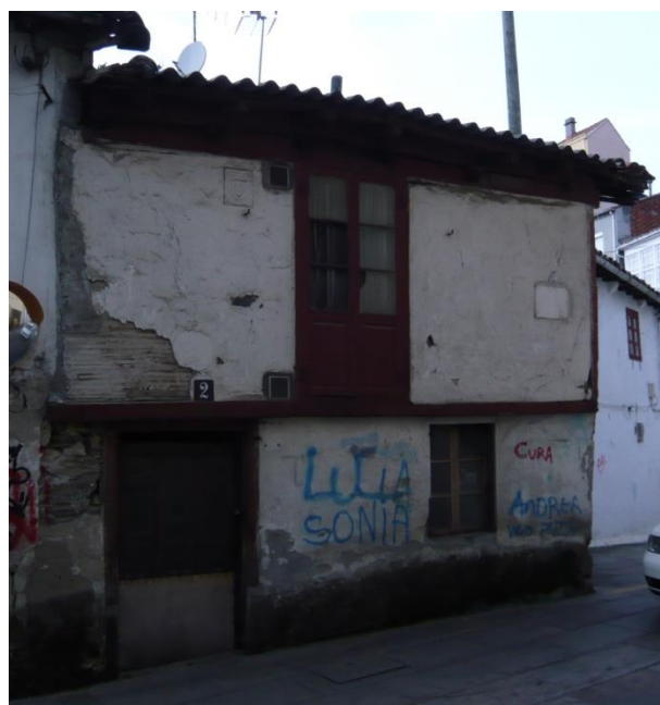
Vivienda de entramado de madera encestado o de barrotes, con rellenos de paja y barro y ladrillo. 2009 y 2010. (Fernández Palicio)
