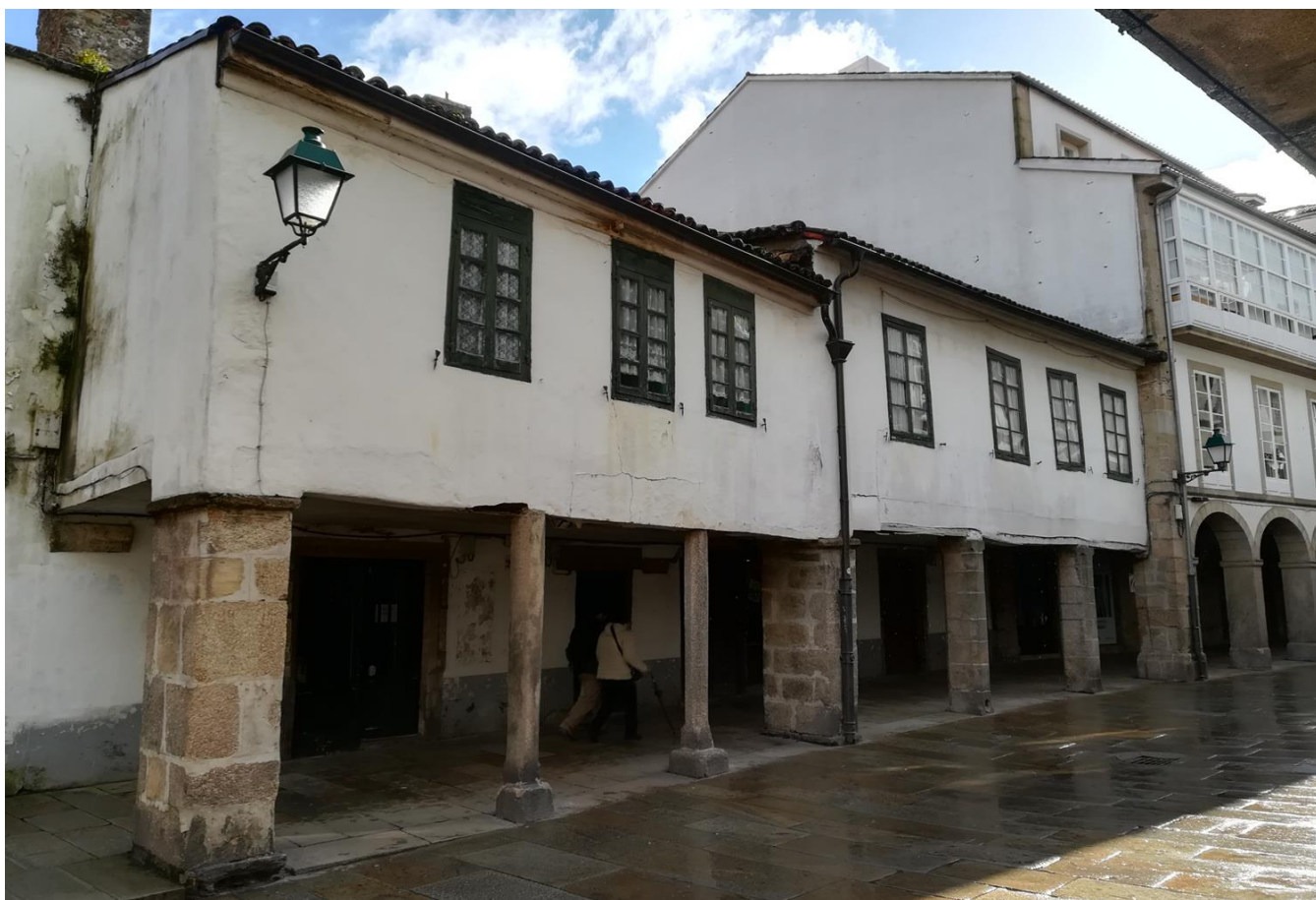
Viviendas con soportales en la Rúa Nova de Santiago de Compostela. Uno de los escasos ejemplos conservados de tipología de vivienda con soportales y estructura de entramado de madera con huecos pequeños. 2020. (Fernández Palicio)
