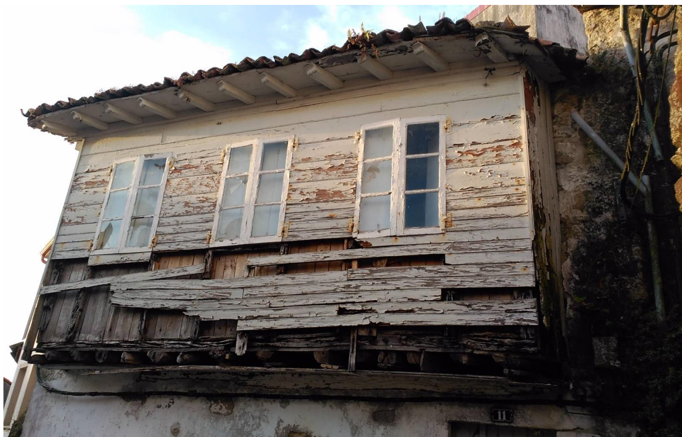
Vivienda de entramado de madera con cubrición de tablas en Muros. Fuente: Oficina de rehabilitación de Muros. 2018. (Cedida por la Oficina de rehabilitación de Muros)
