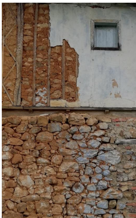
Entramado de madera con relleno de piedra y tierra en el oriente asturiano. 2021. (Fernández Palicio)
