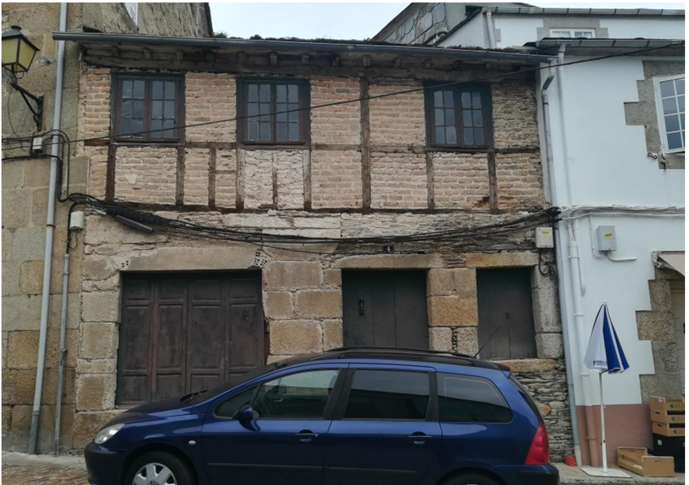
Uno de los ejemplos de vivienda de entramado medieval con relleno de ladrillo y planta baja de piedra que conserva los huecos de fachada sin modificar. 2020 (Fernández Palicio)
