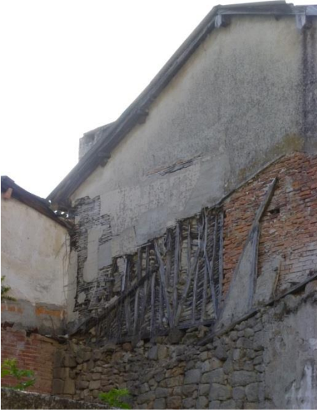
Detalle de muro de entramado 2012. (Fernández Palicio)
