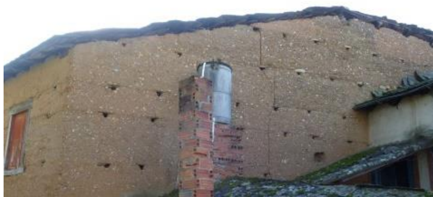
Fotografías de construcción de tapia en Ríos. 2011. (Fernández Palicio)
