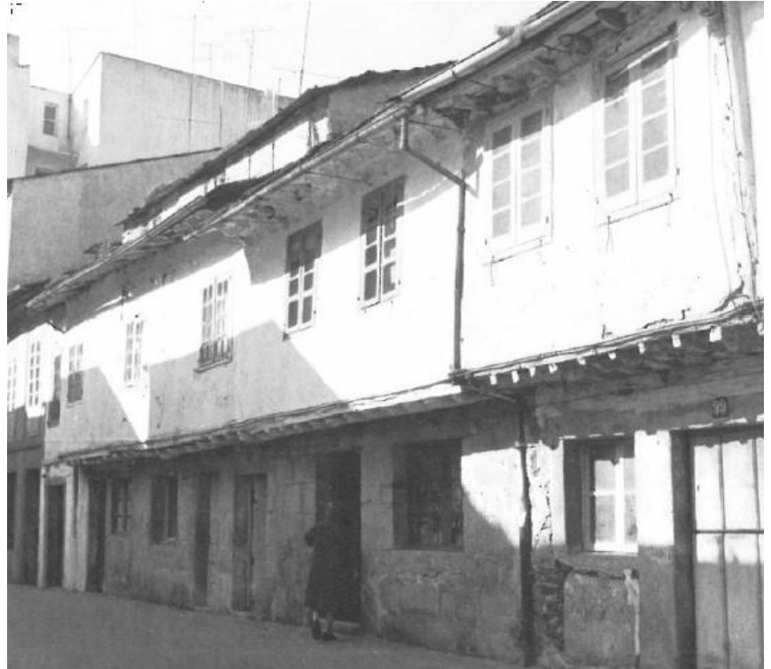
Viviendas de entramado en Ourense (Flores, 1973)
