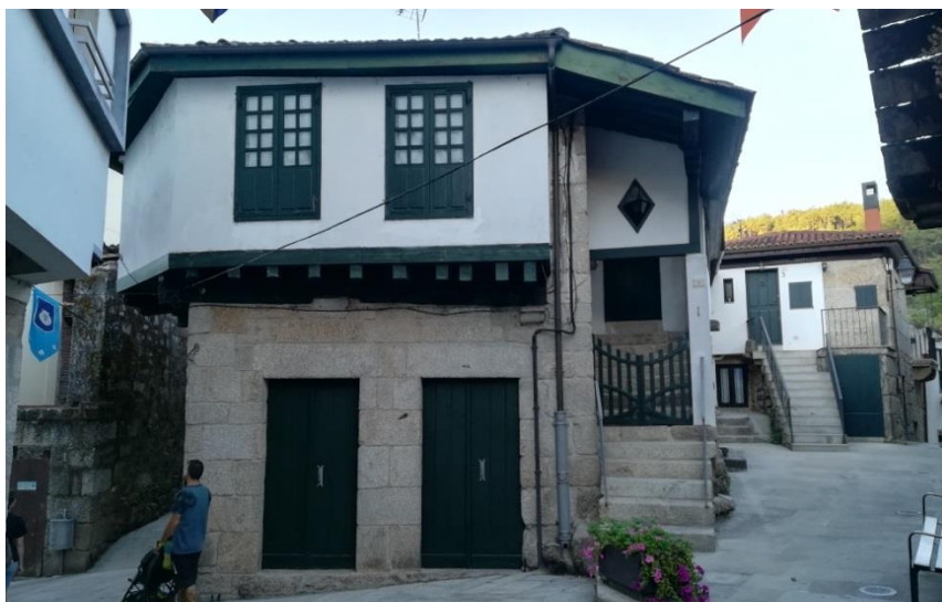
Vivienda de entramado de madera, con rellenos de paja y barro. 2019 y 2021. (Fernández Palicio)
