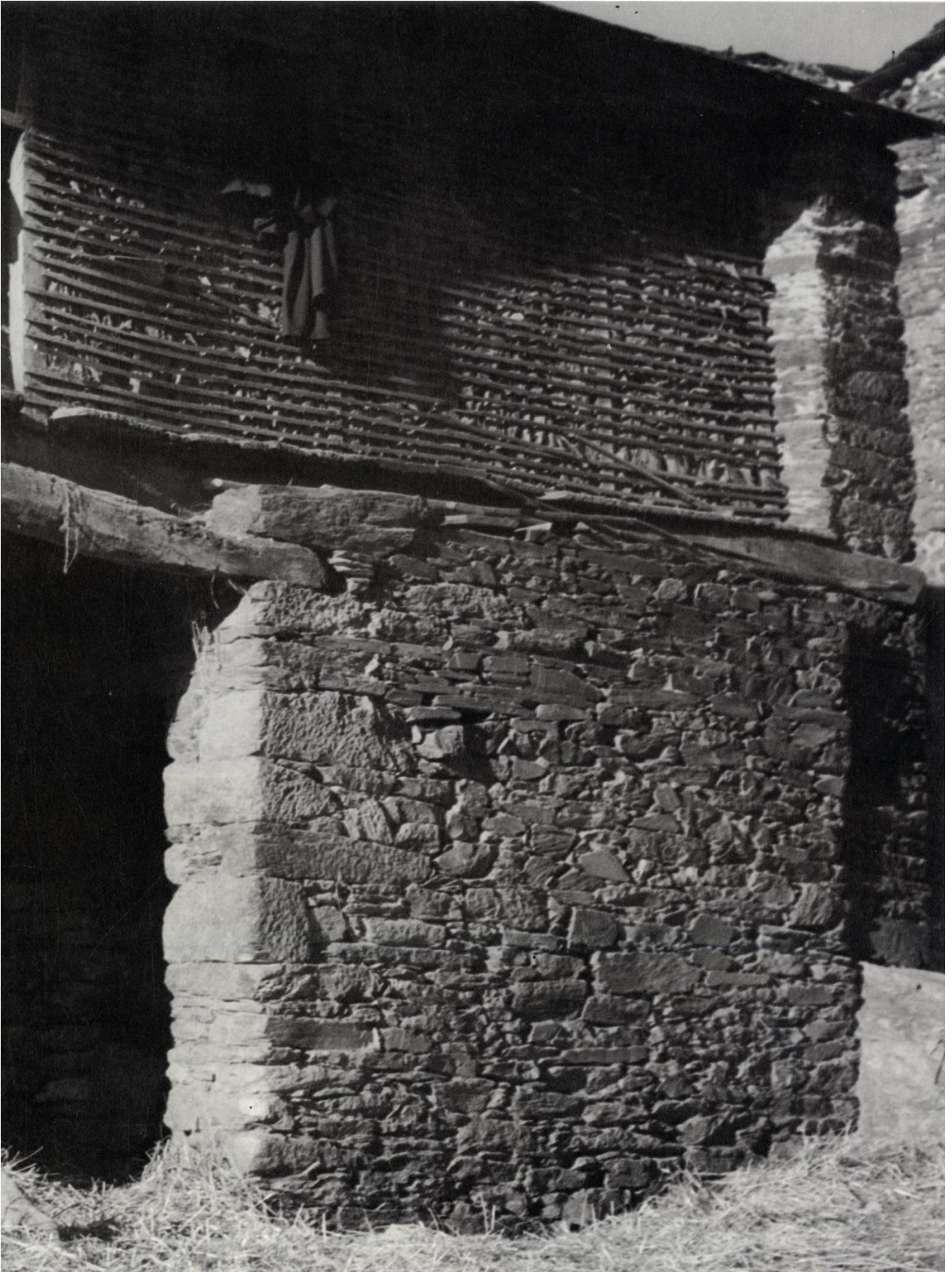
Vivienda de piedra de esquisto en planta baja y entramado en el piso superior en Guadramil (AAP, 1998)
