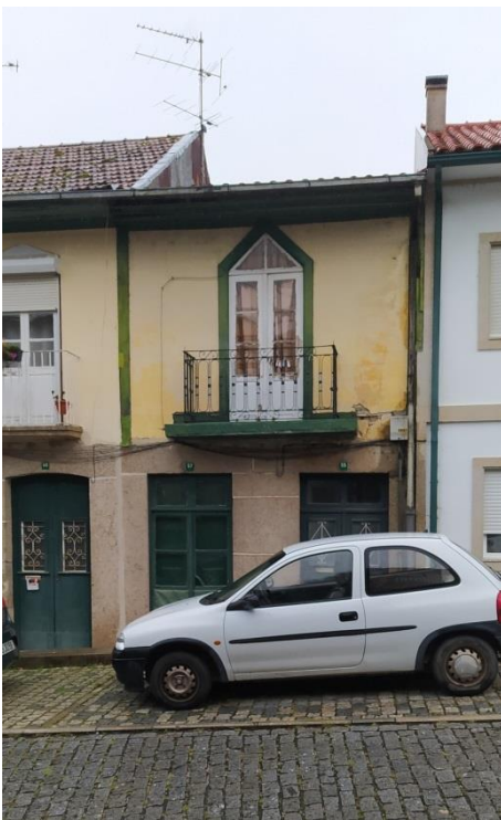
Viviendas con planta baja de piedra y primera planta de entramado en Monção. 2021 (Fernández Palicio)
