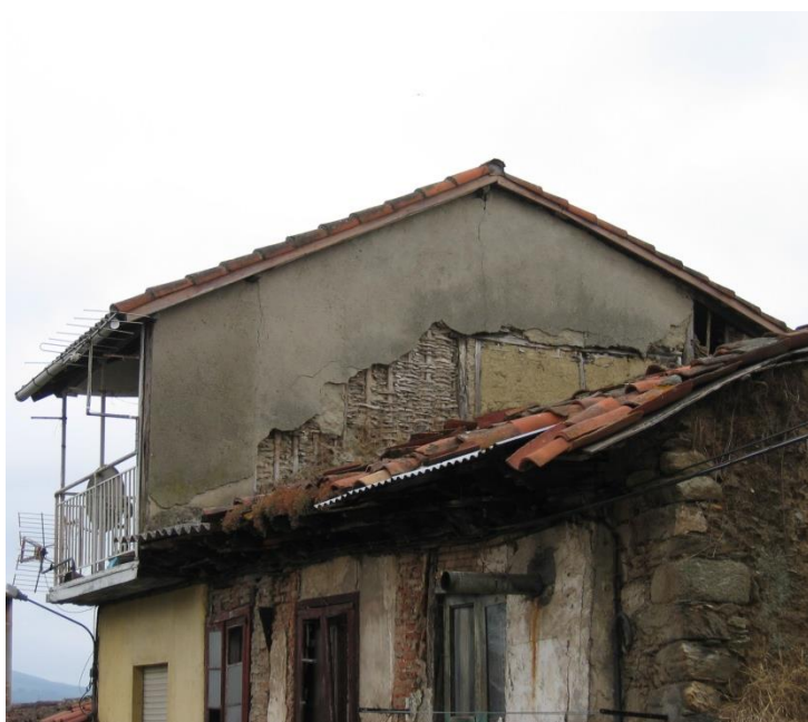
Vivienda de entramado de madera encestado o de barrotes, con rellenos de paja y barro y ladrillo. 2009 y 2010. (Fernández Palicio)
