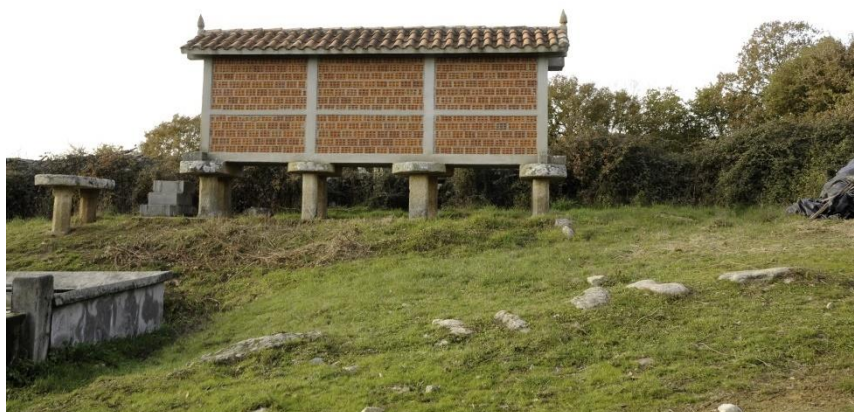
Hórreo que ha sustituido los materiales tradicionales por unos industriales manteniendo su estructura y funcionalidad. 2013. (Fernández Palicio)
