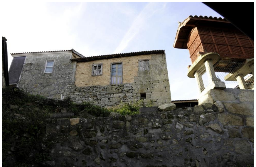
Ejemplo de substitución de de piedra por ladrillo en Calvelo. 2013. (Fernández Palicio)
