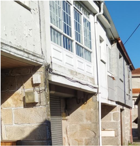
Grupo de viviendas con planta baja de piedra y primera planta de entramado en Melón. 2022 (Fernández Palicio)
