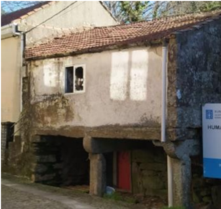
Antigua vivienda con estructura en voladizo de madera en A Caniza. 2022 (Fernández Palicio)
