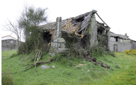
Construcción de terrones en ruina donde puede apreciarse la cubierta de bión bajo la teja Concello de Sandiás. 2013 (Fernández Palicio)
