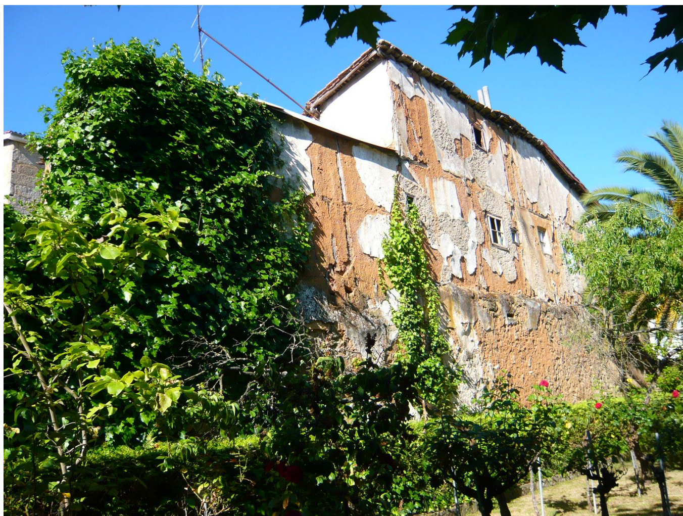
Vivienda de entramado de madera con relleno de paja y barra con revoco de cal al exterior. 2016. (Fernández Palicio)
