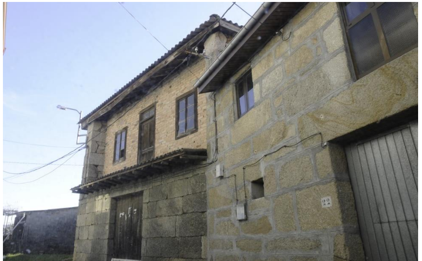
Susstitución de entramado por ladrillo en Vixueses (Maceda). 2013 (Fernández Palicio)
