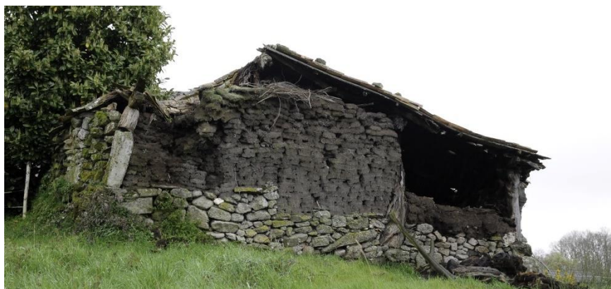
Construcción de terrones en ruina en Cardeita, Concello de Sandiás. 2013 (Fernández Palicio)
