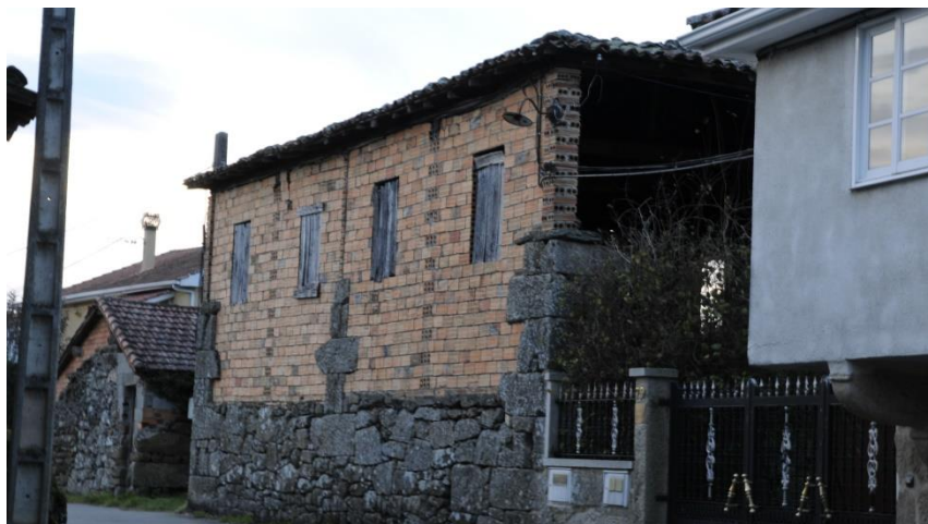
Antiguo palleiro (pajar) en Aldea de Arriba con estructura portante de granito, similar al de los muros de terrones. La actual tiene más altura al aumentar el cierre de ladrillos (2013).
