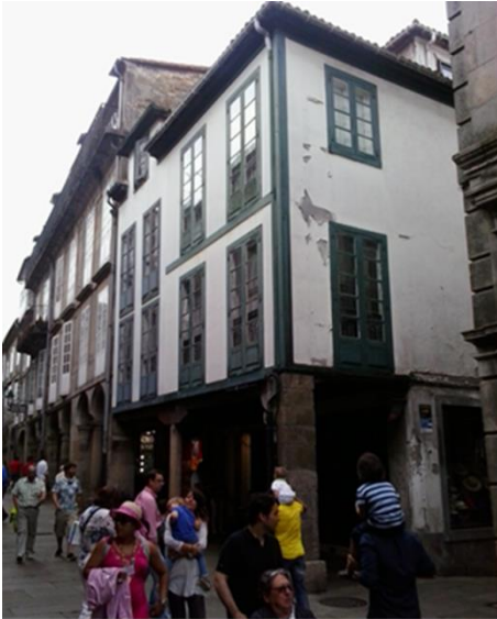
Viviendas con soportales en la Rúa Nova de Santiago de Compostela. Un ejemplo de cómo evolucionó la tipología de entramado, conservando el soportal pero aumentando los huecos de fachada y adicionando un piso. 2020. (Fernández Palicio)
