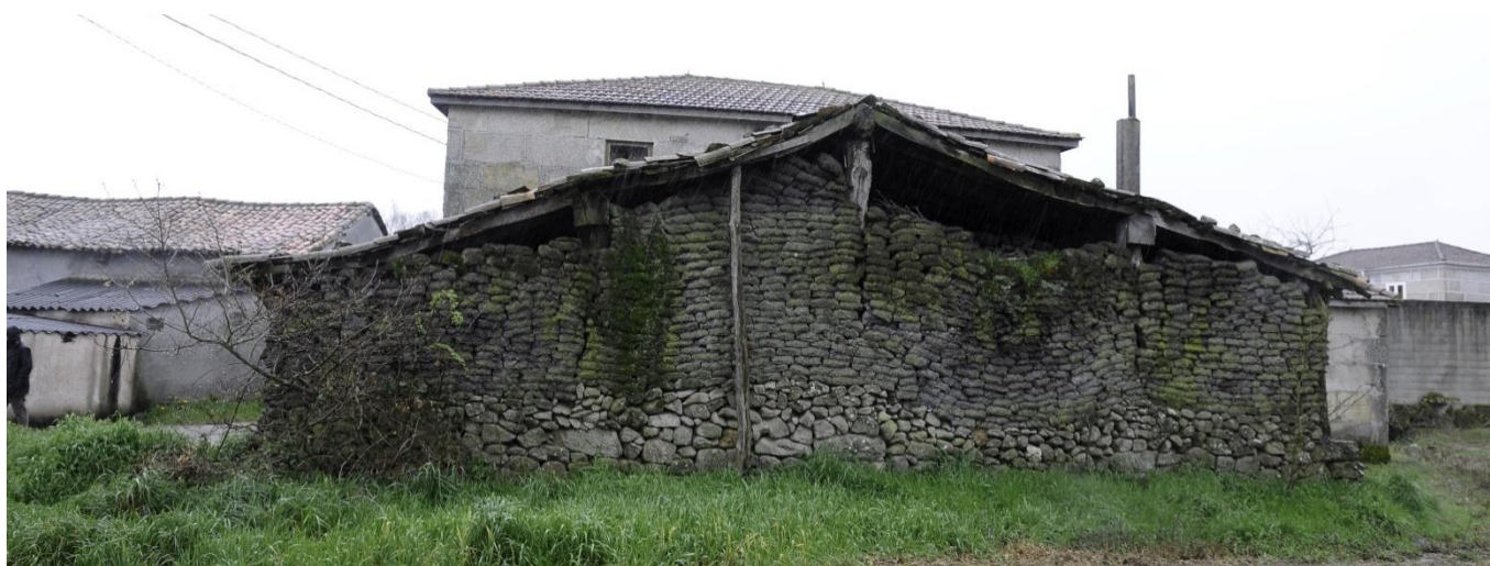
Muro de terrones con basamento de cachotería y pilares de madera. Lavandeira, parroquia de Piñeiro de Arcos, Concello de Sandiás. 2013. (Fernández Palicio)
