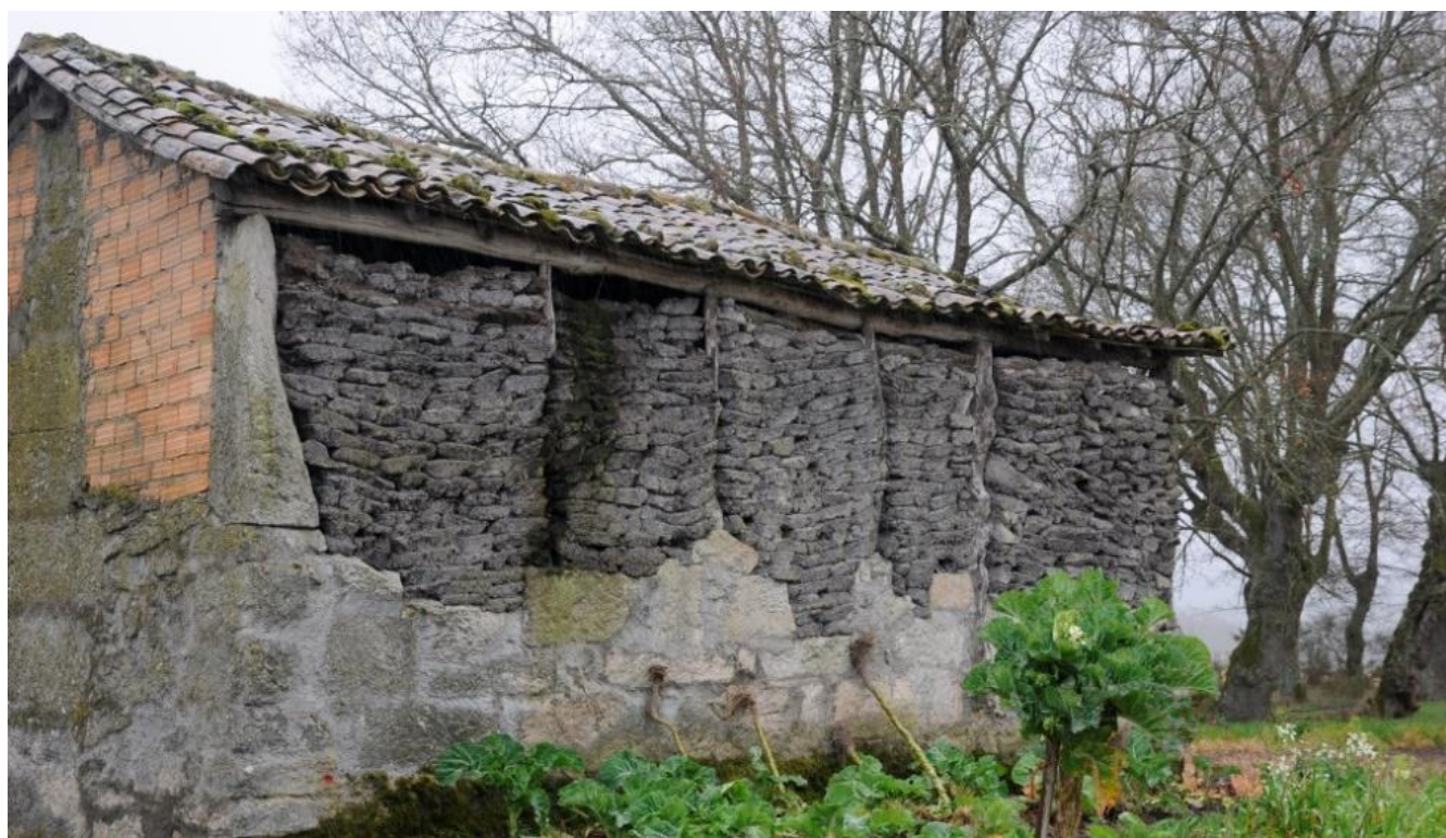
Estructura tipo 3. Lavandeira, parroquia de Piñeiro de Arcos, Concello de Sandiás. 2013. (Fernández Palicio)
