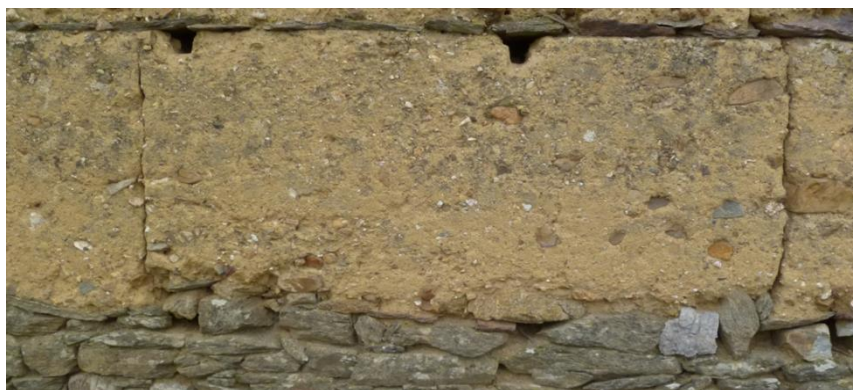
Fotografías de detalle de la colocación de las pizarras entre tapialadas. 2011. (Fernández Palicio)
