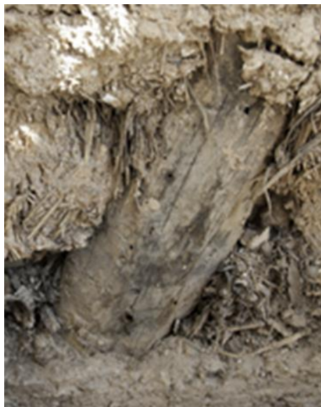
Detalle del muro de entramado relleno de pallabarro en una vivienda en Ourense. 2016 (Fernández Palicio)
