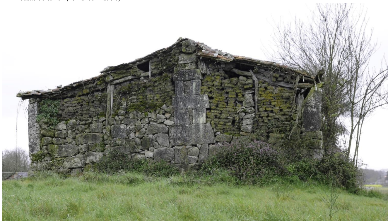
Construcción de terrones en Cardeita, Concello de Sandiás. 2013 (Fernández Palicio)
