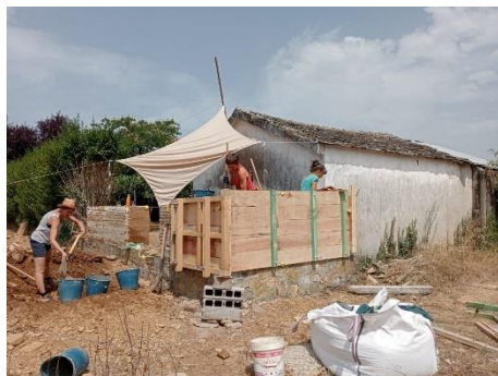
Taller de construcción con tapia en A Pobra do Brollón. 2025 (Fernández Palicio)
