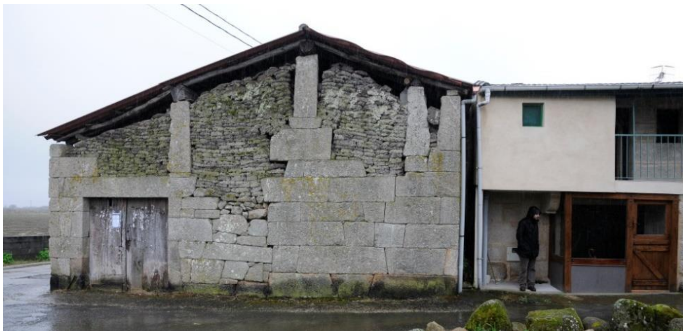
Muro de terrones tipo 3 con basamento de grandes piedras y estructura de pilares. Lavandeira, parroquia de Piñeiro de Arcos, Concello de Sandiás. 2013 (Fernández Palicio)
