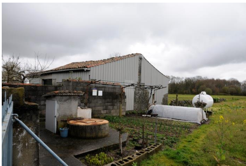
Muro de terrones cubierto de planchas metálicas. A Chousela, parroquia de Piñeiro de Arcos, Concello de Sandiás. 2013. (Fernández Palicio)
