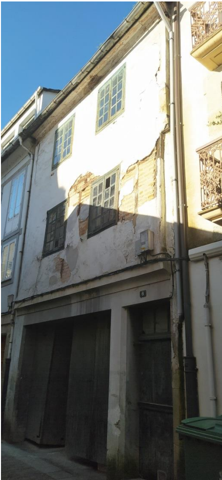
Vivienda de entramado de madera y ladrillo con la planta baja modificada en la rúa de Guevara. 2019 y 2021. (Fernández Palicio)
