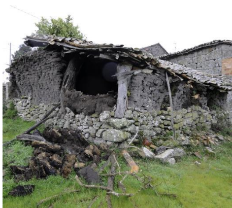
Construcción de terrones en ruina en Cardeita, Concello de Sandiás. 2013 (Fernández Palicio)
