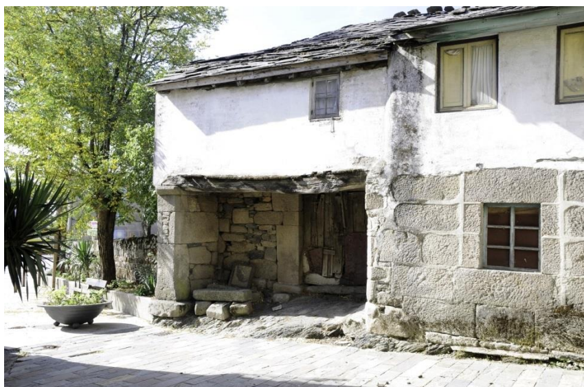
Vivienda de tipología medieval con planta baja de piedra y sobrado de entramado de madera en el núcleo de A Gudiña (este de Ourense), situado en la ruta de Santiago hacia el sur. 2020 (Fernández Palicio)
