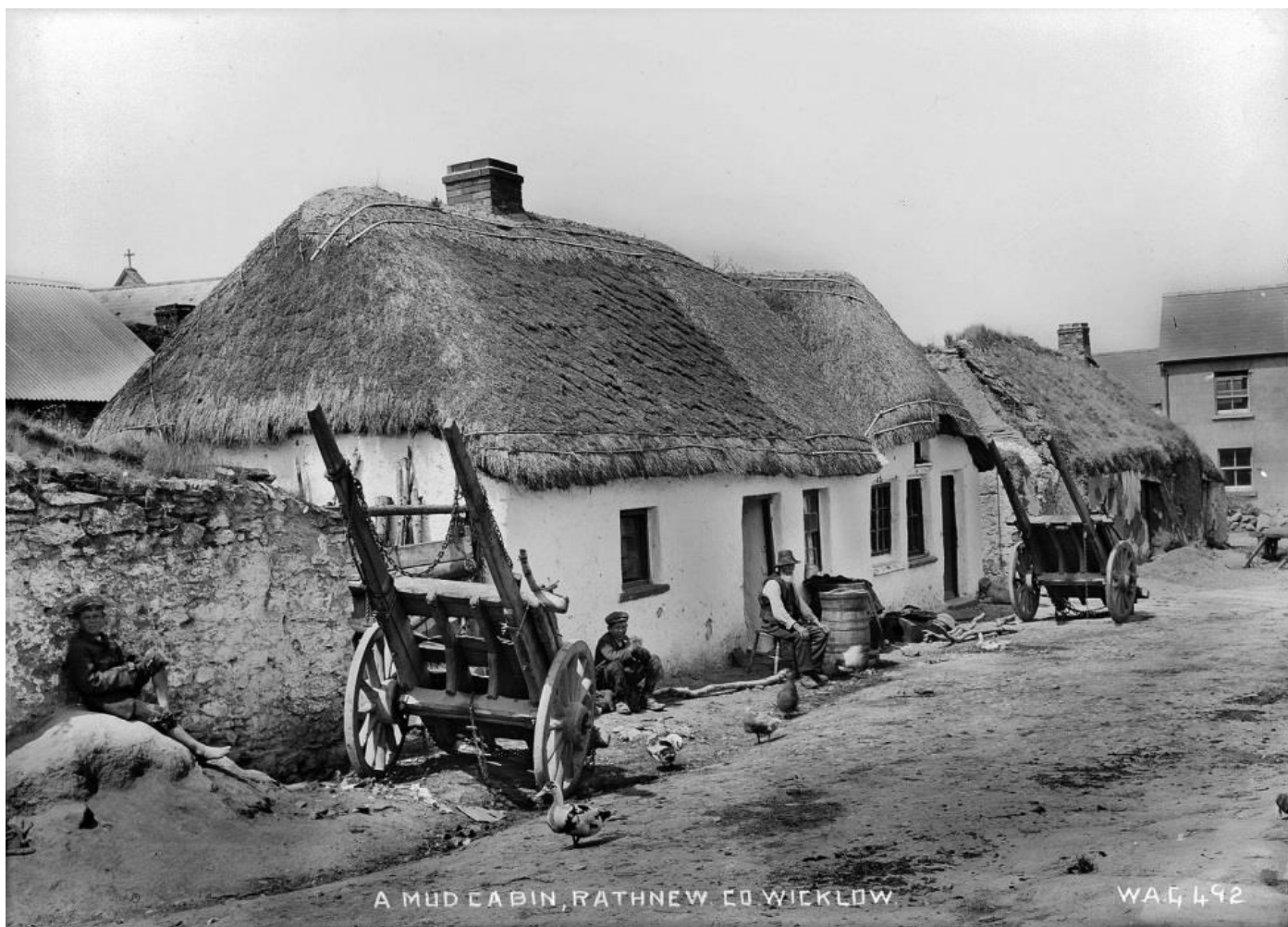
Vivienda tradicional irlandesa realizada con con muros de terrones. ( https://collections.nationalmuseumsni.org/ Último acceso 21/09/2025)
