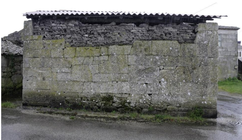
Muro de terrones tipo 3 con basamento de grandes piedras y estructura de pilares. Lavandeira, parroquia de Piñeiro de Arcos, Concello de Sandiás. 2013 (Fernández Palicio)
