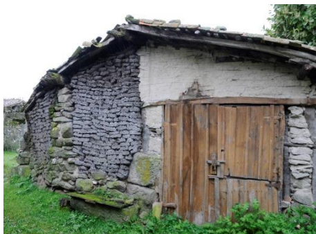
Construcción de terrones en Cardeita, Concello de Sandiás. 2013 (Fernández Palicio)
