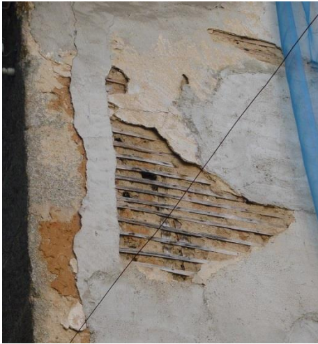
Detalle del muro de entramado 2016. (Fernández Palicio)
