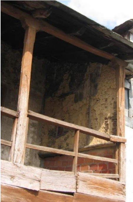
Detalle de un tabique cestado en Río Seco. (Monforte de Lemos). 2010 (Fernández Palicio)
