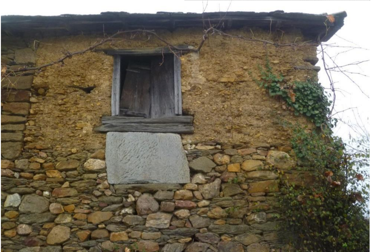
Bocetos y fotografías de construcción de tapia en Ribela, parroquia de Sindrán, Concello de Monforte de Lemos. 2011 (Fernández Palicio)
