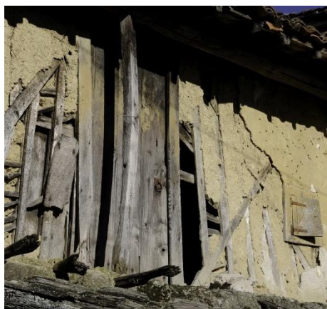
Detalle de un tabique de pallbarro en Vixueses (Maceda). 2013 (Fernández Palicio)
