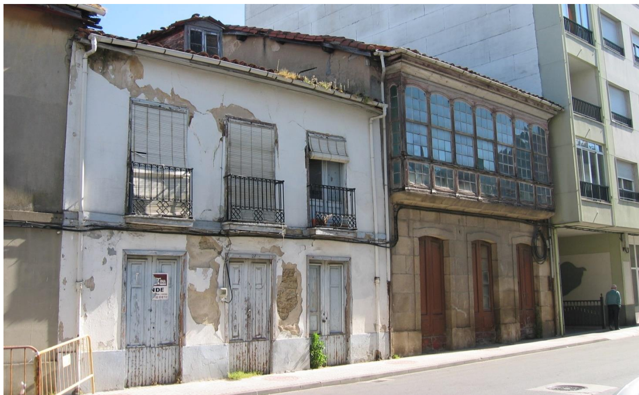
Viviendas de tapia con fachadas urbanas 2010. (Fernández Palicio)
