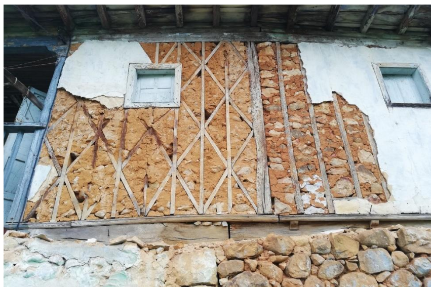
Entramado de madera relleno de piedra y tierra en el oriente de Asturias. 2023 (Fernández Palicio)
