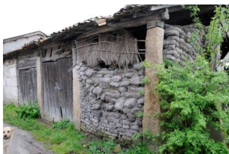
Muro de terróns tipo arcaico, sin basamento, estructura sobre pilares de pedra de gra y cuberta de teja del país. Lavandeira. 2013. (Fernández Palicio)
