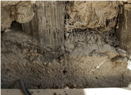
Detalle de la estructura de un muro de muro de entramado 2017. (Fernández Palicio)
