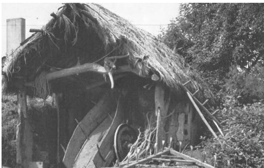
Construcción auxiliar en Sa de Abaixo (A Coruña) (Flores, 1973)
