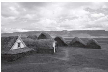
Granja construída con terrones en Islandia (Wilkinson, 2009)
