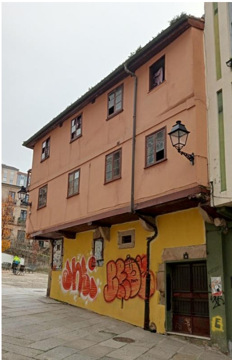
Vivienda de entramado de madera con las plantas superiores voladas. 2024. (Fernández Palicio)
