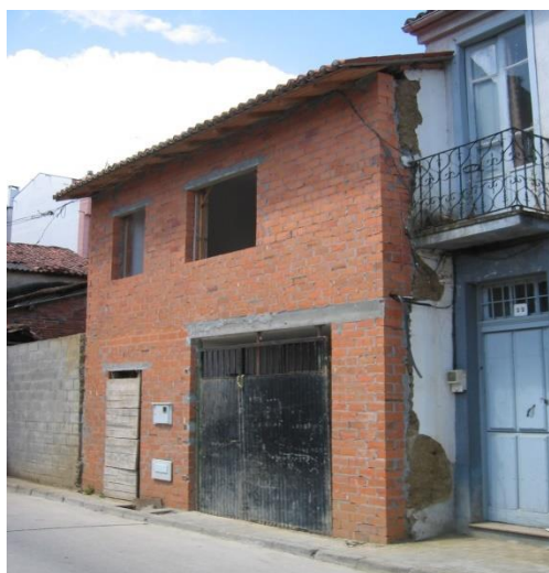
Tratamiento habitual de una tapia en la zona urbana de Monforte de Lemos ocultándola mediante la nueva fachada 2012. (Fernández Palicio)
