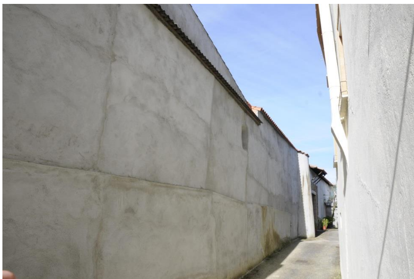
Tapia del Mosteiro das Clarisas revocada con cemento. 2013 (Fernández Palicio)
