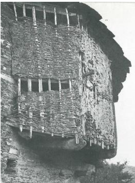
Tabique cestado à Guadramil, (Tras-Os Montes) (Veiga de Oliveira, Galhano & Pereira, 1969)
