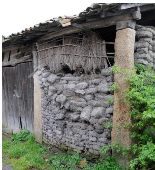
Uno de los pocos ejemplos existentes que muestran el antiguo uso del bion ( Scirpus Lacustris ) en cerramientos o cubiertas. A Limia, 2013 (Fernández Palicio)
