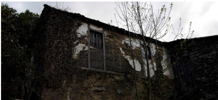
Vivienda de entramado en Barrio, Cristosende, A Teixeira. 2016. (Fernández Palicio)
