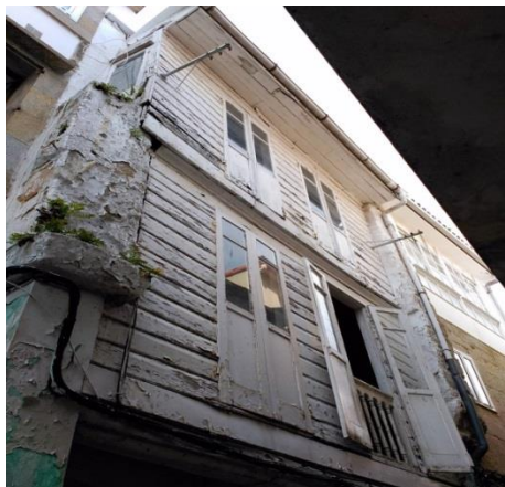
Vivienda de entramado en Muros. 2018 (Fernández Palicio)
