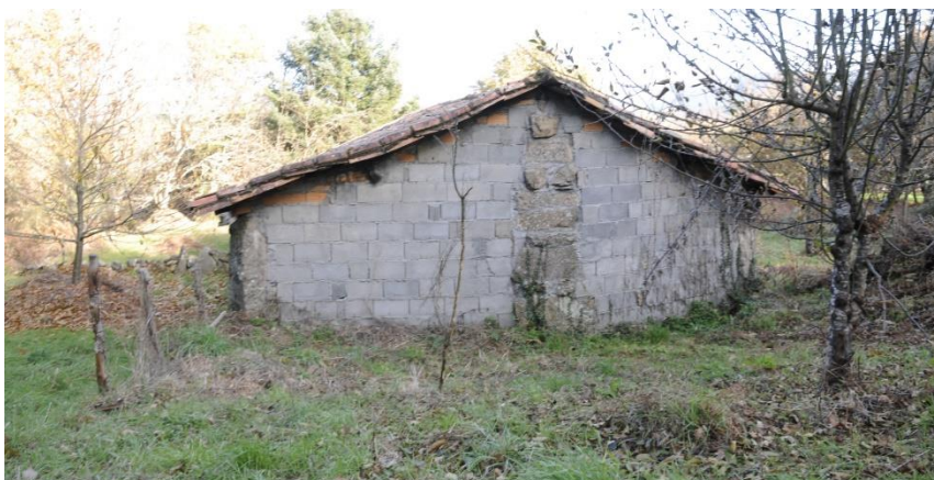
Ejemplo de construcción auxiliar en Cancillós, en el que puede apreciarse una estructura granítica similar a las estudiadas en ñas construcciones con terrones. (2013)
