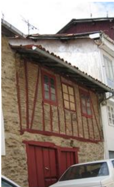
Viviendas de origen medieval de entramado de madera con relleno de ladrillos en Monforte de Lemos. La vivienda de la izquierda modificó los huecos de fachada en algún momento posterior. 2011. (Fernández Palicio)
