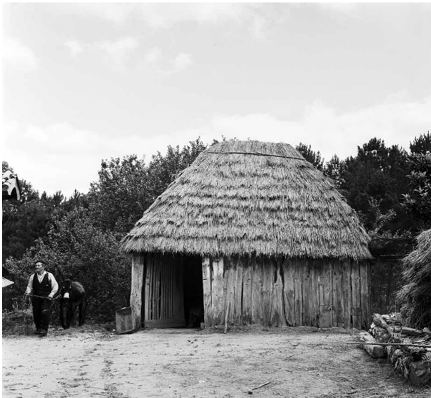
Construcción circular en 1968 en Oza dos Ríos (A Coruña) de tablas y cubierta vegetal (Carlos Flores, 2017)
