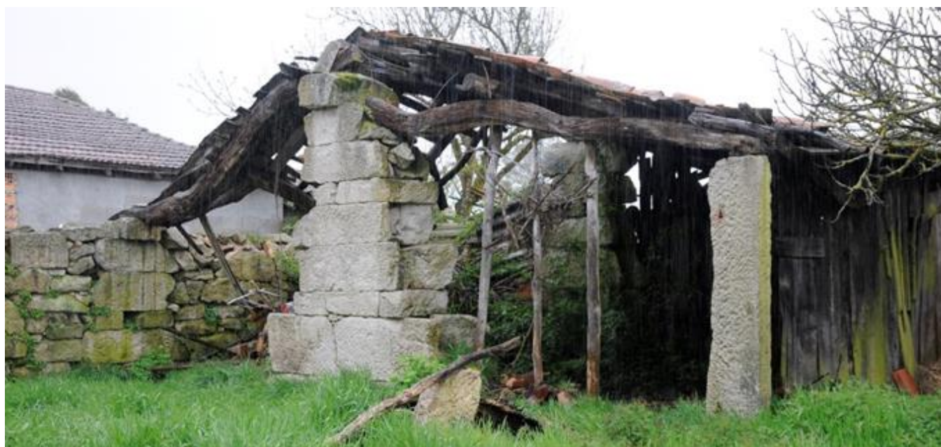
Muro de terróns tipo arcaico, sin basamento, estructura sobre pilares de piedra de granito. Lavandeira. 2013. (Fernández Palicio)
