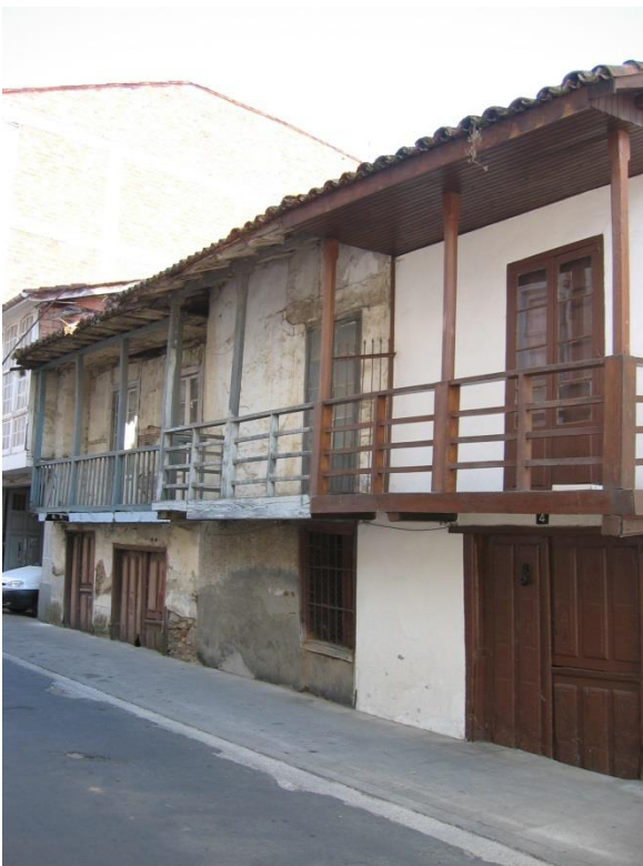
Viviendas con estrutura de rueiro en el arrabal de Abeledos: tapias como paredes medianeras 2010. (Fernández Palicio)
