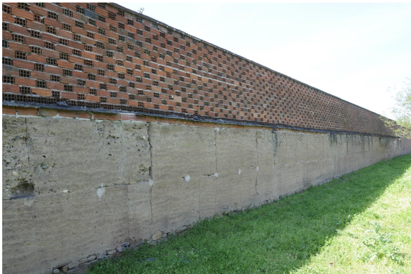
Muro e tapia del Mosteiro das Clarisas con adición de ladrillo.2013 (Fernández Palicio)
