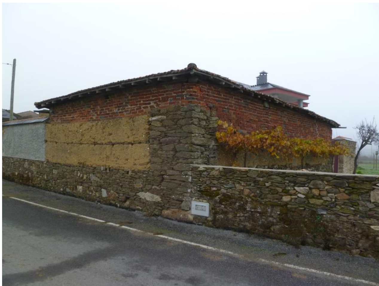
Evolución de materiales en una construcción en Monforte. 2011 (Fernández Palicio). La llegada del ladrillo a principios del siglo XX se integró en la construcción tradicional
