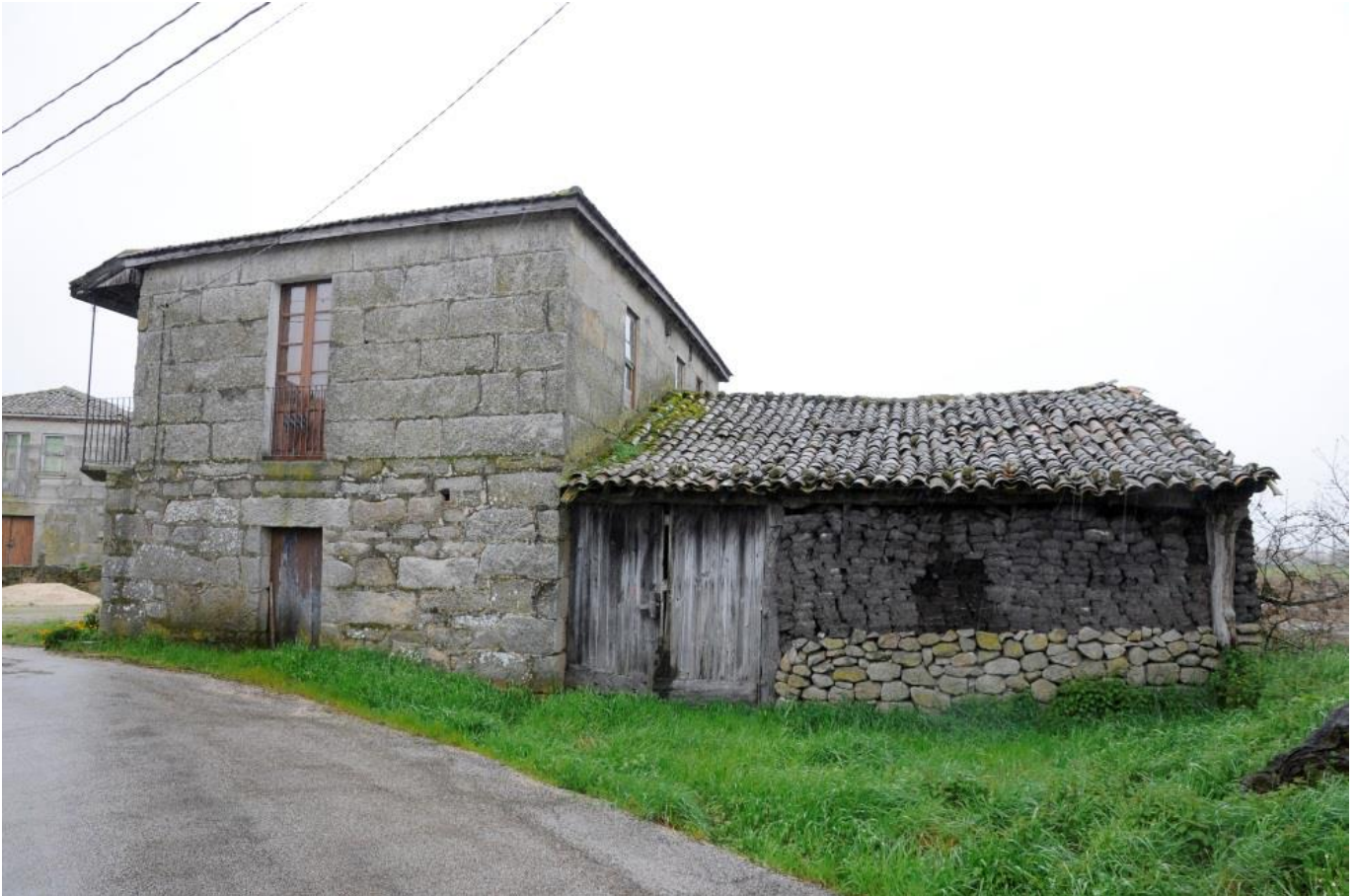
Muro de terrones con basamento de cachotería y pilares de madera. Lavandeira, parroquia de Piñeiro de Arcos, Concello de Sandiás. 2013. (Fernández Palicio)
