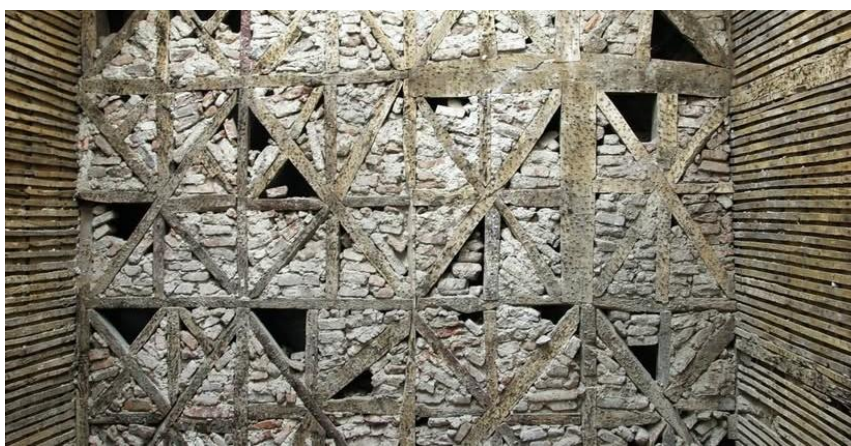
Tabique de fasquio en Guimaraes. ( https://www.facebook.com/Municipio.Guimaraes/posts/h%C3%A1-dois-dias-mostramos-a-taipa-de-fasquio-uma-t%C3%A9cnica-construtiva-tradicional/845337207789156/ ) Último acceso: 2025/10/12
