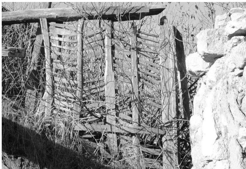
Estructura del entramado de vivienda en Vixueses (Maceda) 2012 (Fernández Palicio)
