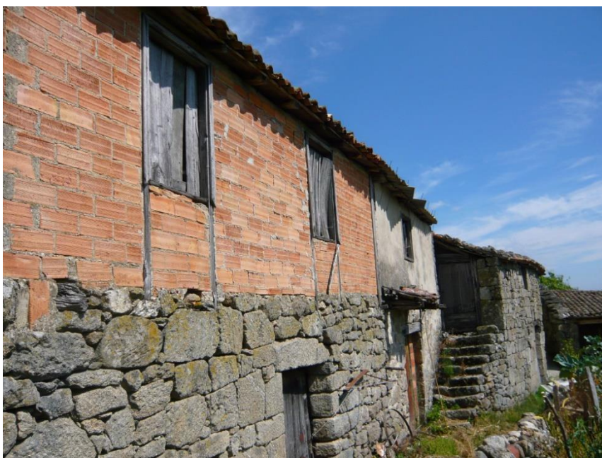
Sustitución de muro de entramado de pallabarro por uno de ladrillo. San Lourenzo. Parada de Sil. 2015. (Fernández Palicio)
