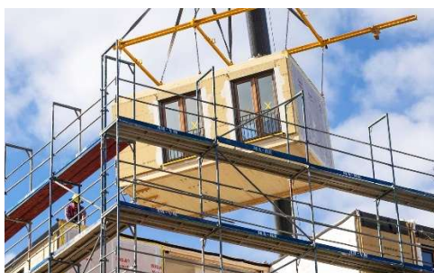
Figura 7. Construcción industrializada. 2023. Fuente: retokommerling.com
