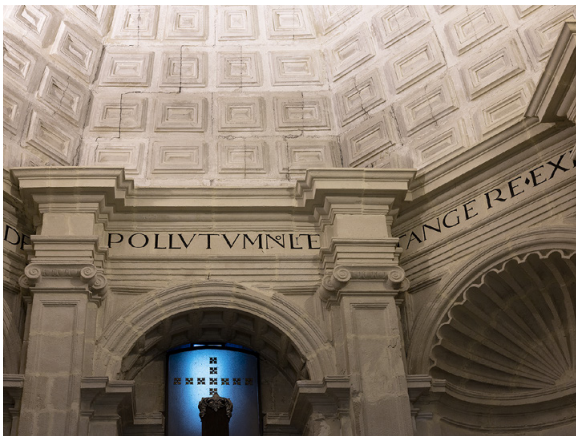
Figura 3. Paramentos interiores en la sacristía vieja de la iglesia de Santiago de Jumilla. Fuente: el autor.
