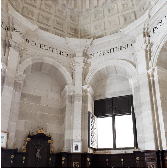
Figura 2. Paramentos interiores de la sacristía de la iglesia de Santiago de Orihuela. Fuente: el autor.
