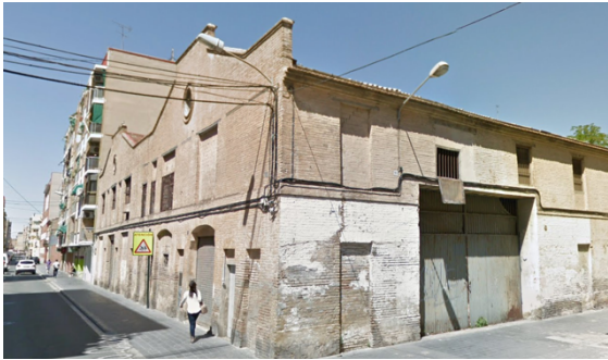
Fig. 59 Naves industriales estado actual
