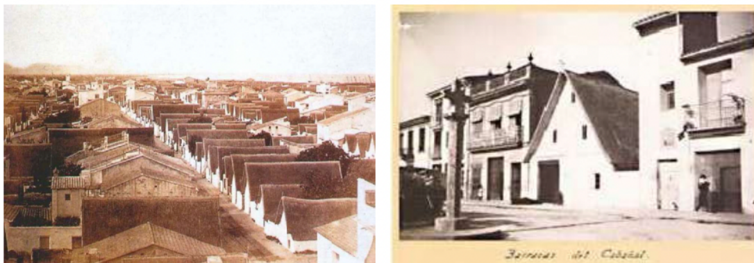
Fig.2 Calle primitiva formada por la alineación de cabañas y posterior sustitución gradual.
