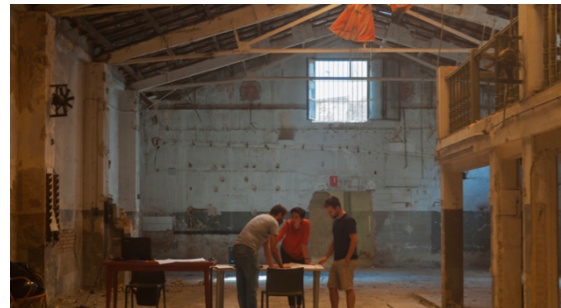
Fig.18. Estado previo a la rehabilitación.
