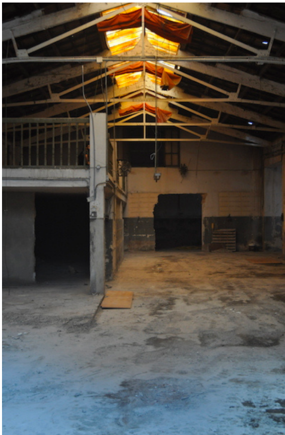
Fig.17. Estado previo a la rehabilitación.
