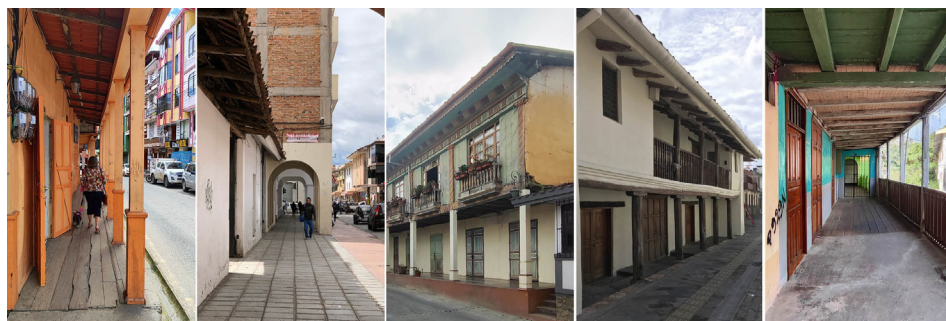
Fig. 2 Soportales según su relación con la acera: a) Soportal con acera adentro, Zaruma, b) Soportal con acera afuera, Cuenca, c) Soportal elevado, Zaruma, d) Soportal hundido, Cuenca, e) Soportal cerrado, Zaruma. Fuente: a), c), d), e) José Luis Vega y Soledad Vega, b) Martín Durán
