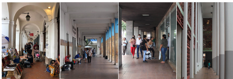
Fig. 4 Soportales según su cubierta: a) Soportal arqueado, Cuenca, b) Soportal con vigas vistas, Guayaquil, c) Soportal plano, Guayaquil, d) Soportal con doble altura, Guayaquil. Fuente: a) Martín Durán, b) - d) Josselyn Zambrano
