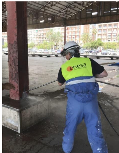
Figura 19. Chorro de agua a presión alta (Waterjetting). 2025. Fuente: Enesa Continental.
