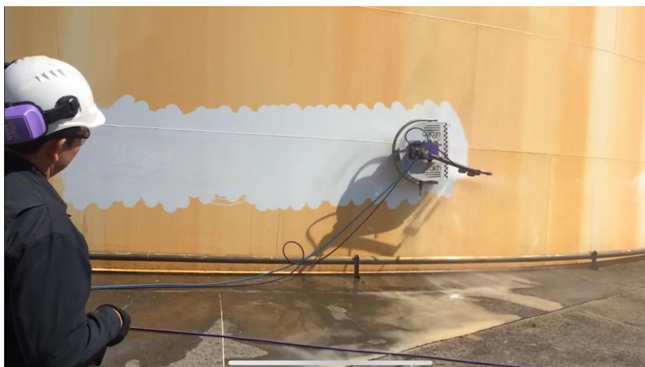
Figura 24. Equipo robotizado (Blastrac), granallado vertical. 2025. Fuente: Enesa Continental.
