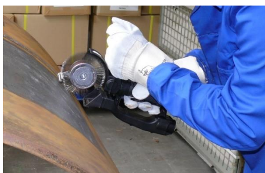
Figura 17. Limpieza mecánica con cepillo de alambre rotativo. 2025. Fuente: www.wikipedia.org/wiki/Bristle_blasting#/media/File:BristleBlasting.JPG
