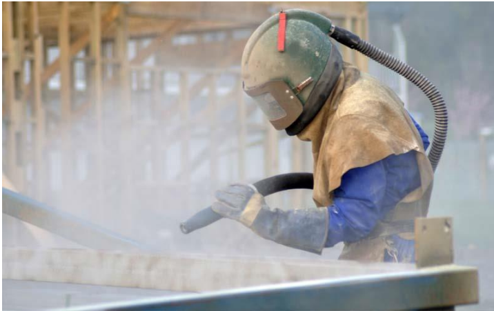
Figura 21. Limpieza con Sponge-jet. 2025. Fuente: www.soltgn.com
