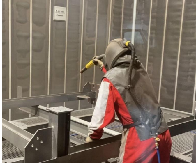
Figura 18. Limpieza con chorro abrasivo en cabina semiautomática (blasting). 2025. Fuente: Enesa Continental.
