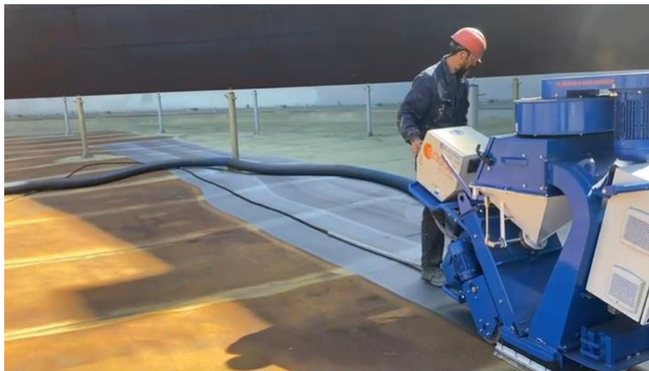
Figura 23. Equipo robotizado (Blastrac), granallado horizontal. 2025. Fuente: Enesa Continental.
