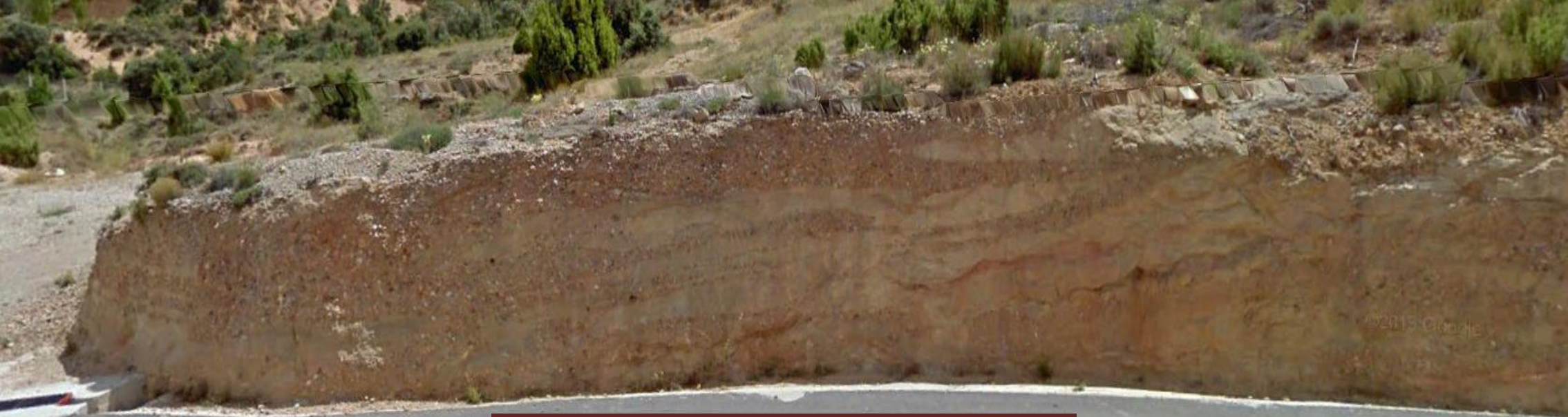
Talud en los conglomerados, areniscas y arcillas del Oligoceno-Mioceno, Terciario. NW de Todolella, Castellón. NE Hoja de Forcall
