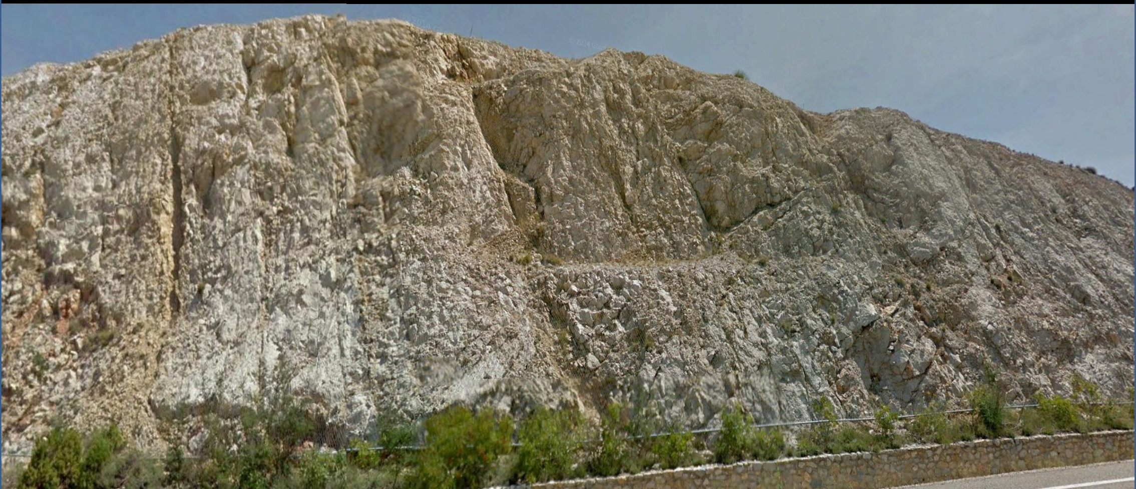
Margocalizas y margas, del Bedouliense, Cretácico Inf., intensamente diaclasadas, con mallazo. NE de Morella. NW Hoja.
