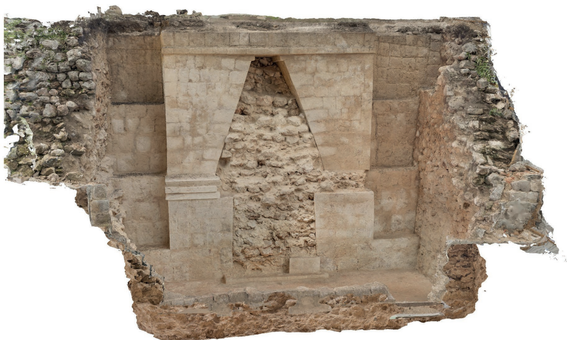
Subestructura - fachada este
