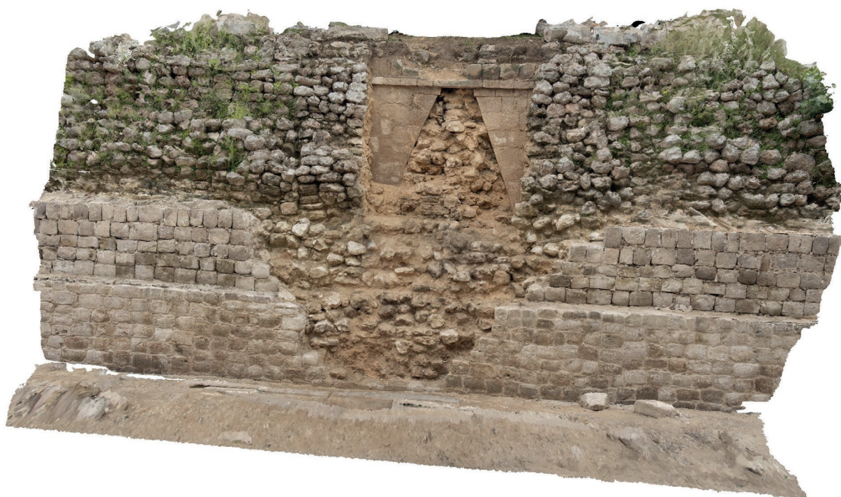
Subestructura - fachada oeste
