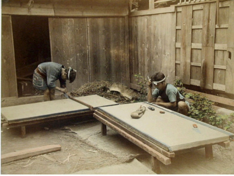
Fig. 4.27_ Fotografía. Fabricación. Fuente: Depetris Denhlom, Leandro (2017)
