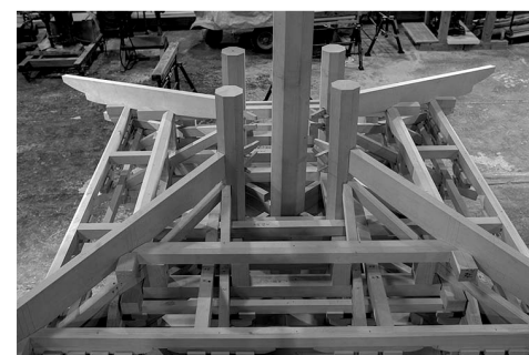
Fig. 6.02_ Fotografía. Las uniones shiguchi unen los pilares y las vigas que se van a encajar. Las piezas de madera que han sido cortadas con las medidas exactas, se encajan siguiendo complejos modelos de líneas y ángulos para crear fuertes estructuras de madera.
