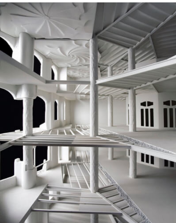
Fig. 5.03_ Fotografía. Maqueta La Pedrera: estructura de pilares de piedra y ladrillo.
