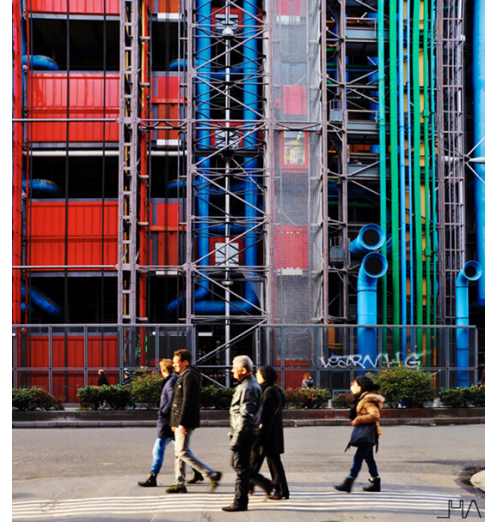
Fig. 7.18_ Imagen exterior. Instalaciones vistas en Centre Georges Pompidou / Renzo Piano + Richard Rogers. Fuente: Architectural Visits by Helena Ariza.
