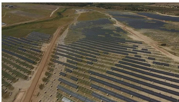
Figura 3.1. Planta fotovoltaica Núñez de Balboa
