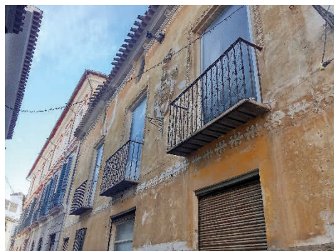
Fig. 5 – Façade of the Casa de las boticarias, Cehegin (Nezreg, 2024).
